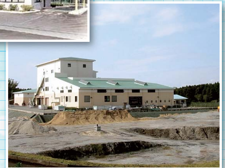
楽善埋立処分場
