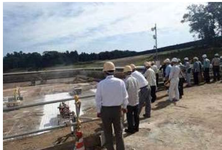
最終処分場の現場視察の様子
