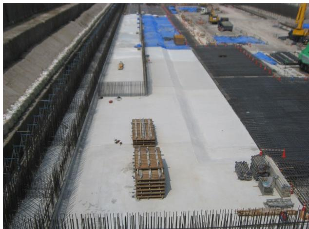
進捗に沿って耐圧盤のコンクリート打設を完了しています。
