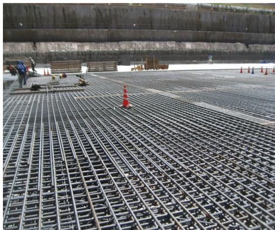
進捗に沿って耐圧盤の鉄筋組立作業を行っています。
