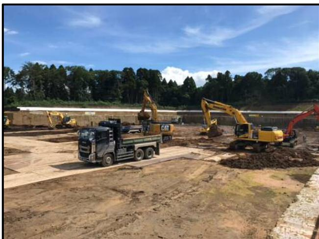
バックホーと10tダンプ車による掘削、運搬作業を行っています。
