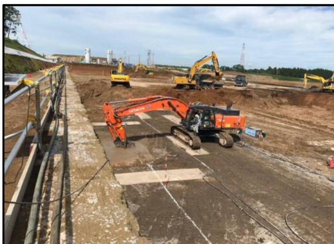
パワーブレンダー工法による法面对策工事を行っています。
