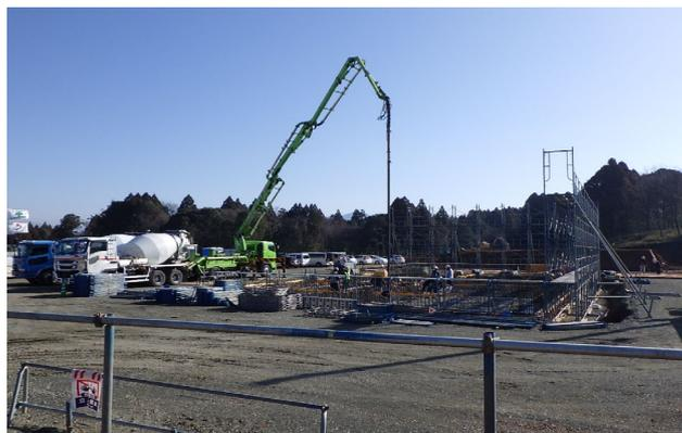
水槽部底盤のコンクリート打設工事を行っています。
