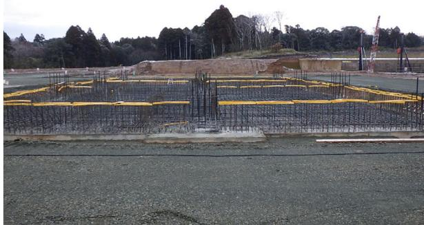
水槽部底盤の鉄筋組立工事を行っています。
