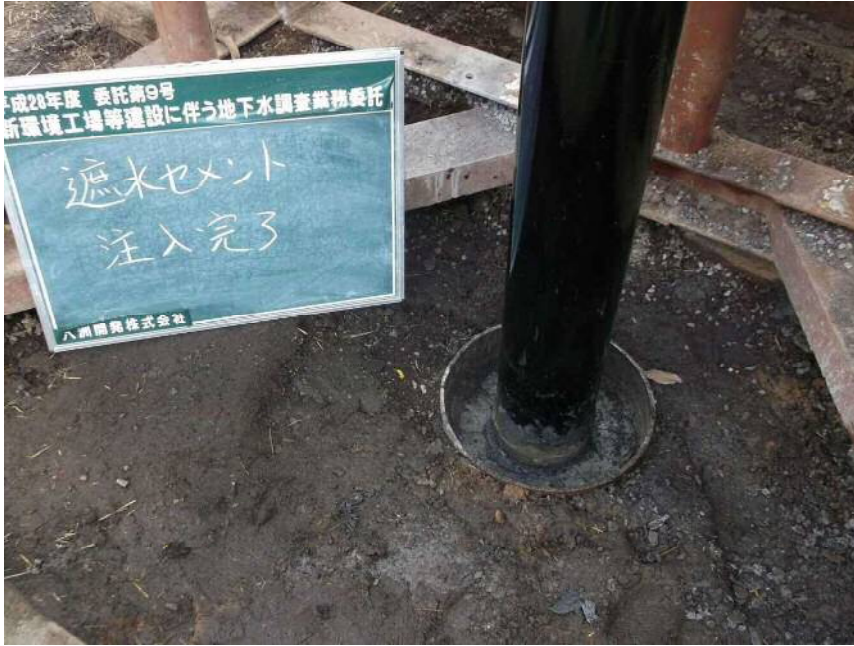
遮水セメント注入完了
