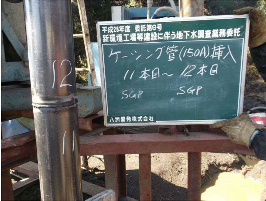
150Aケーシング管挿入 11本目~12本目 (SGP) (SGP)
