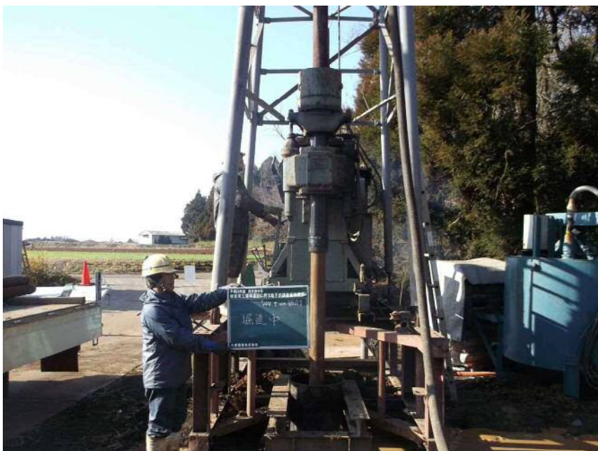
φ 444.5mm掘削 掘進中
