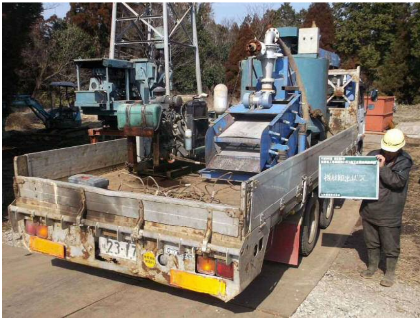
機材搬出状況
