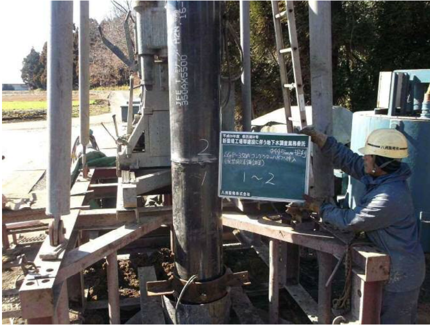
コンダクターパイプ挿入状況 1本目~2本目
