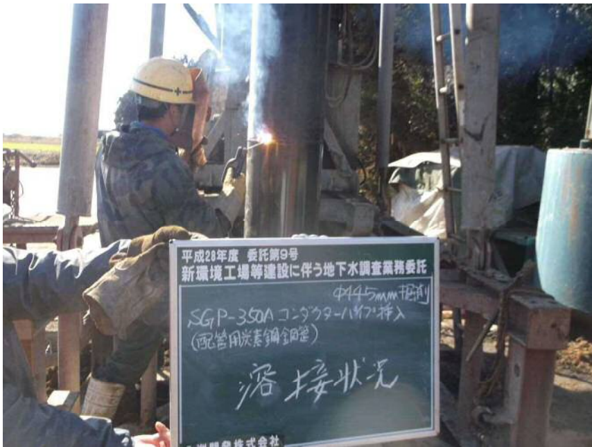
コンダクターパイプ挿入状況 溶接状況
