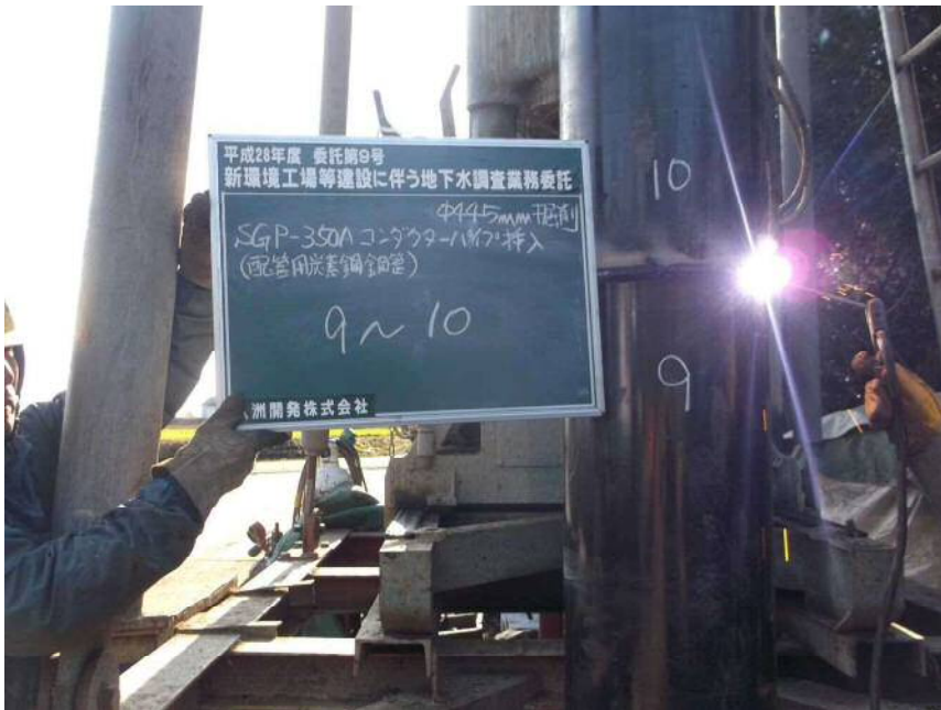
コンダクターパイプ挿入状況 9本目～10本目
