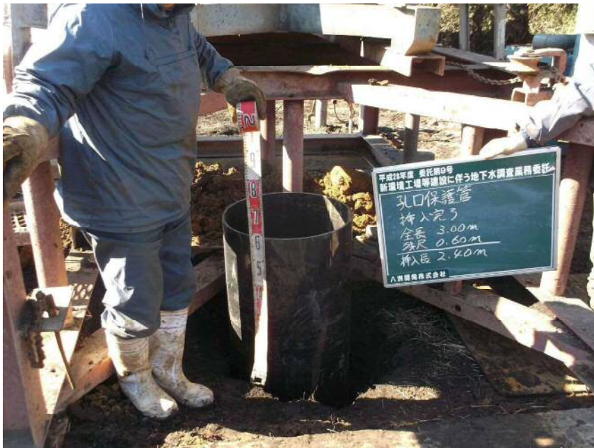
孔口保護管 挿入完了 全 長=3.00m 残 尺=0.60m 挿入長=2.40m
