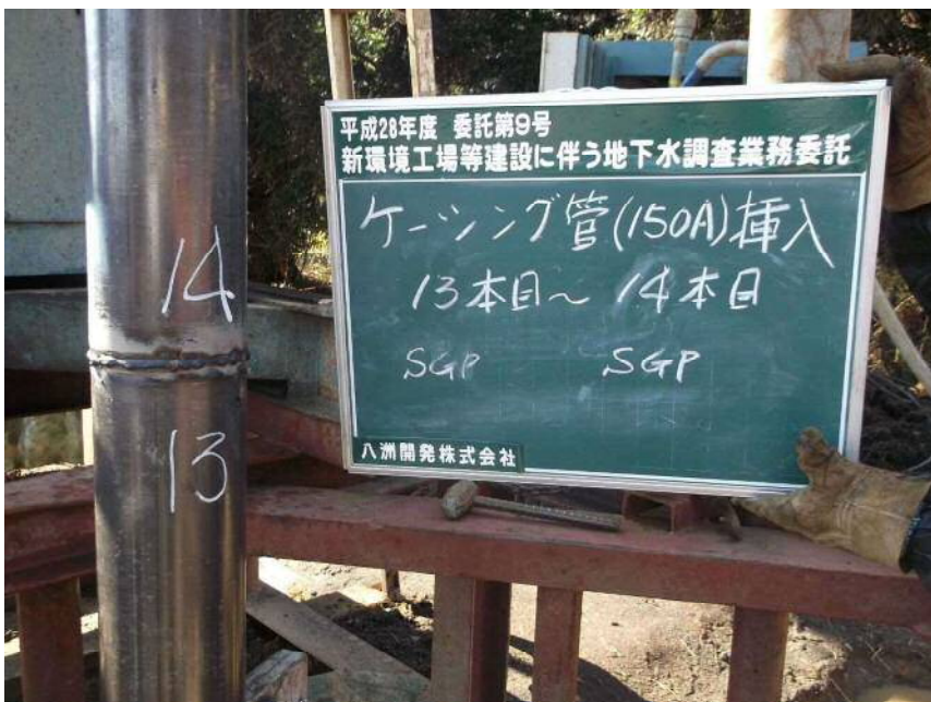
150Aケーシング管挿入 13本目~14本目 (SGP) (SGP)
