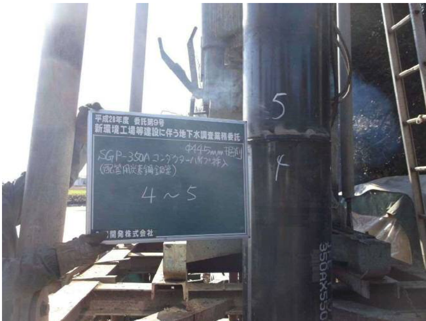
コンダクターパイプ挿入状況 4本目～5本目
