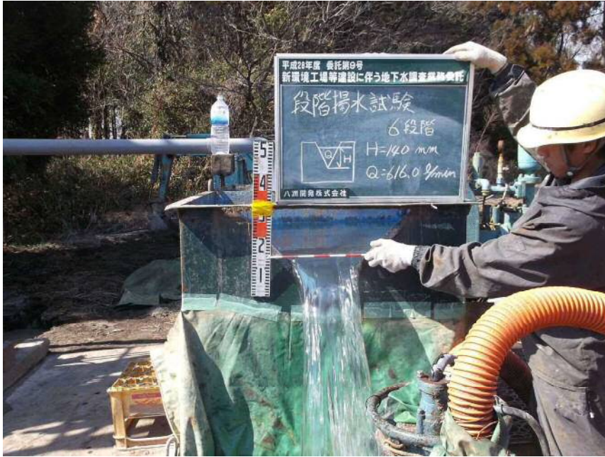
段階揚水試験
