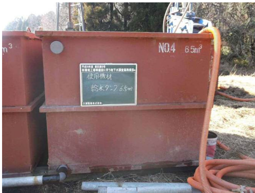
使用機材 給水タンク 6.5m 3
