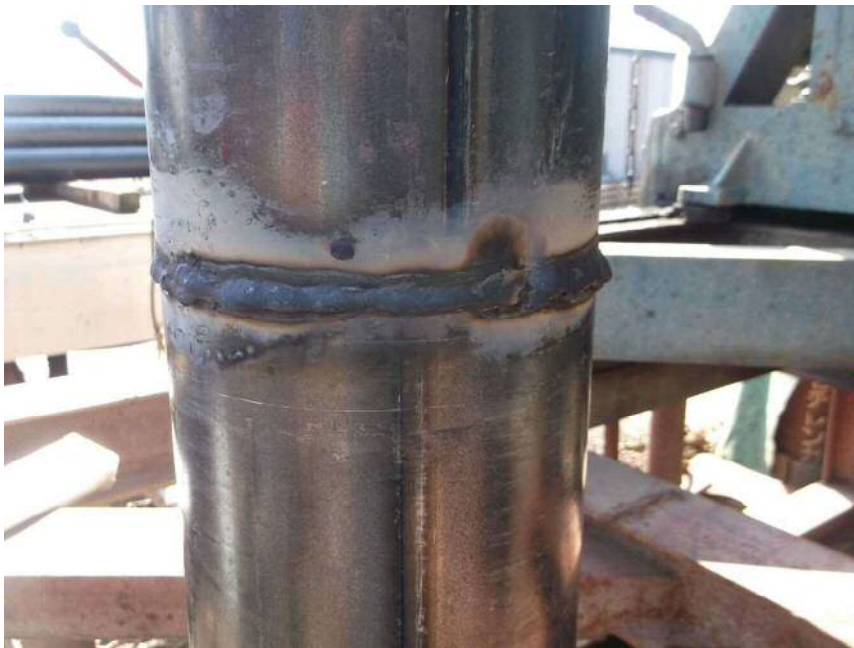
150Aケーシング管挿入 溶接状況
