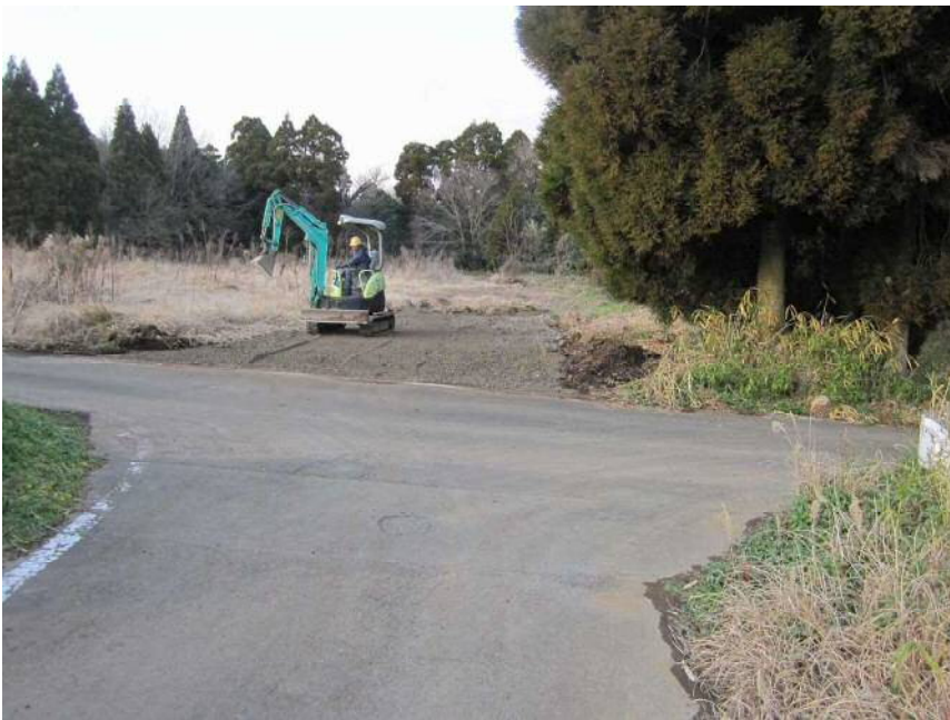
仮駐車場 仮設状況
