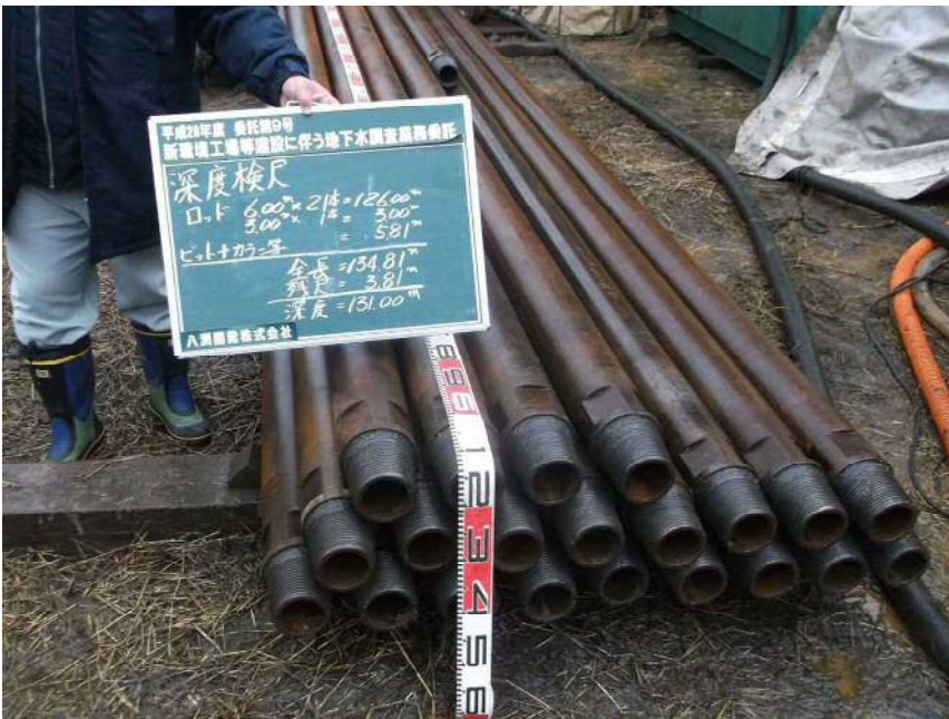
φ 311.2mm掘削 深度検尺(近景) 全長=134.81m 残尺= 3.81m 深度=131.00m
