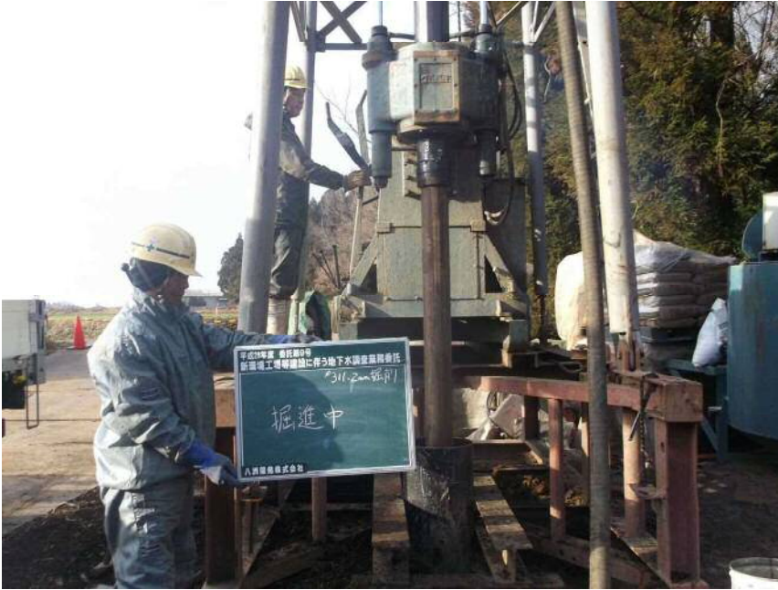
φ 311.2mm掘削 掘進中
