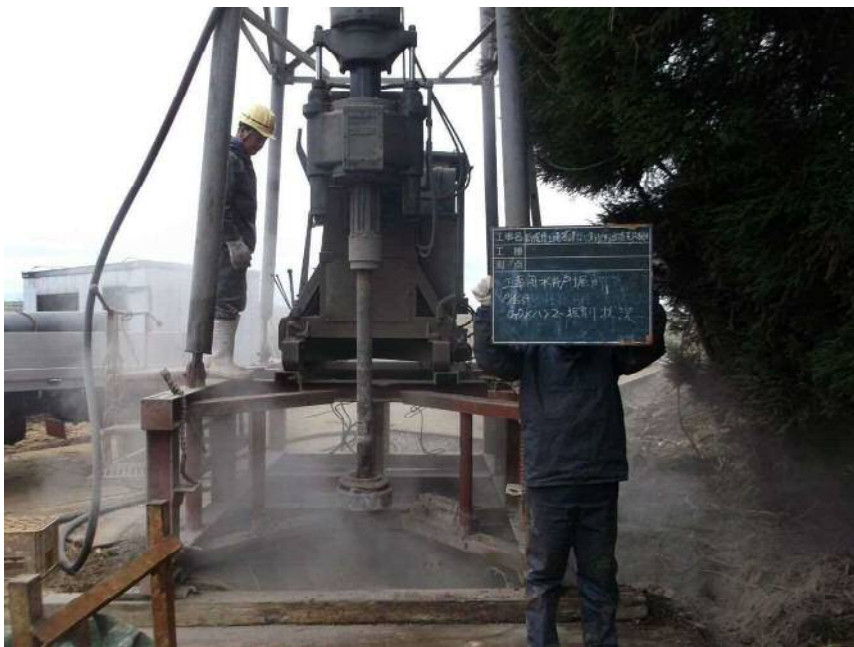
工事用水井戸掘削 φ165 ODXハンマー掘削状況
