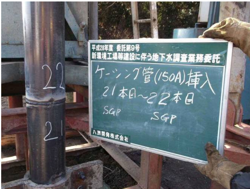
150Aケーシング管挿入 21本目~22本目 (SGP) (SGP)
