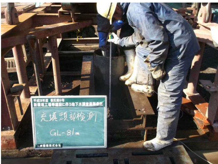
充填頭部検測 GL-81.00m
