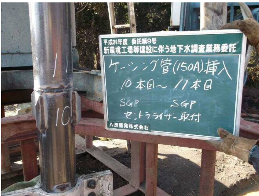
150Aケーシング管挿入 10本目~11本目 (SGP) (SGP) (セントラライザー取付)
