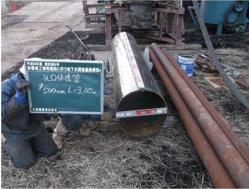
材料検収 孔口保護管 φ 500mm L=3.00m
