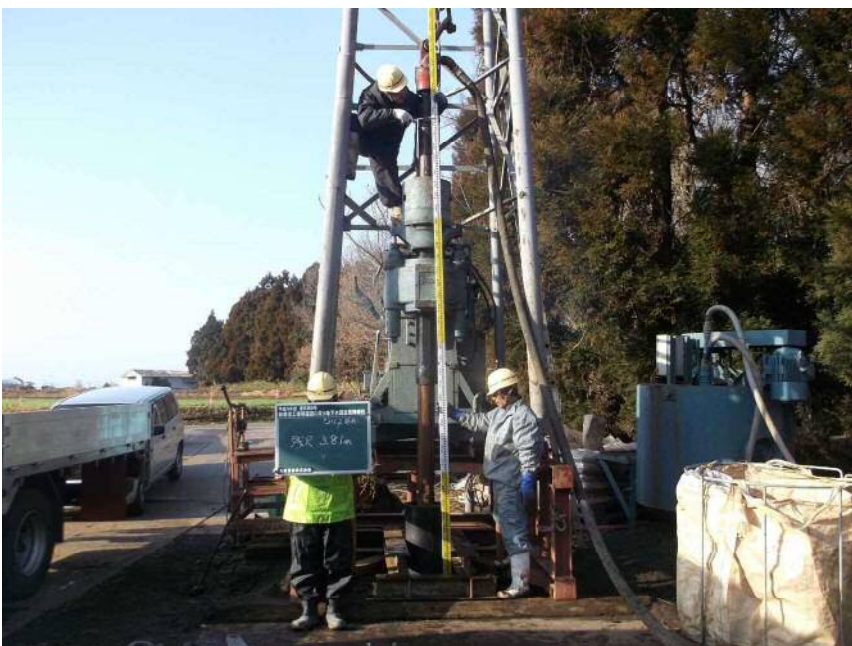
φ 311.2mm掘削 残尺(全景) L=3.81m
