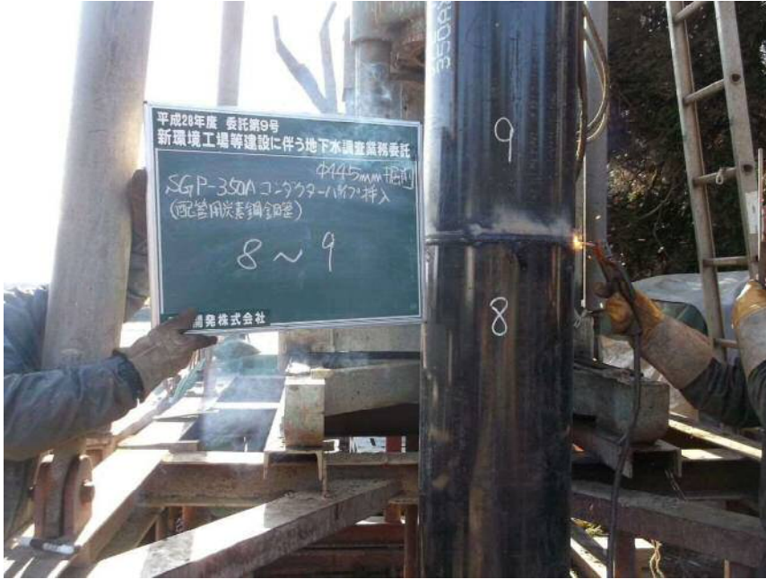
コンダクターパイプ挿入状況 8本目～9本目
