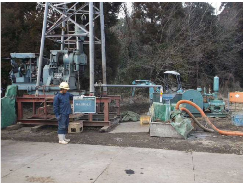
揚水試験 全景
