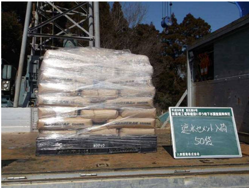
材料入荷 遮水セメント 50袋
