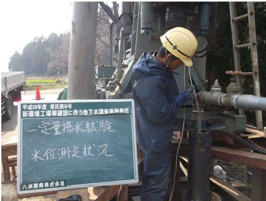
一定量揚水試験
