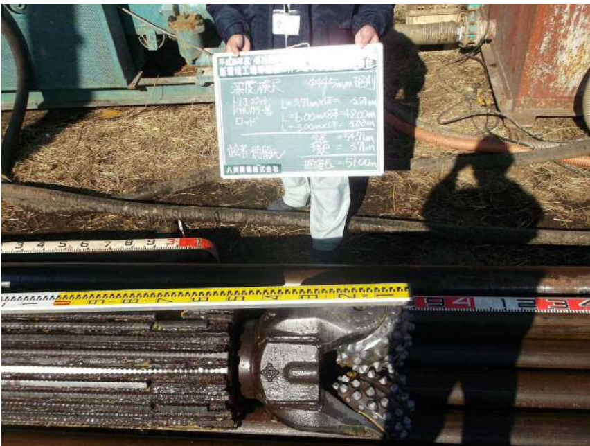
φ 444.5mm掘削 深度検尺(近景) 立会者:徳留氏 全長=54.71m 残尺 = 3.71m 深度=51.00m
