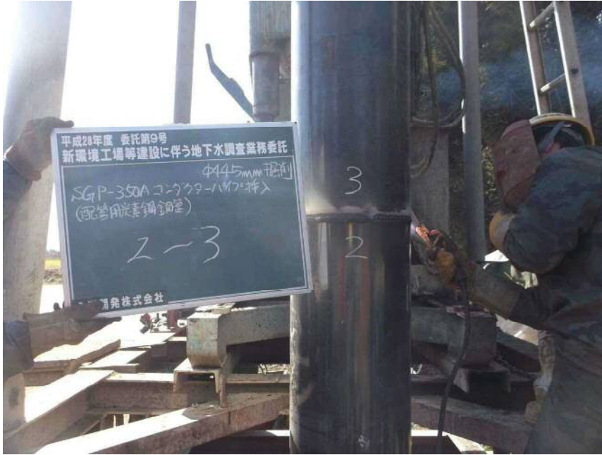
コンダクターパイプ挿入状況 2本目～3本目
