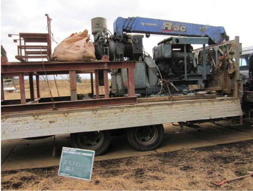
ボーリングマシン搬入状況
