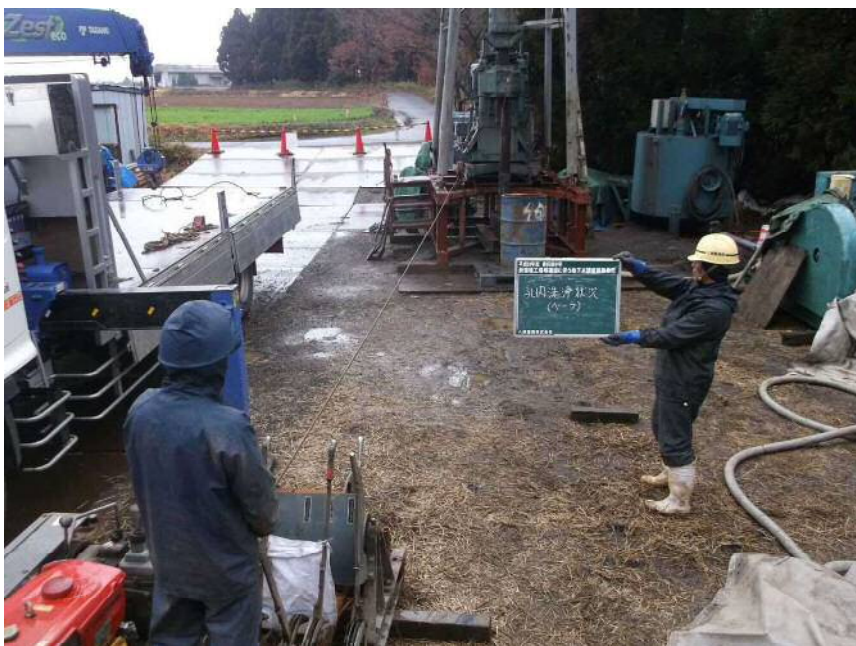
孔内洗浄状況 (ベアラ)
