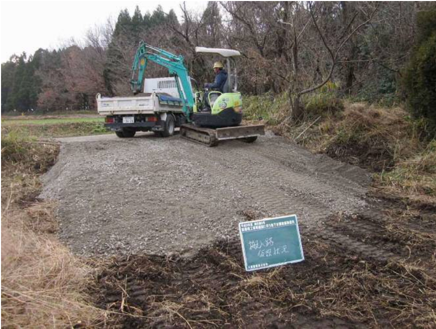
搬入路 仮設状況
