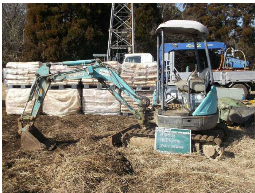
使用機材 油圧ショベル コベルコSK20SR
