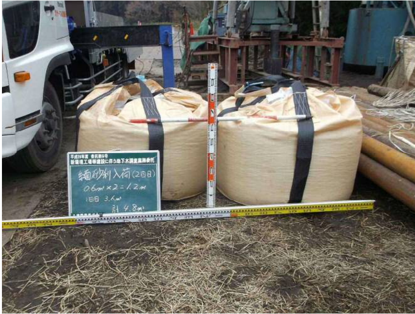
材料入荷 緬砂利(2回目) 0.6m 3 ×2=1.2m 3 計4.8m 3
