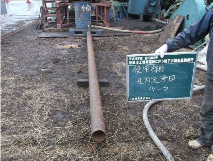
使用機材 孔内洗浄用ベーラ
