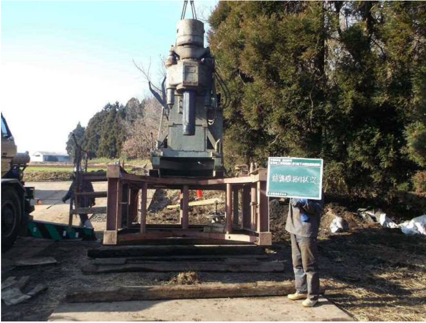
試錐機据付状況
