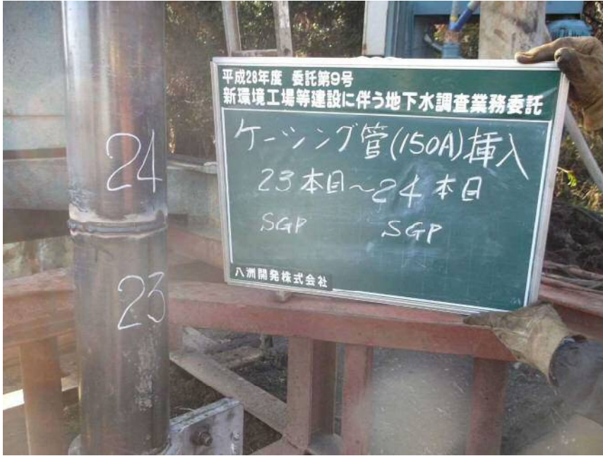
150Aケーシング管挿入 23本目~24本目 (SGP) (SGP)
