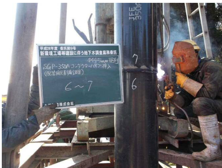
コンダクターパイプ挿入状況 6本目～7本目
