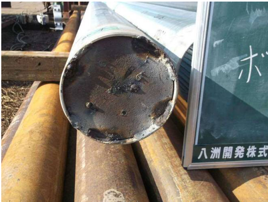
150Aケーシング管挿入 ボトム取付
