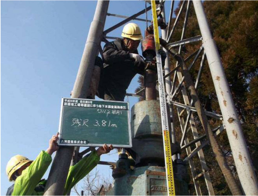
φ 311.2mm掘削 残尺(上端近景) L=3.81m
