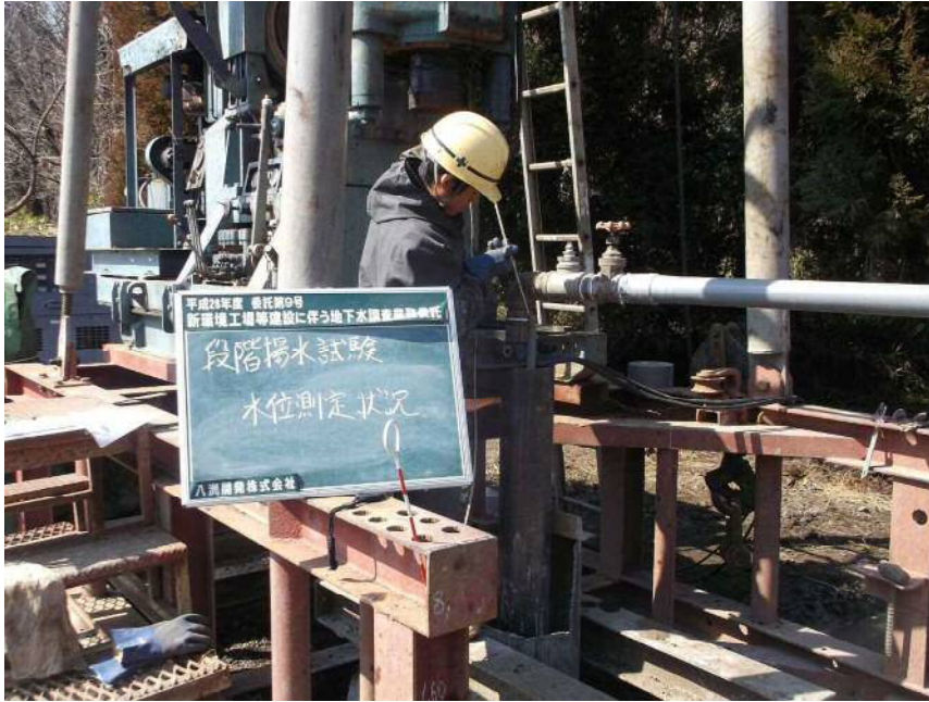
段階揚水試験 水位測定状況
