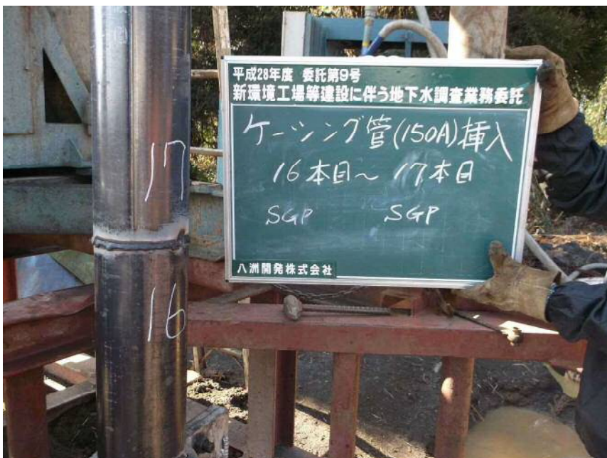
150Aケーシング管挿入 16本目~17本目 (SGP) (SGP)
