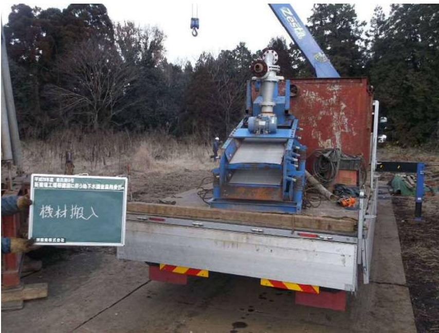
機材搬入状況
