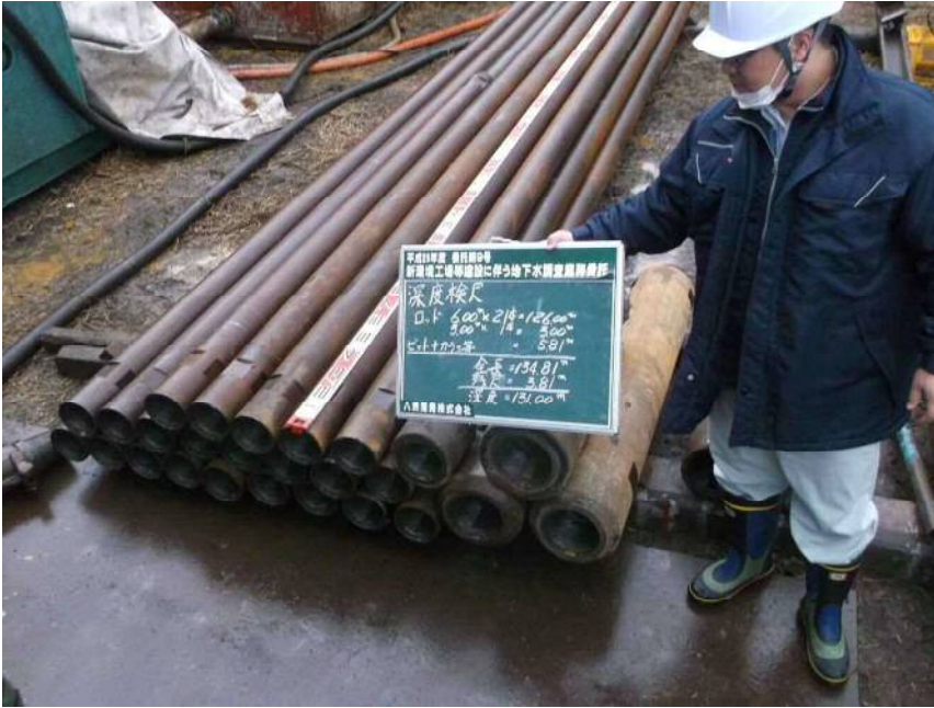
φ 311.2mm掘削 深度検尺(近景) 全長=134.81m 残尺= 3.81m 深度=131.00m
