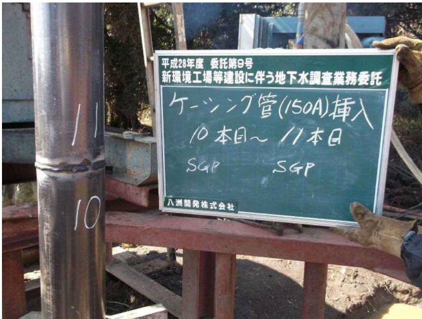
150Aケーシング管挿入 10本目~11本目 (SGP) (SGP)
