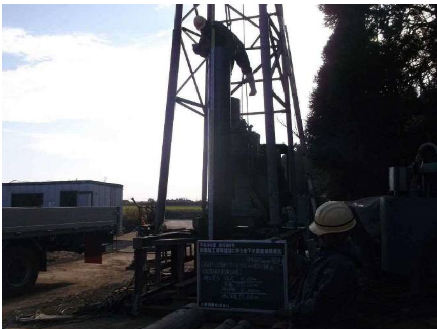
コンダクターパイプ挿入 挿入完了
