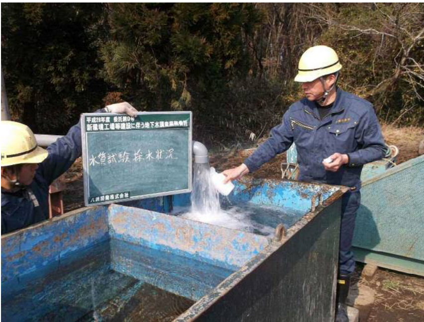
水質試験 採水状況
