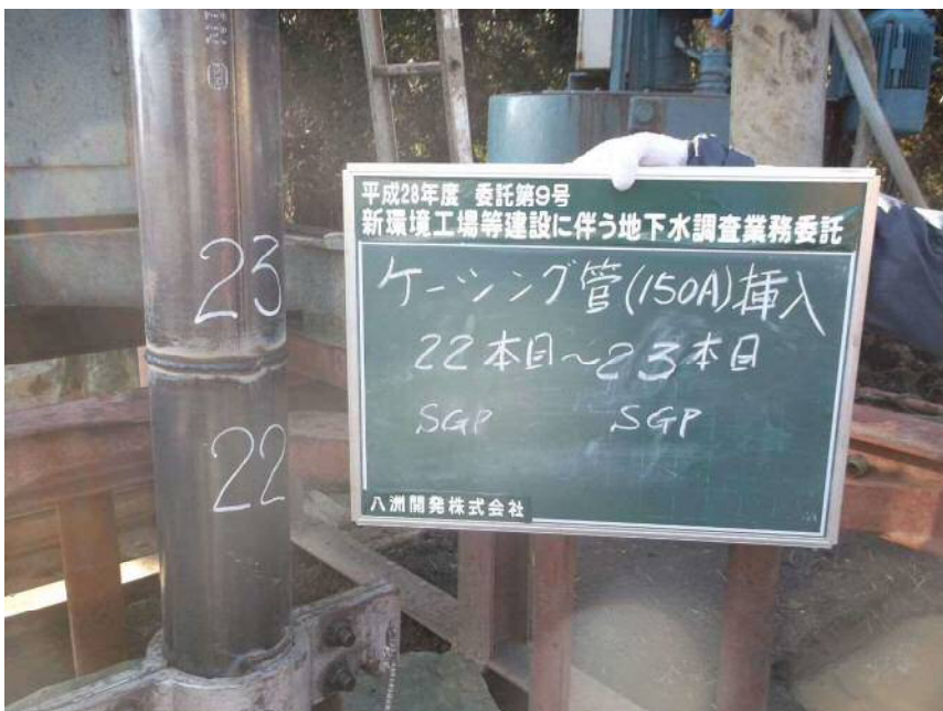
150Aケーシング管挿入 22本目~23本目 (SGP) (SGP)
