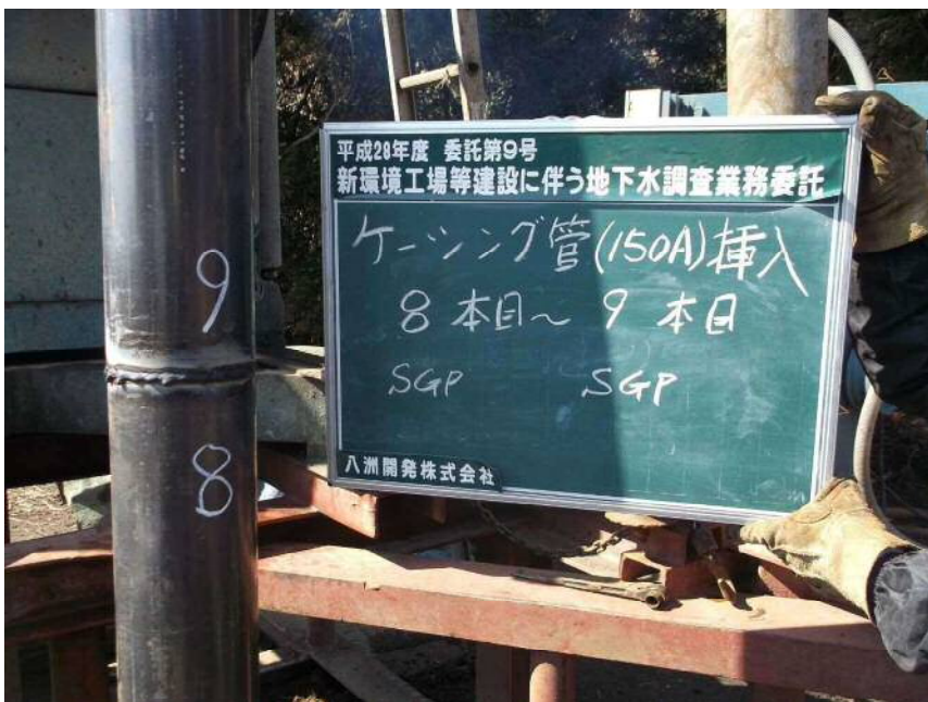
150Aケーシング管挿入 8本目~9本目 (SGP) (SGP)
