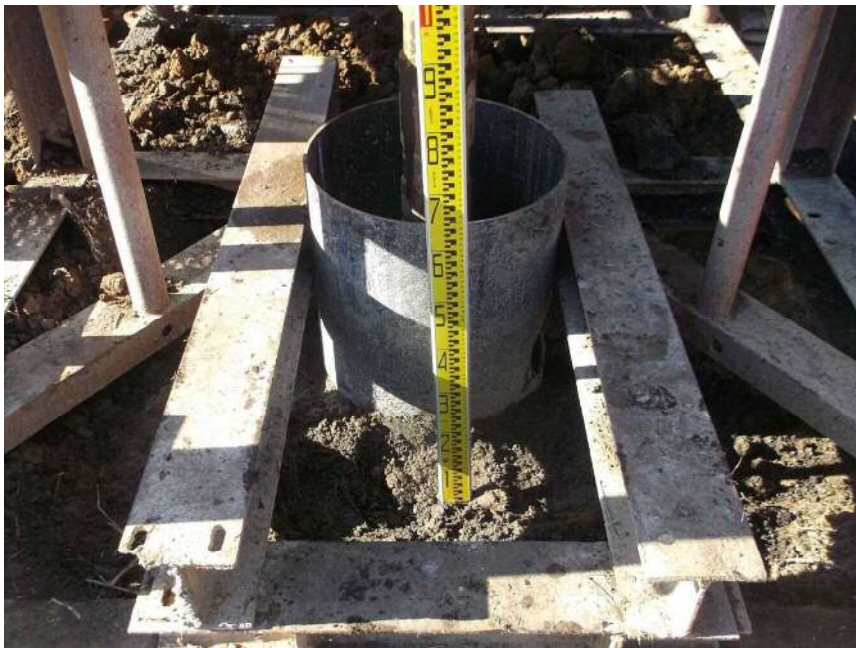
φ 444.5mm掘削 残尺(下端近景) L=3.71m 立会者:徳留氏
