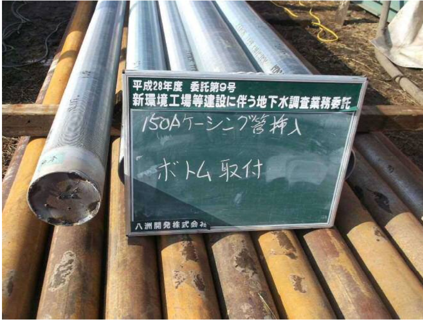
150Aケーシング管挿入 ボトム取付
