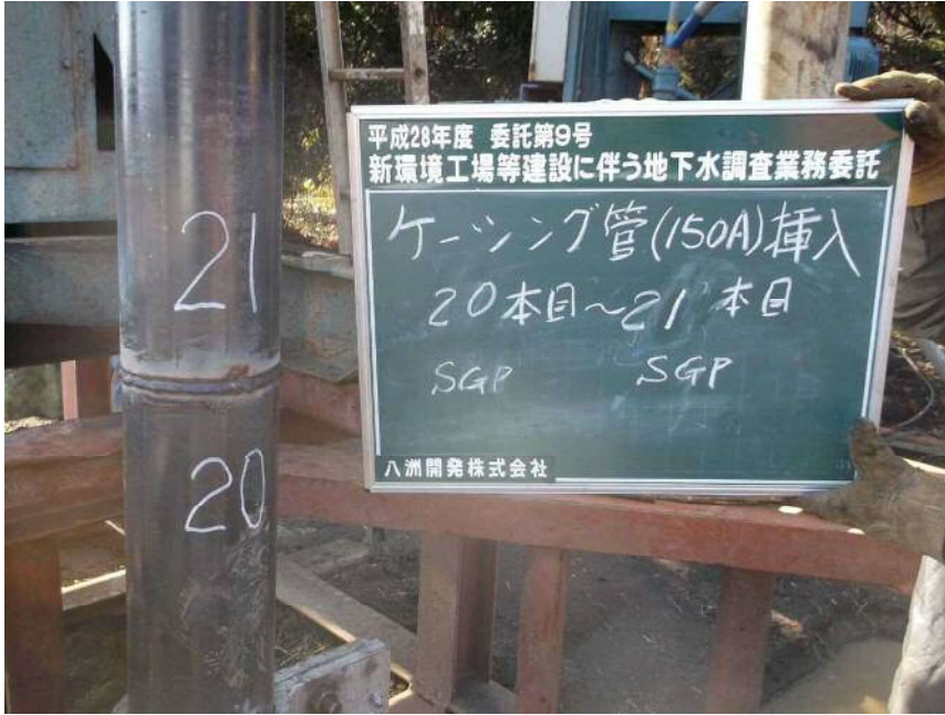
150Aケーシング管挿入 20本目~21本目 (SGP) (SGP)
