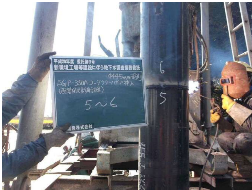
コンダクターパイプ挿入状況 5本目～6本目
