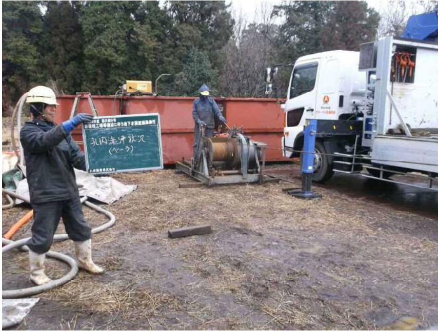
孔内洗浄状況 (ベアラ)
