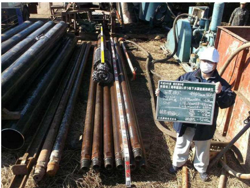
φ 444.5mm掘削 深度検尺(全景) 立会者:徳留氏 全長=54.71m 残尺= 3.71m 深度=51.00m
