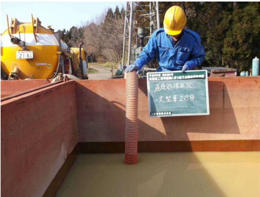
産廃処理 処理状況(大型車2台目)
