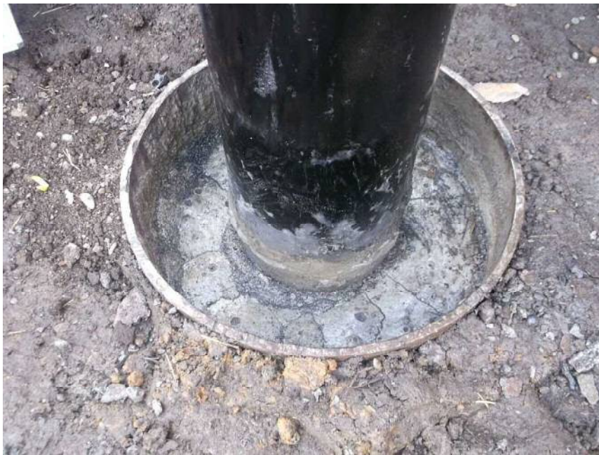
遮水セメント注入完了
