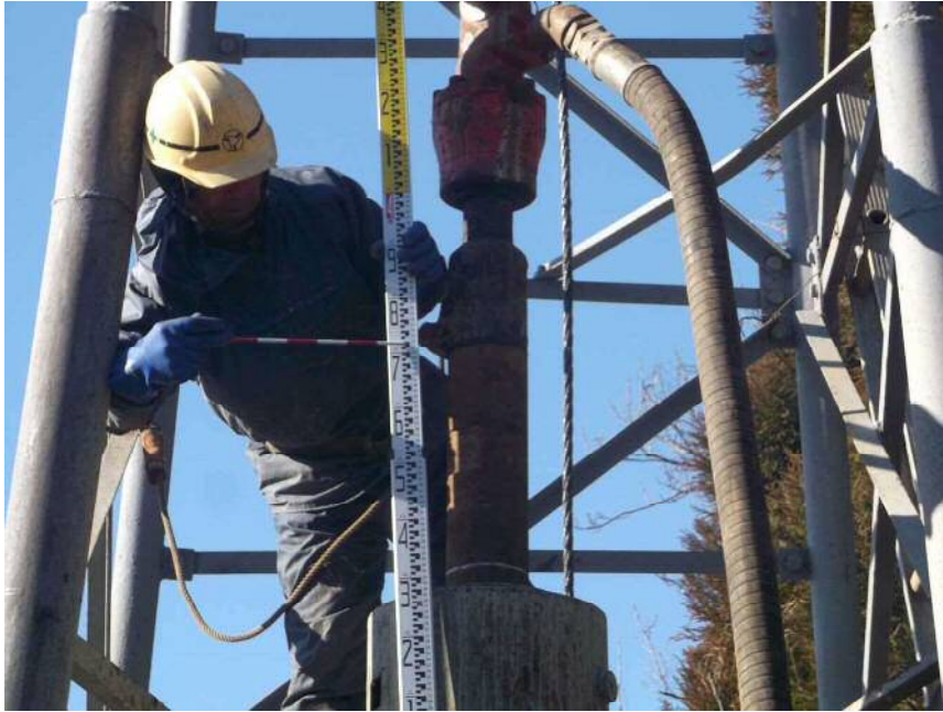
φ 444.5mm掘削 残尺(上端近景) L=3.71m 立会者:徳留氏
