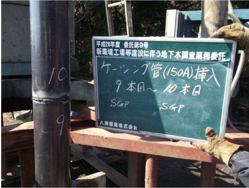
150Aケーシング管挿入 9本目~10本目 (SGP) (SGP)
