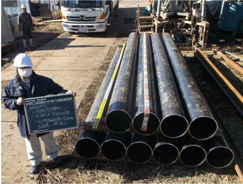
材料検収 コンダクタパイプ 立会者:徳留氏 SGP-A 350×10本 L=5.5m×10本=55.0m
