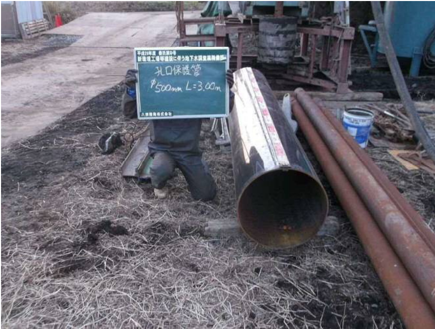
材料検収 孔口保護管 φ 500mm L=3.00m
