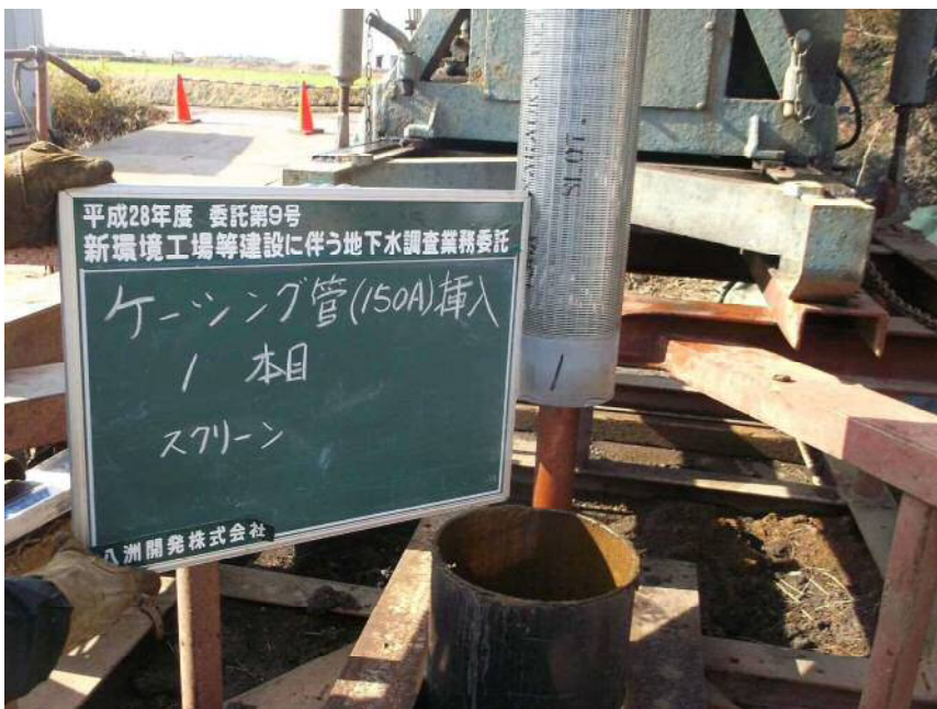
150Aケーシング管挿入 1本目 (スクリーン)
