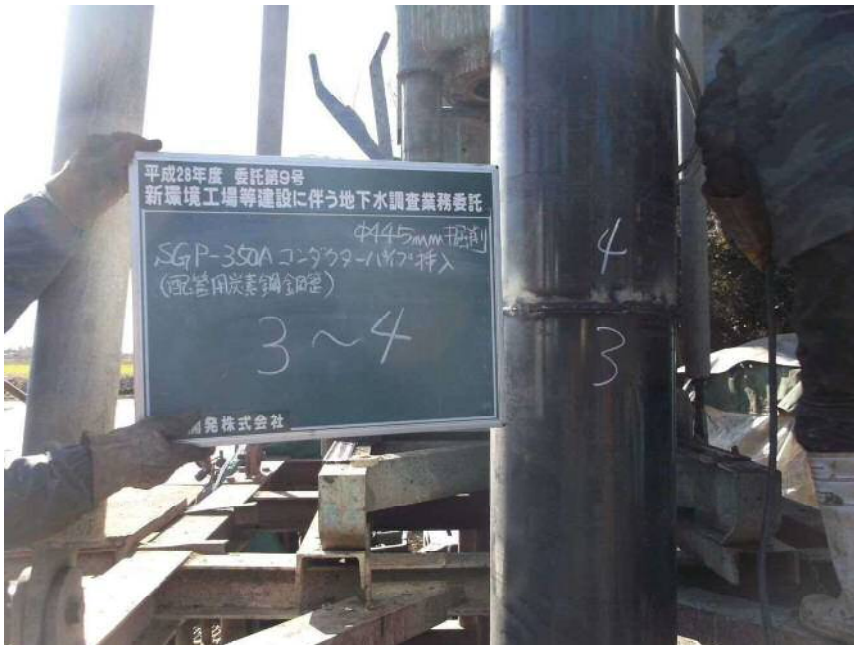
コンダクターパイプ挿入状況 3本目～4本目
