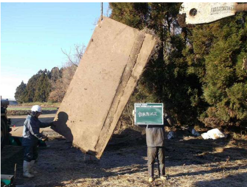
鉄板敷設状況
