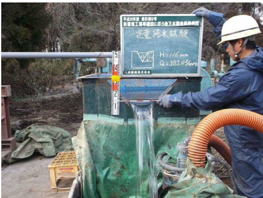
一定量揚水試験
