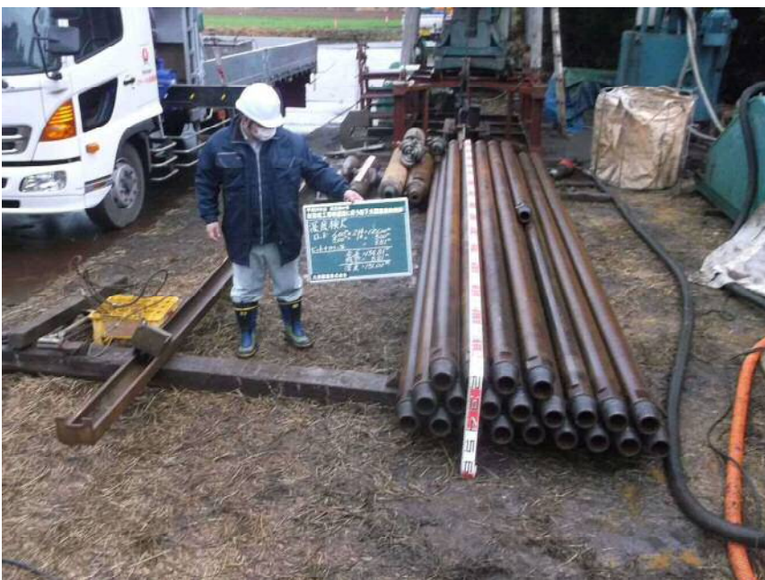
φ 311.2mm掘削 深度検尺(全景) 全長=134.81m 残尺= 3.81m 深度=131.00m
