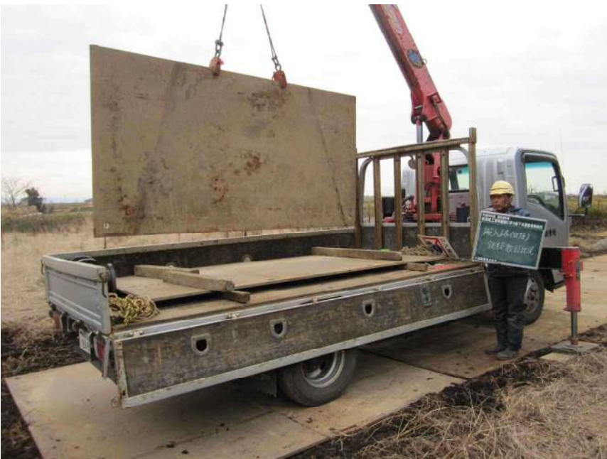
搬入路(仮設) 鉄板敷設状況
