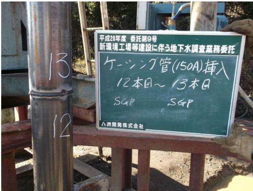
150Aケーシング管挿入 12本目~13本目 (SGP) (SGP)
