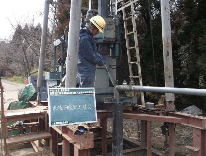
一定量揚水試験 水位回復測定状況
