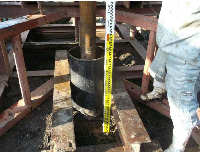
φ 311.2mm掘削 残尺(下端近景) L=3.81m
