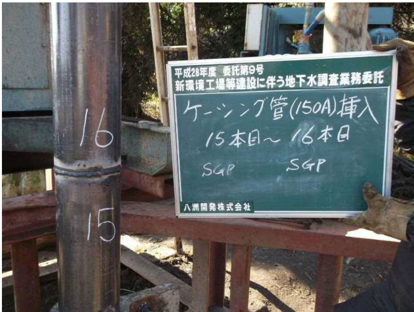
150Aケーシング管挿入 15本目~16本目 (SGP) (SGP)
