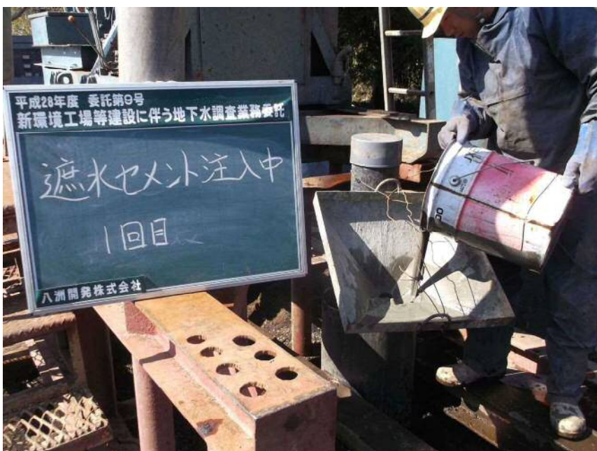
遮水セメント注入状況 1回目
