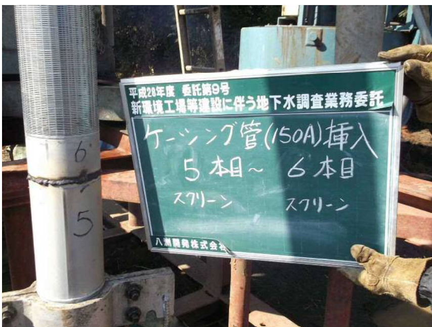
150Aケーシング管挿入 5本目～6本目 (スクリーン) (スクリーン)
