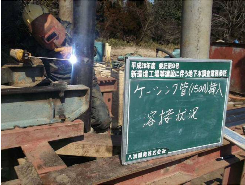
150Aケーシング管挿入 溶接状況
