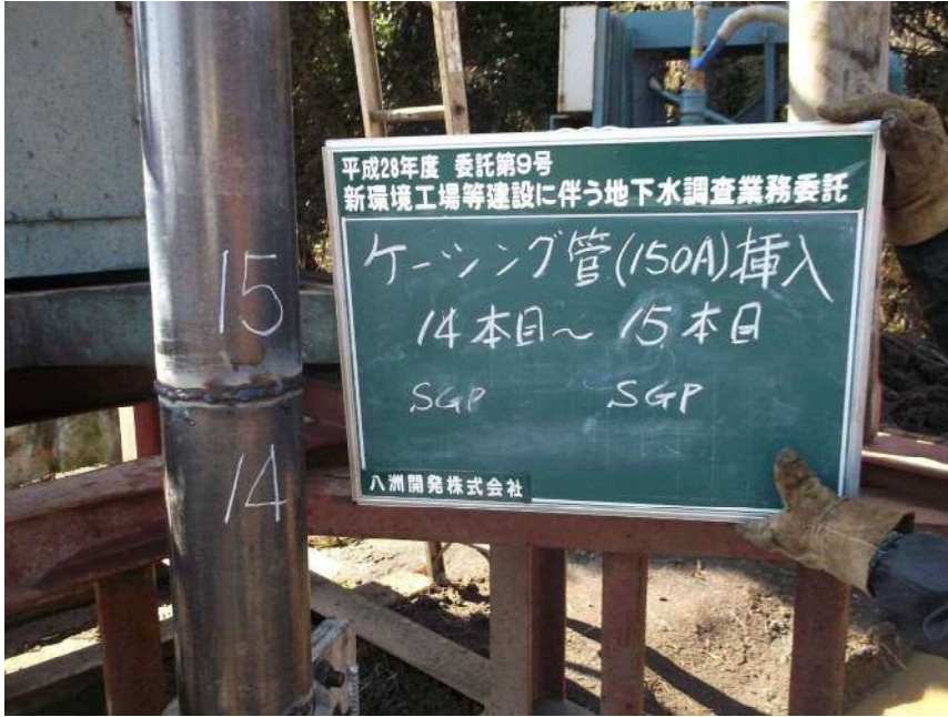
150Aケーシング管挿入 14本目~15本目 (SGP) (SGP)
