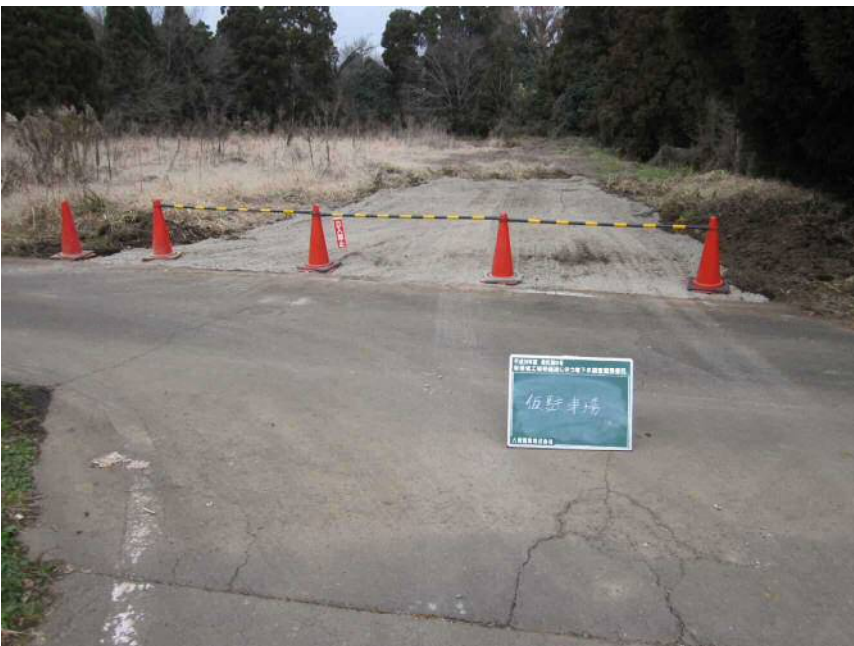
仮駐車場 仮設状況
