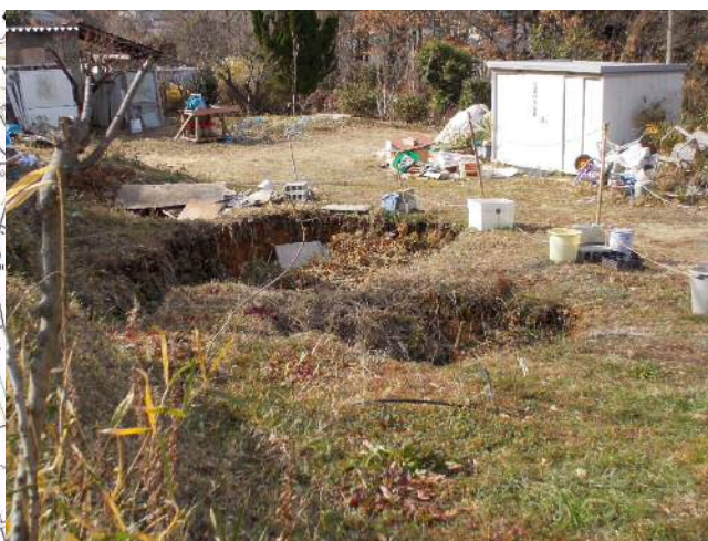
写真 5.6.1 地表の陥没状況
