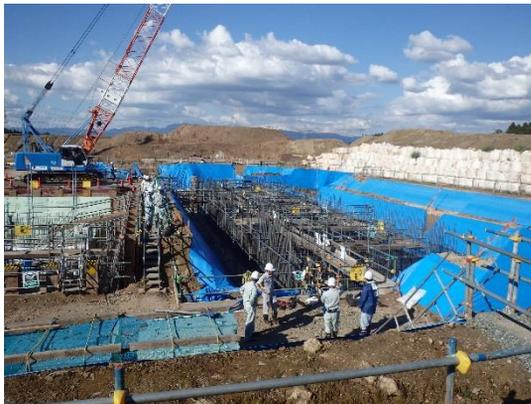
排水処理設備の配筋工事を行っています。
