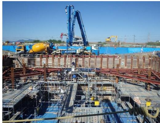
ごみピット壁のコンクリート打設
