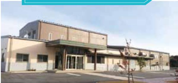
最終処分場の浸出水を処理する施設です。ここで処理した水は、最終処分場の散水に循環利用していますので無放流の施設です。
