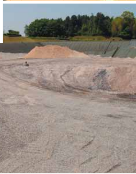
楽善埋立処分場
