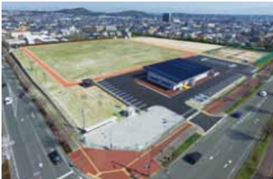
菊陽町光の森防災広場（防災備蓄棟）
