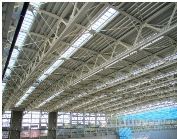
屋根葺きを完了して落下防止仮設水平ネットを撤去しました。
