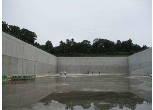
コンクリート工事
