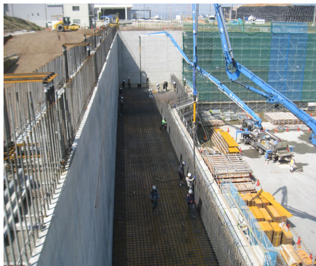
コンクリート工事
