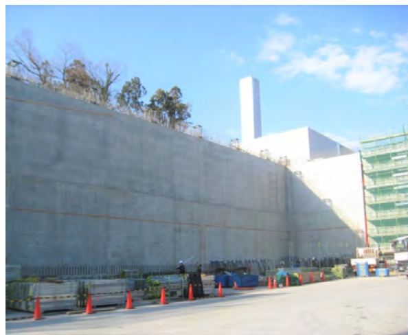
コンクリート工事
