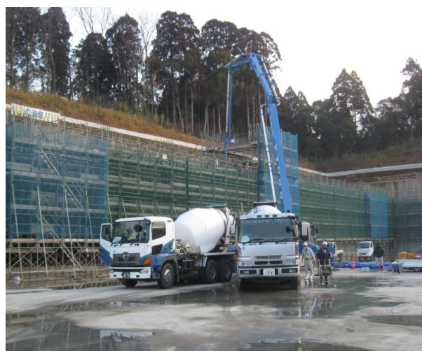
コンクリート工事
