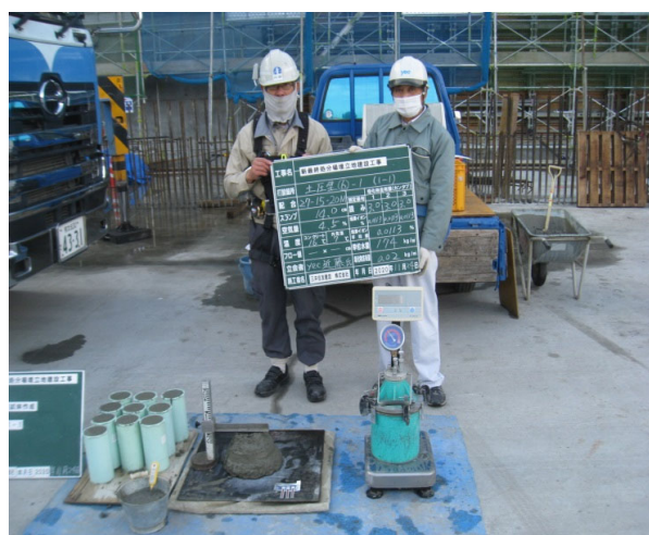
コンクリート工事
