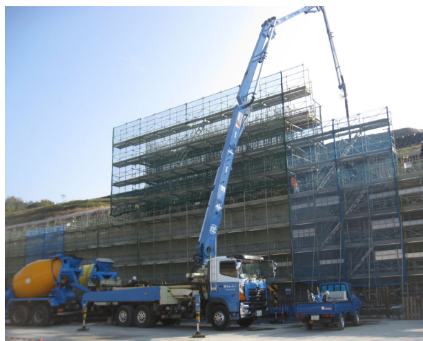
コンクリート工事
