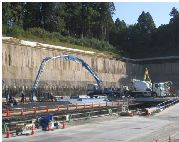
コンクリート工事
