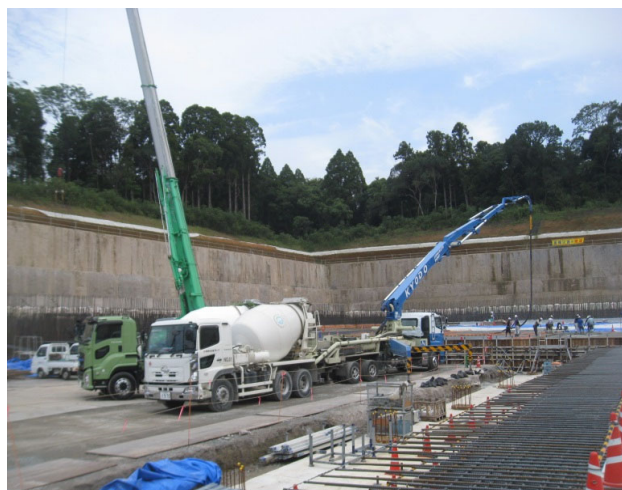
コンクリート工事
