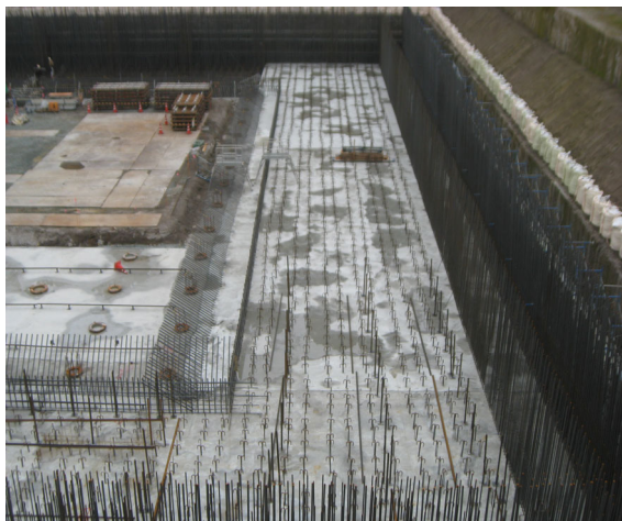
コンクリート工事
