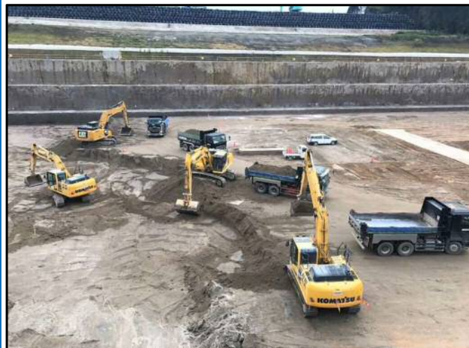
土木工事(掘削工事)
