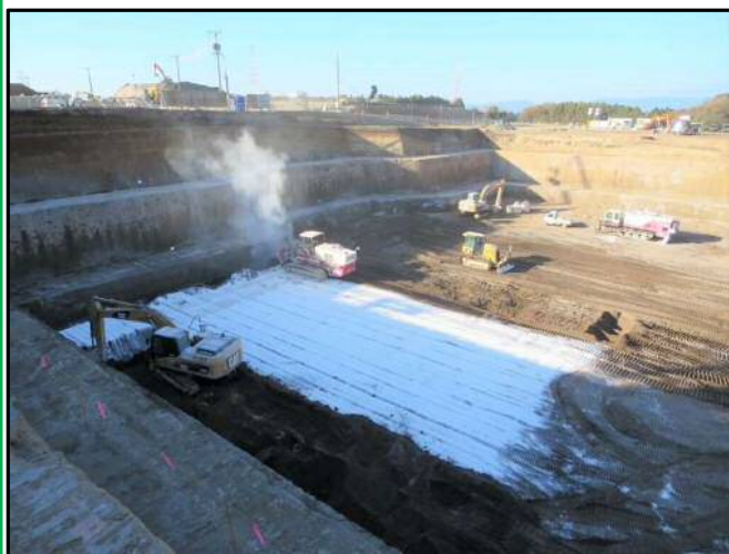
地盤改良工事
