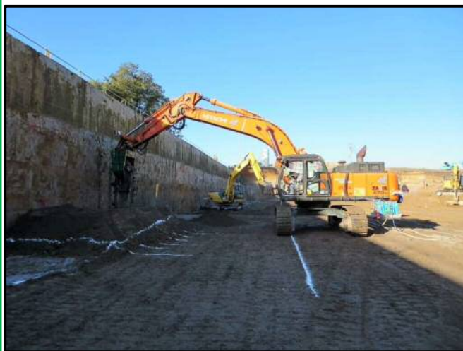
法面对策工事
