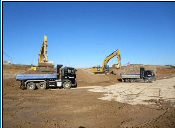
土木工事(掘削工事)
