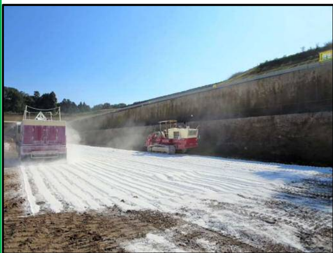
地盤改良工事
