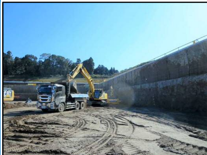
土木工事(掘削工事)
