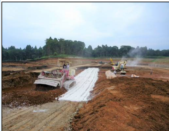
地盤改良工事
