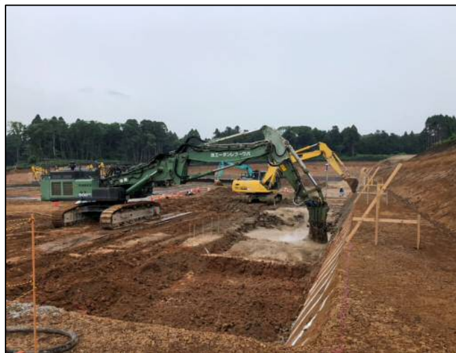
法面对策工事
