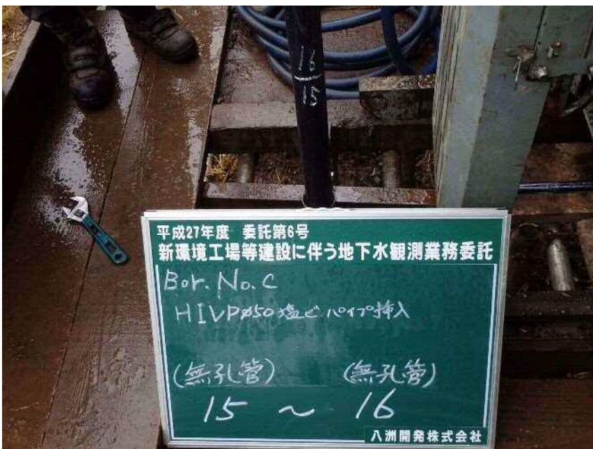
No. C HIVPφ50塩ビパイプ挿入 (無孔管) (無孔管) 15 ~ 16
