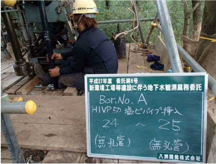
No. A HIVPφ50塩ビパイプ挿入 (無孔管) (無孔管) 24 ~ 25
