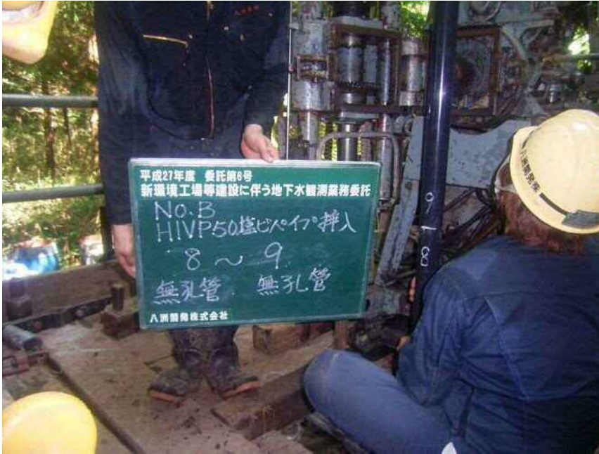
No. B HIVP φ 50塩ビパイプ挿入 (無孔管) (無孔管) 8 ~ 9
