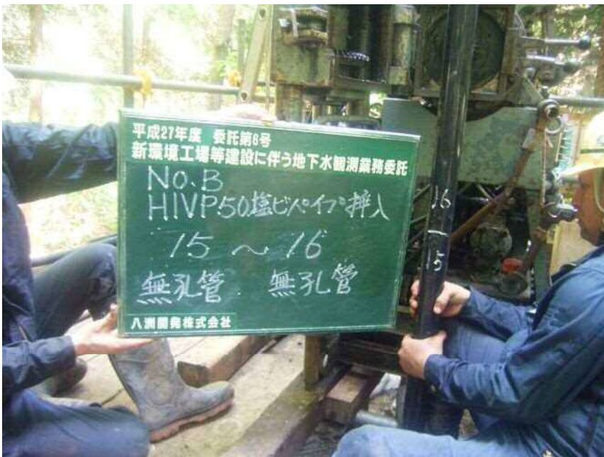
No. B HIVP φ 50塩ビパイプ挿入 (無孔管) (無孔管) 15 ~ 16
