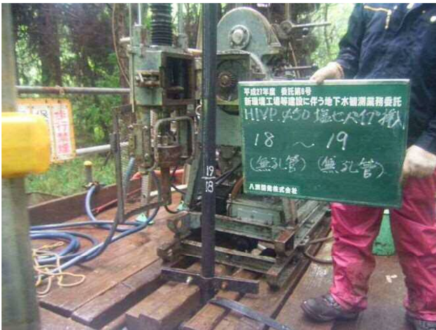
No. D HIVP φ 50塩ビパイプ挿入 (無孔管) (無孔管) 18 ~ 19
