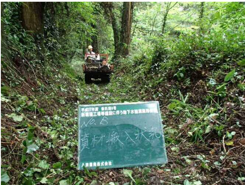
No. B 資材搬入状況
