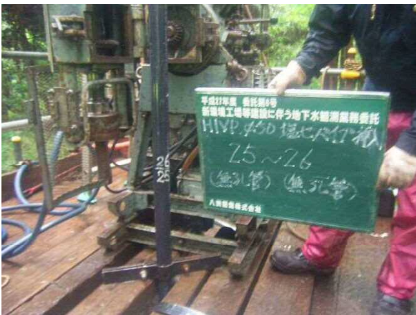
No. D HIVP φ 50塩ビパイプ挿入 (無孔管) (無孔管) 25 ~ 26
