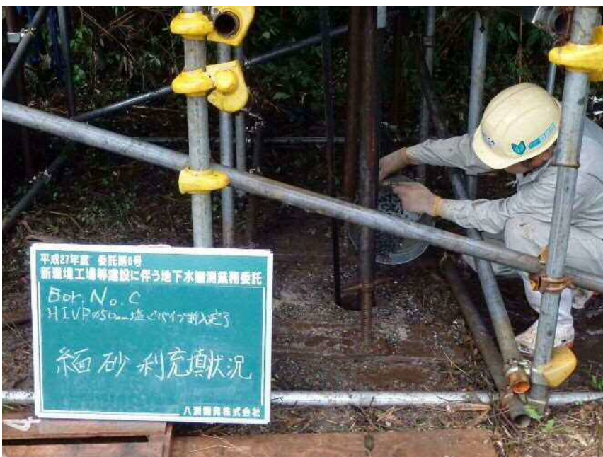
No. C 締砂利充填状況
