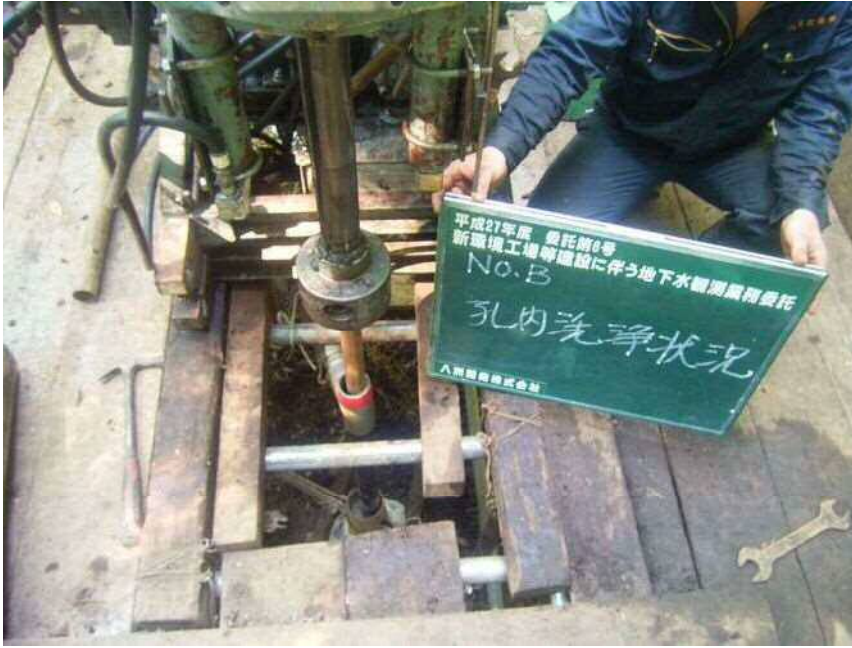
No. B 孔内洗浄状況
