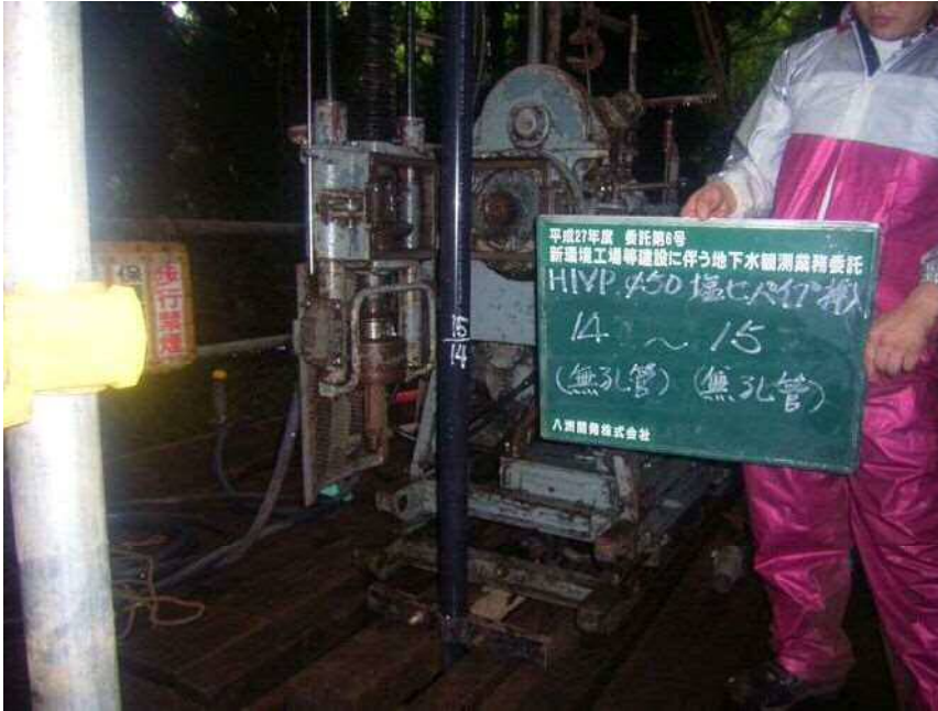
No. D HIVP φ 50塩ビパイプ挿入 (無孔管) (無孔管) 14 ~ 15
