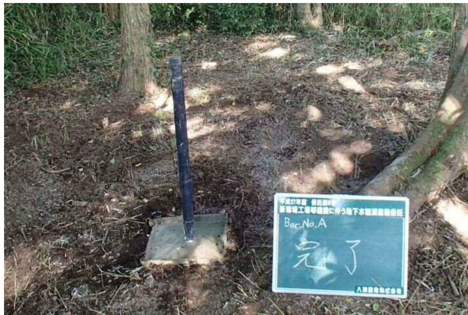
写真-2 コンクリート孔口保護の状況
