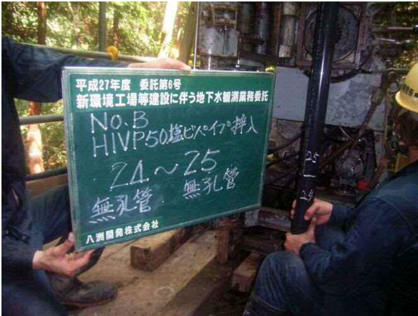
No. B HIVP φ 50塩ビパイプ挿入 (無孔管) (無孔管) 24 ~ 25
