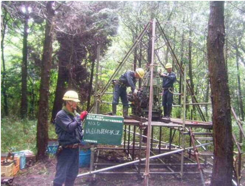
No. D 試錐機据付状況
