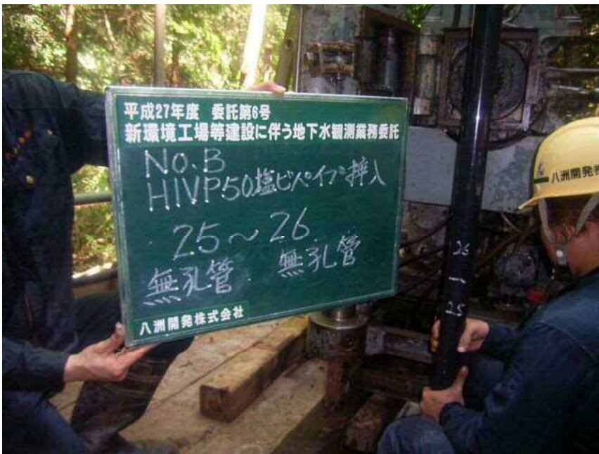
No. B HIVP φ 50塩ビパイプ挿入 (無孔管) (無孔管) 25 ~ 26
