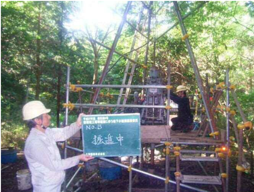
No. B 掘進中
