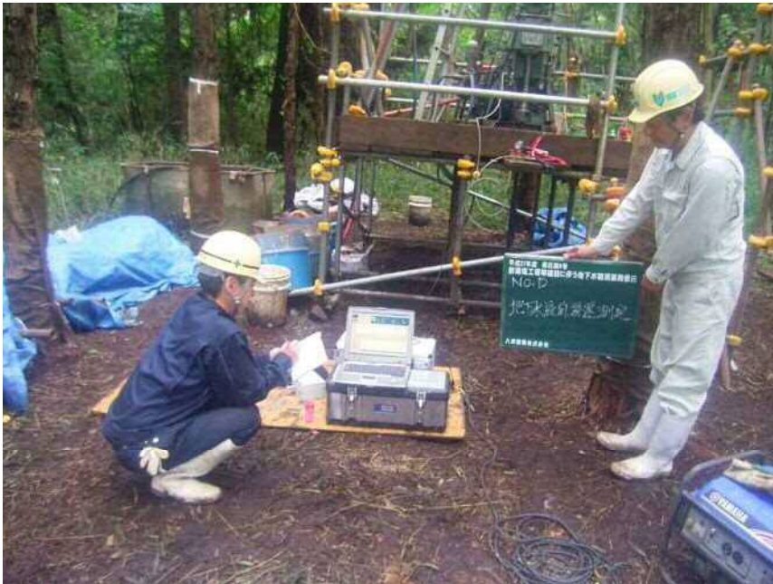
No. D 地下水流向流速測定
