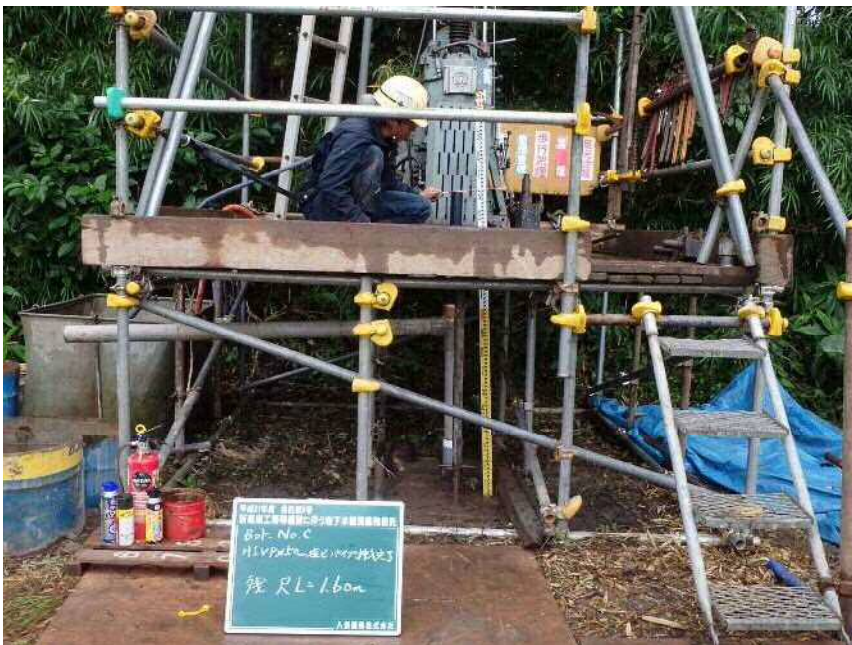
No. C HIVP φ 50塩ビパイプ挿入完了 残尺= 1.60m
