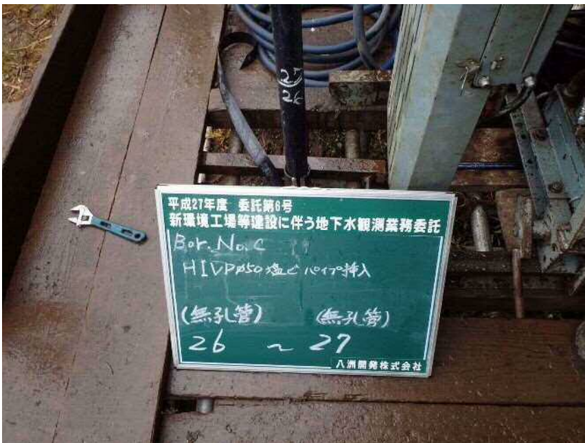
No. C HIVP φ 50塩ビパイプ挿入 (無孔管) (無孔管) 26 ~ 27
