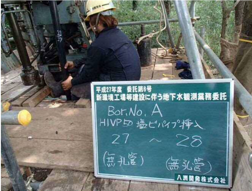
No. A HIVPφ50塩ビパイプ挿入 (無孔管) (無孔管) 27 ~ 28
