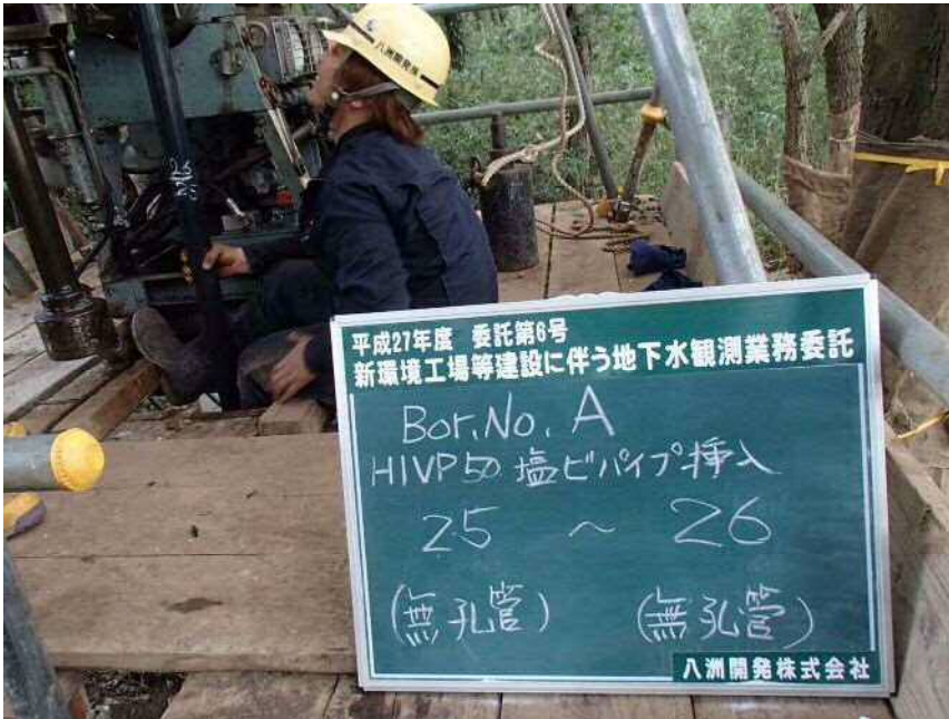
No. A HIVPφ50塩ビパイプ挿入 (無孔管) (無孔管) 25 ~ 26
