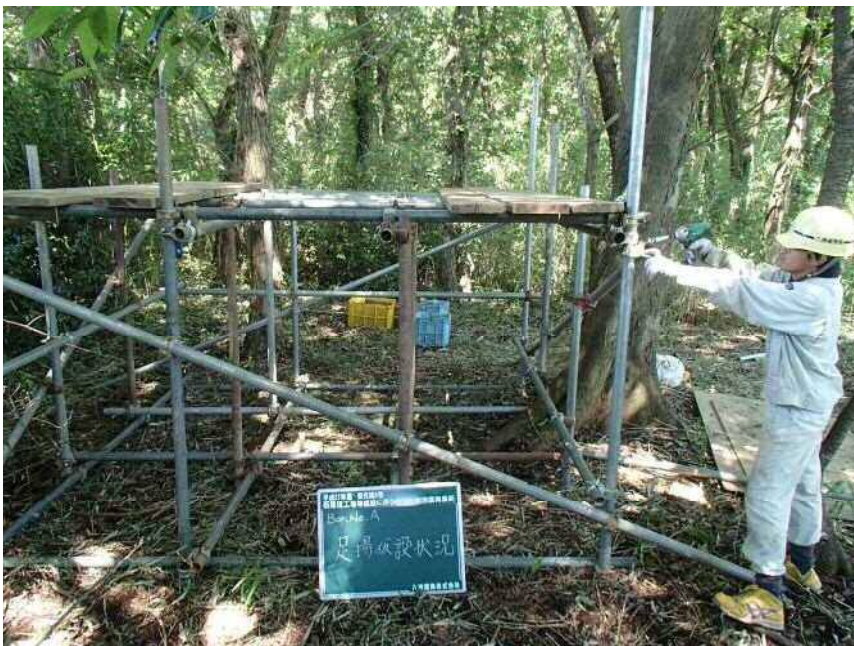
No. A 足場仮設状況
