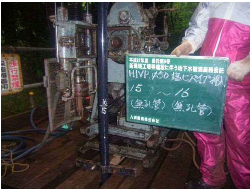
No. D HIVP φ 50塩ビパイプ挿入 (無孔管) (無孔管) 15 ~ 16
