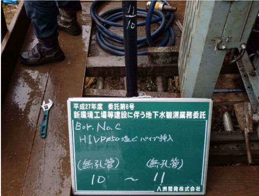
No. C HIVP φ 50塩ビパイプ挿入 (無孔管) (無孔管) 10 ~ 11
