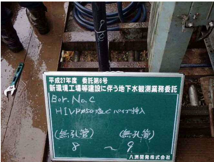
No. C HIVP φ 50塩ビパイプ挿入 (無孔管) (無孔管) 8 ~ 9
