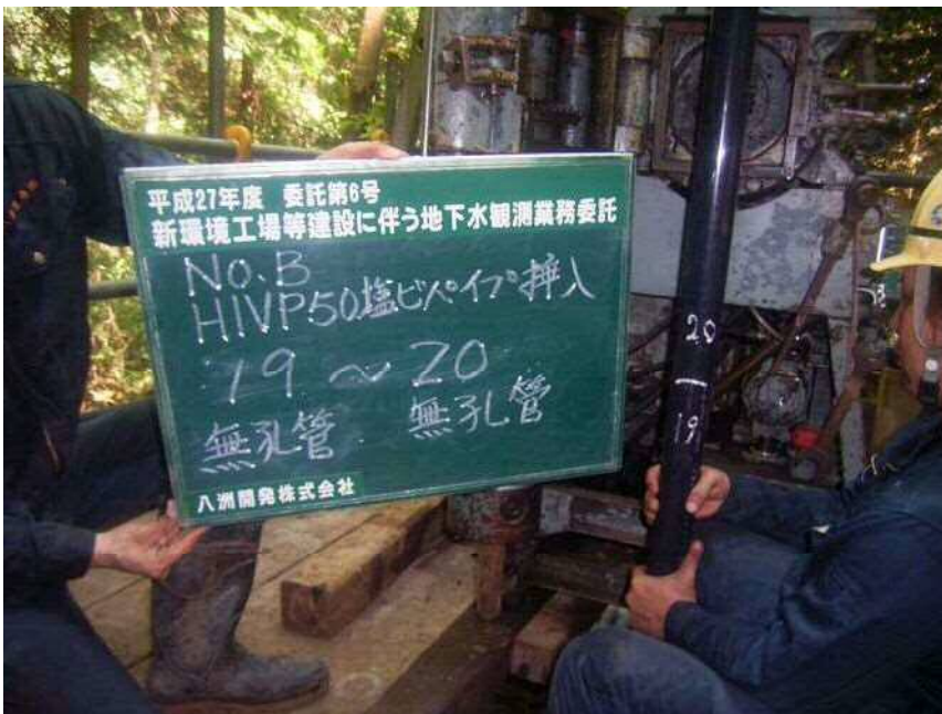
No. B HIVP φ 50塩ビパイプ挿入 (無孔管) (無孔管) 19 ~ 20
