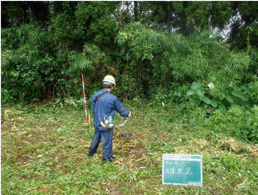
No. C 伐採状況
