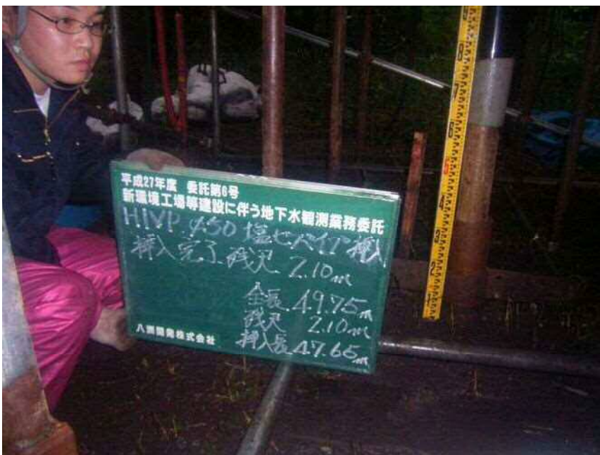
No. D HIVP φ 50塩ビパイプ挿入完了 全 長=49.75m 残 尺= 2.10m 挿入長=47.65m
