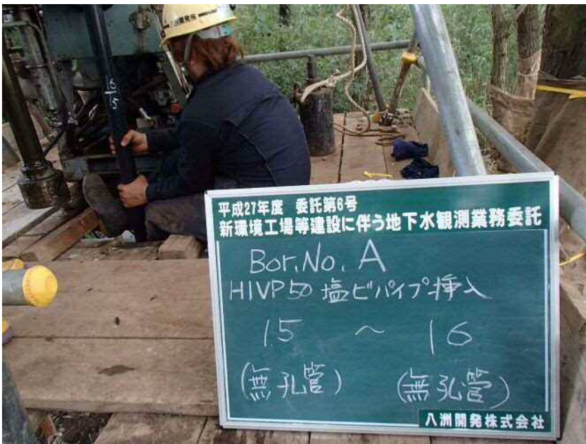
No. A HIVPφ50塩ビパイプ挿入 (無孔管) (無孔管) 15 ~ 16
