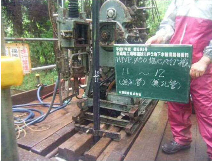
No. D HIVP φ 50塩ビパイプ挿入 (無孔管) (無孔管) 11 ~ 12
