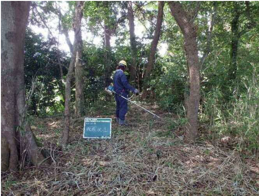
No. A 伐採状況
