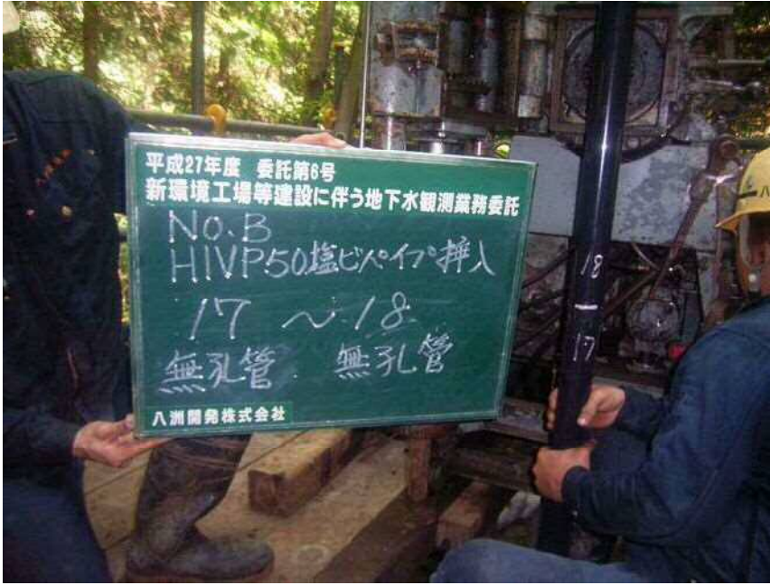
No. B HIVP φ 50塩ビパイプ挿入 (無孔管) (無孔管) 17 ~ 18
