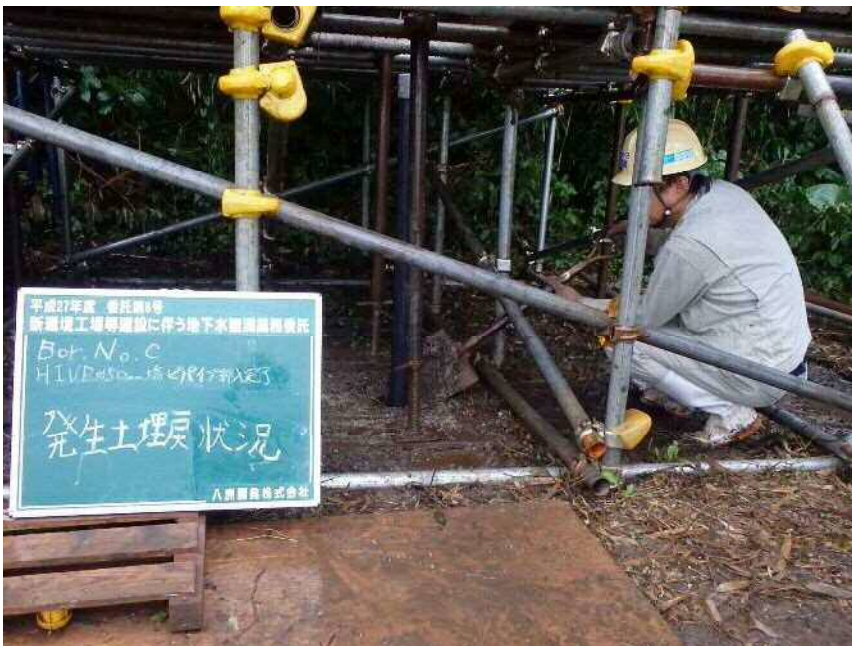
No. C 発生土埋戻状況
