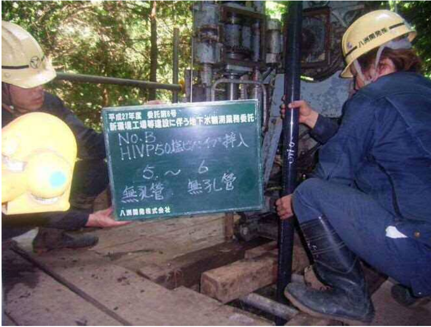
No. B HVPφ50塩ビパイプ挿入 (無孔管) (無孔管) 5 ~ 6
