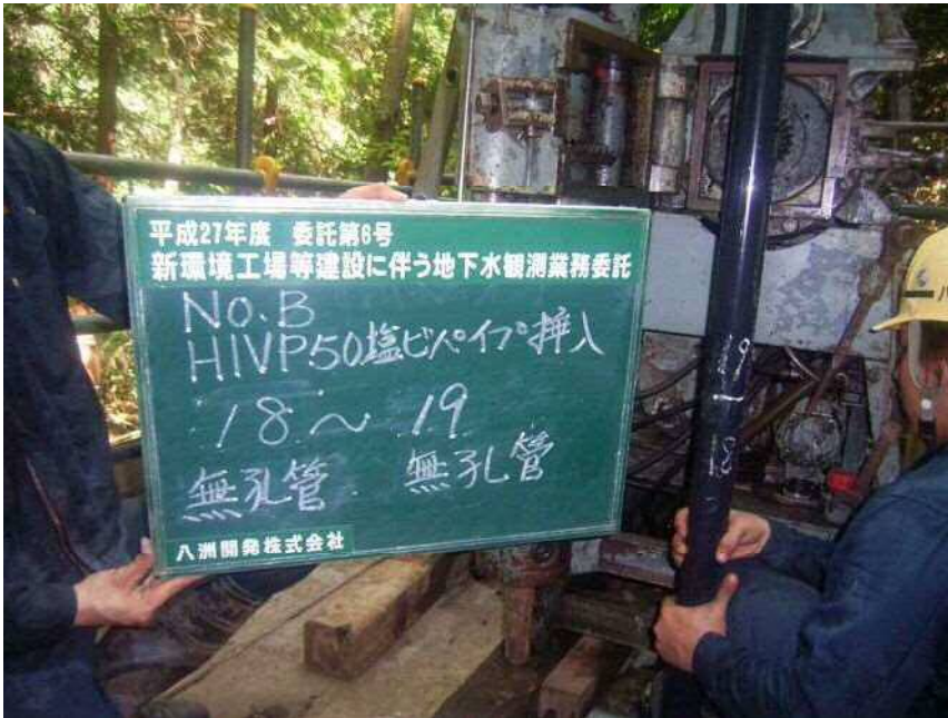
No. B HIVP φ 50塩ビパイプ挿入 (無孔管) (無孔管) 18 ~ 19
