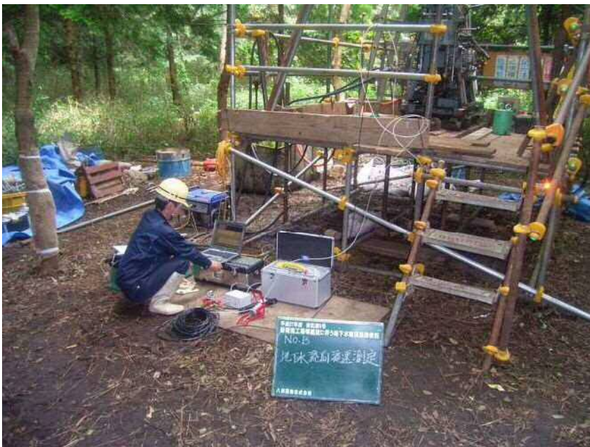
No. B 地下水流向流速測定
