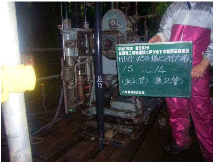
No. D HIVP φ 50塩ビパイプ挿入 (無孔管) (無孔管) 13 ~ 14
