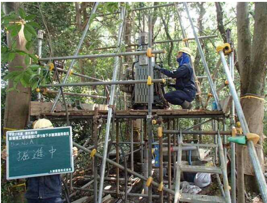
No. A 掘進中
