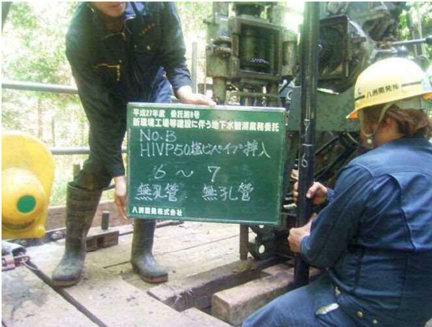
No. B HVPφ50塩ビパイプ挿入 (無孔管) (無孔管) 6 ~ 7
