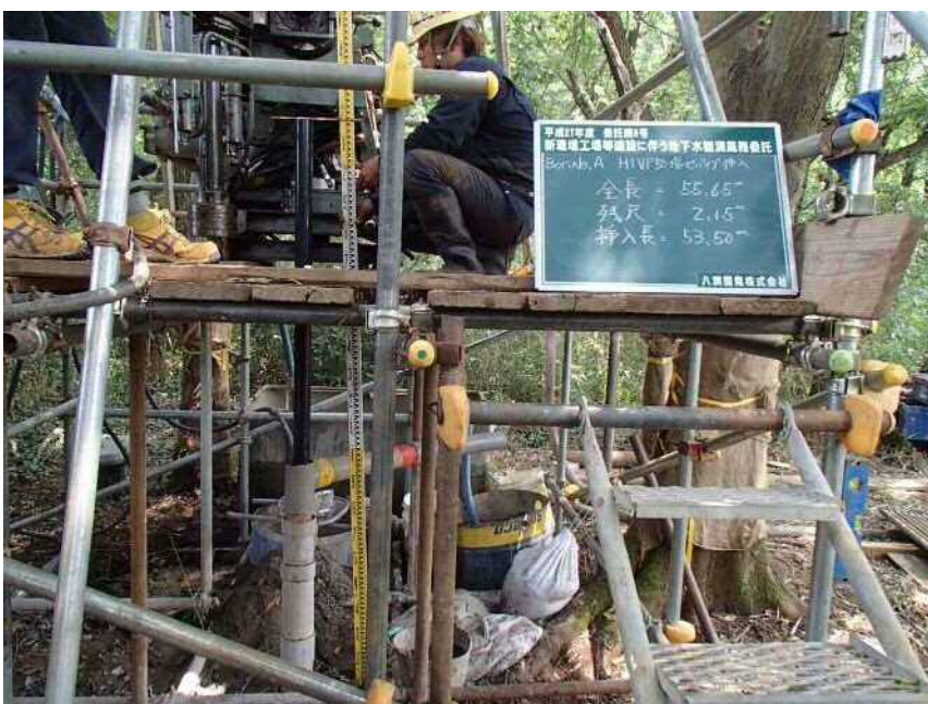
No. A HIVPφ50塩ビパイプ挿入完了 全長=55.65m 残尺= 2.15m 挿入長=53.50m
