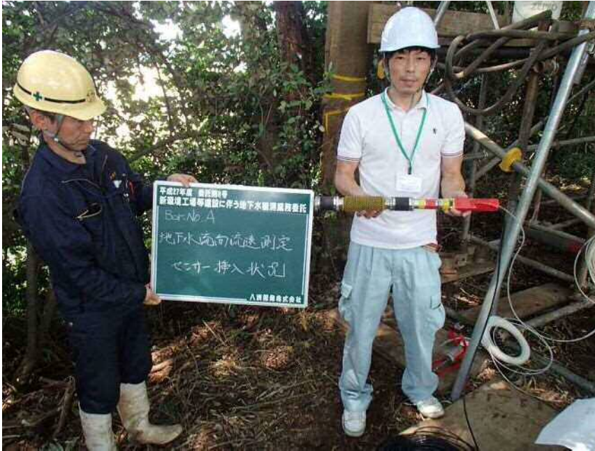
No. A 地下水流向流速測定 センサー挿入状況
