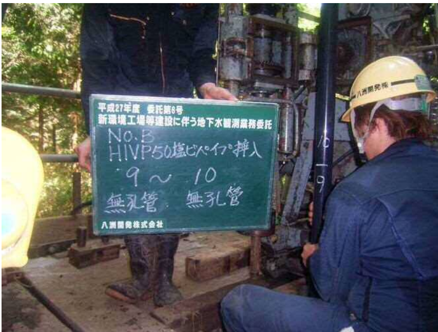
No. B HIVP φ 50塩ビパイプ挿入 (無孔管) (無孔管) 9 ~ 10
