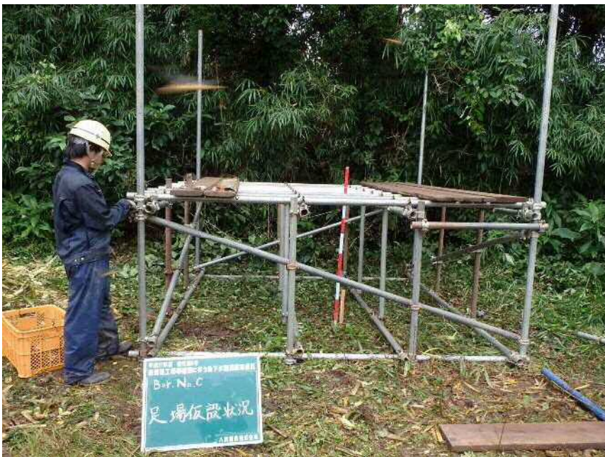
No. C 足場仮設状況
