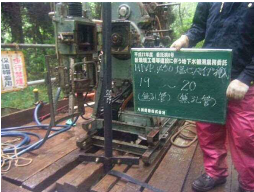
No. D HIVP φ 50塩ビパイプ挿入 (無孔管) (無孔管) 19 ~ 20
