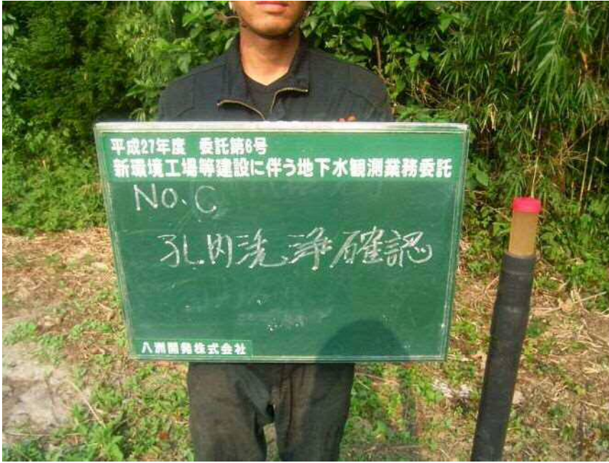
No. C 孔内洗浄確認
