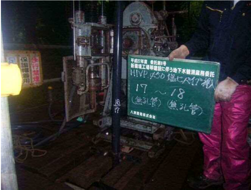
No. D HIVP φ 50塩ビパイプ挿入 (無孔管) (無孔管) 17 ~ 18
