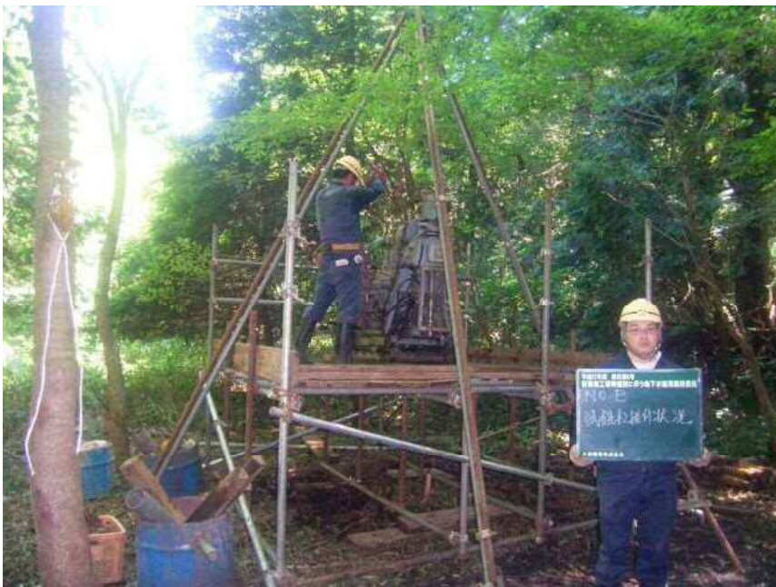
No. B 試錐機据付状況
