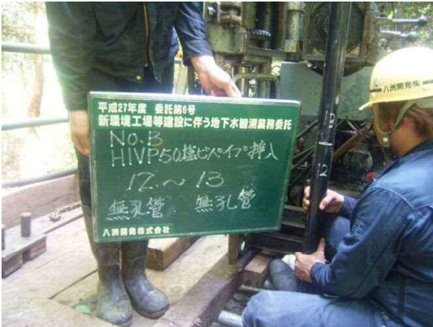
No. B HIVP φ 50塩ビパイプ挿入 (無孔管) (無孔管) 12 ~ 13
