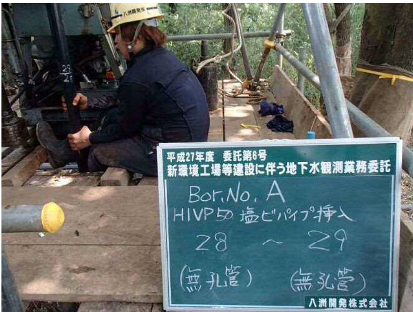
No. A HIVPφ50塩ビパイプ挿入 (無孔管) (無孔管) 28 ~ 29
