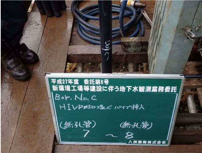
No. C HIVP φ 50塩ビパイプ挿入 (無孔管) (無孔管) 7 ~ 8
