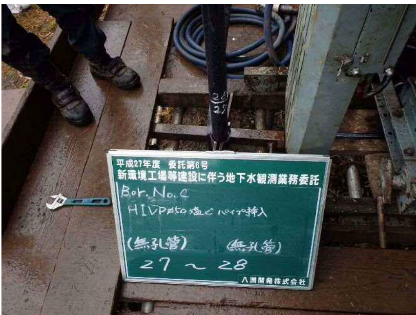
No. C HIVP φ 50塩ビパイプ挿入 (無孔管) (無孔管) 27 ~ 28
