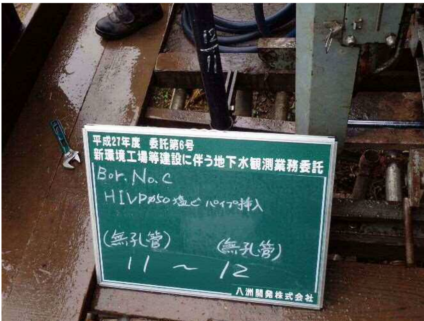
No. C HIVP φ 50塩ビパイプ挿入 (無孔管) (無孔管) 11 ~ 12
