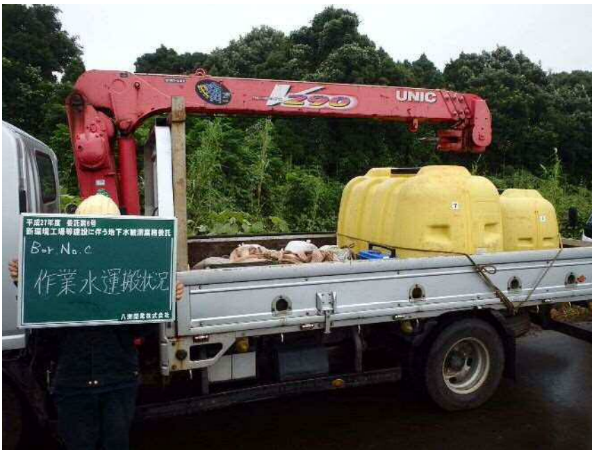
No. C 作業水運搬状況
