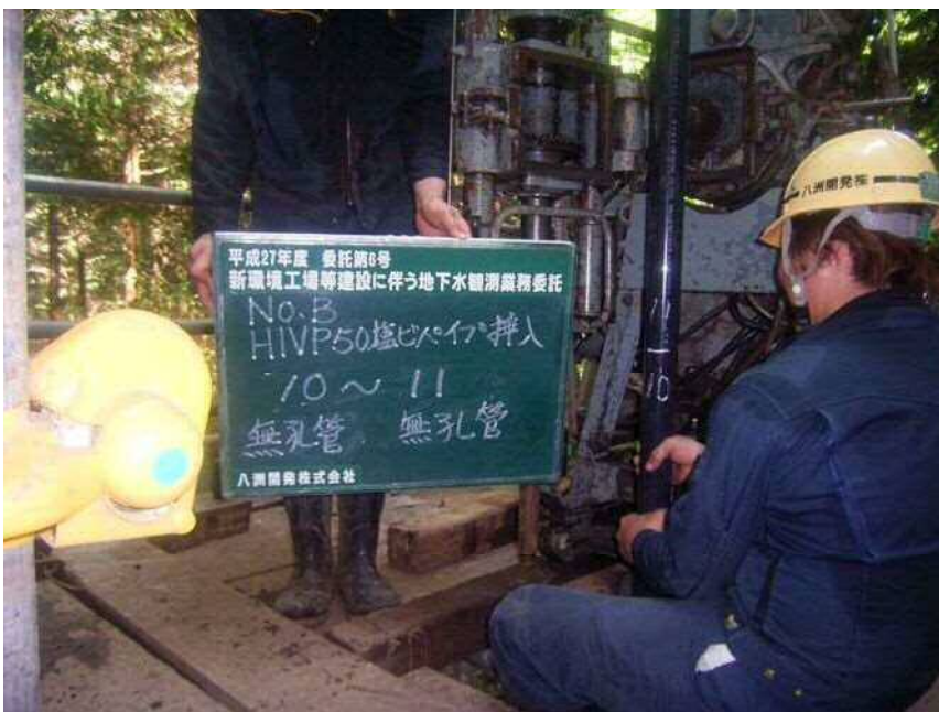
No. B HIVP φ 50塩ビパイプ挿入 (無孔管) (無孔管) 10 ~ 11
