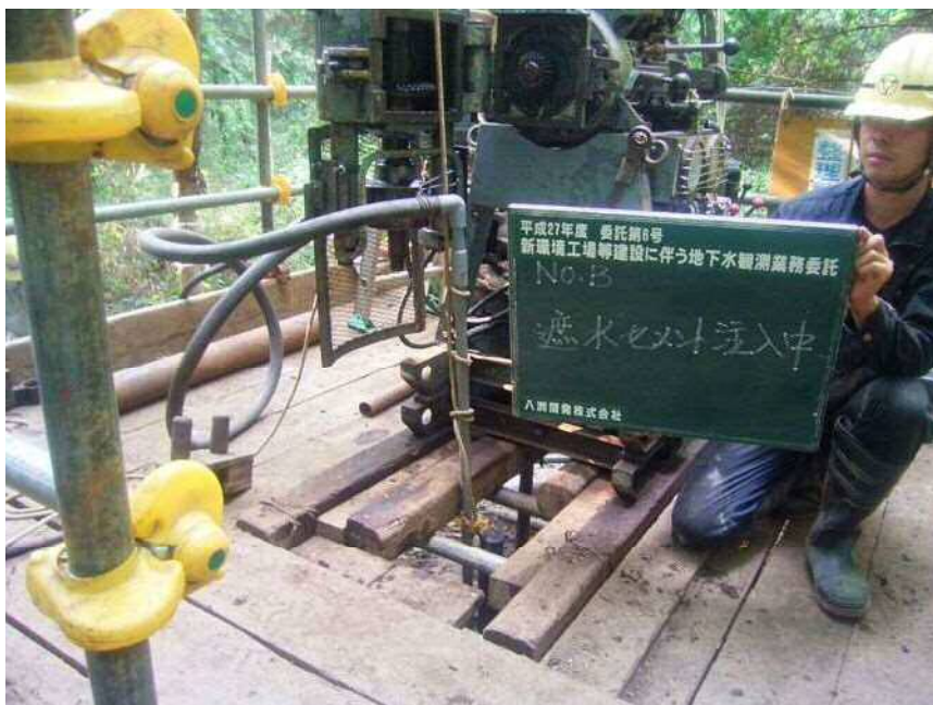
No. B 遮水セメント注入中
