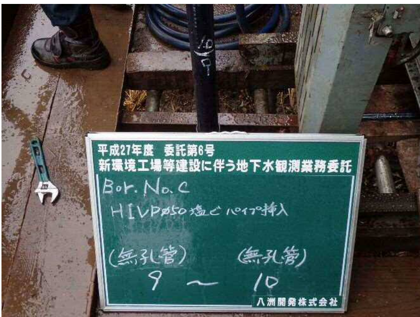
No. C HIVP φ 50塩ビパイプ挿入 (無孔管) (無孔管) 9 ~ 10
