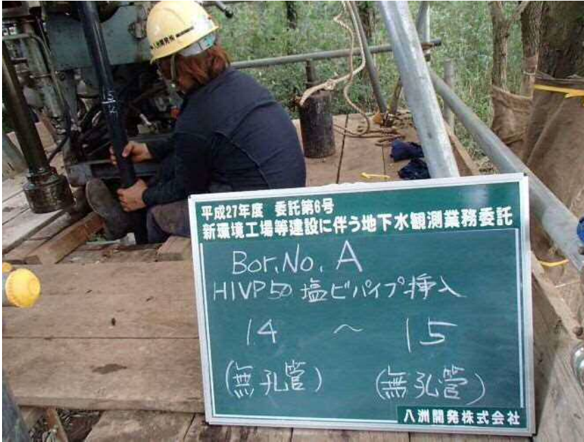
No. A HIVPφ50塩ビパイプ挿入 (無孔管) (無孔管) 14 ~ 15
