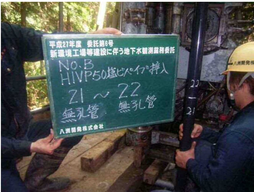
No. B HIVP φ 50塩ビパイプ挿入 (無孔管) (無孔管) 21 ~ 22
