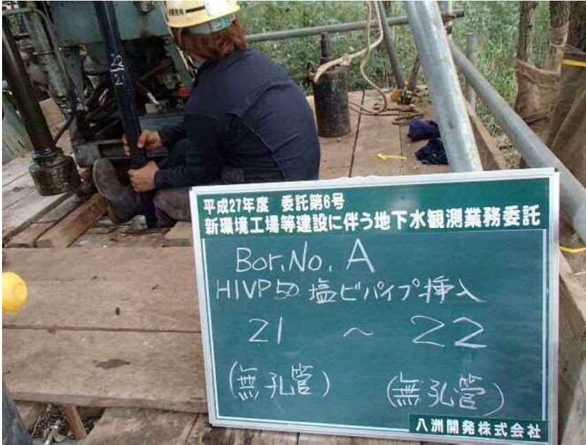
No. A HIVPφ50塩ビパイプ挿入 (無孔管) (無孔管) 21 ~ 22
