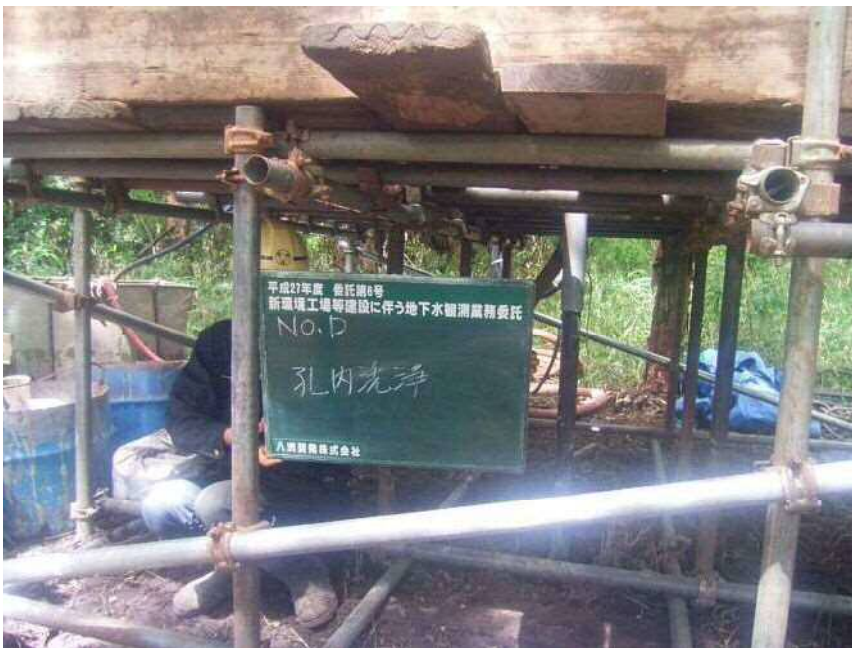
No. D 孔内洗浄状況
