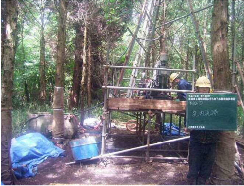
No. D 孔内洗浄状況
