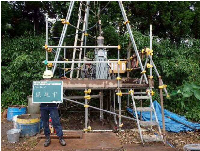
No. C 掘進中
