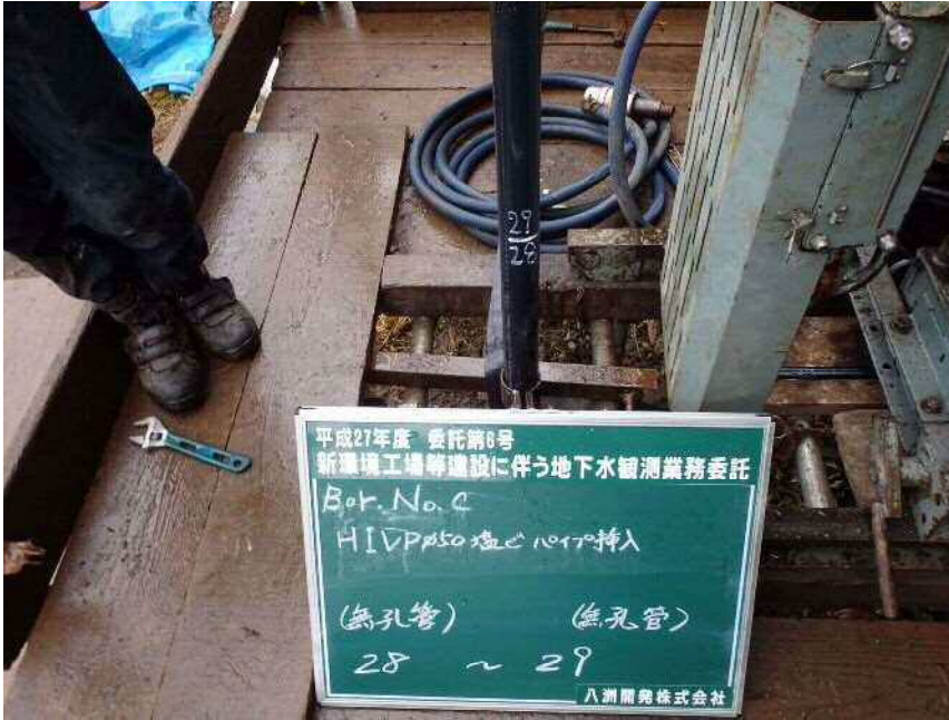
No. C HIVP φ 50塩ビパイプ挿入 (無孔管) (無孔管) 28 ~ 29
