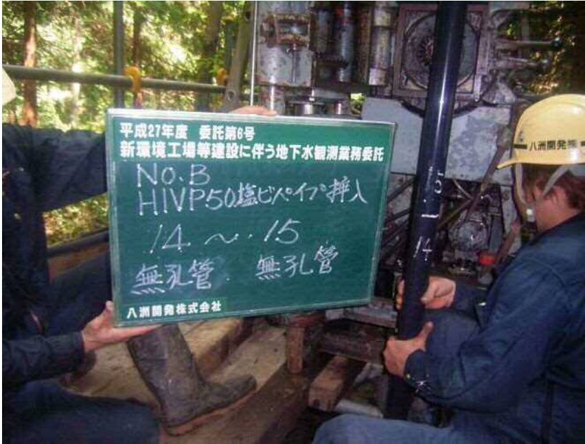
No. B HIVP φ 50塩ビパイプ挿入 (無孔管) (無孔管) 14 ~ 15
