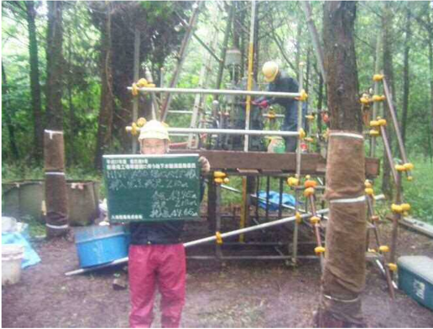
No. D HIVP φ 50塩ビパイプ挿入完了 全 長=49.75m 残 尺= 2.10m 挿入長=47.65m
