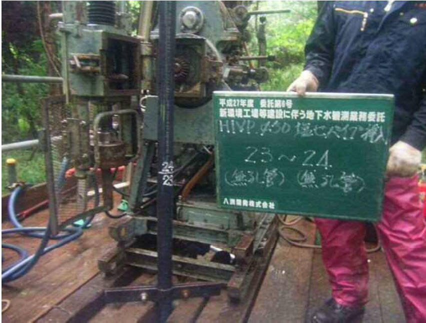
No. D HIVP φ 50塩ビパイプ挿入 (無孔管) (無孔管) 23 ~ 24
