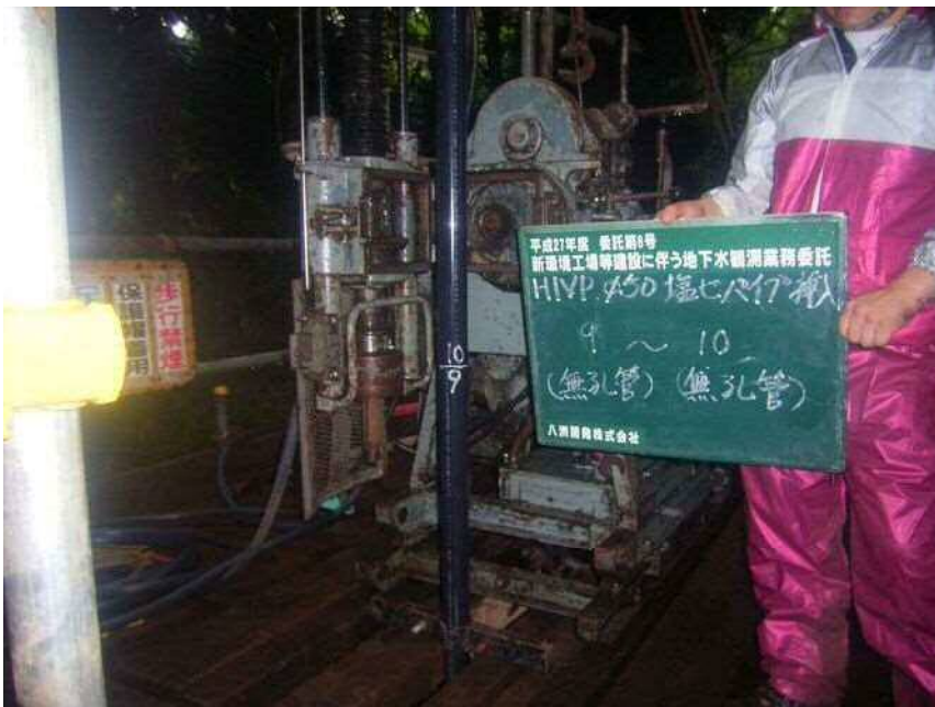
No. D HIVP φ 50塩ビパイプ挿入 (無孔管) (無孔管) 9 ~ 10
