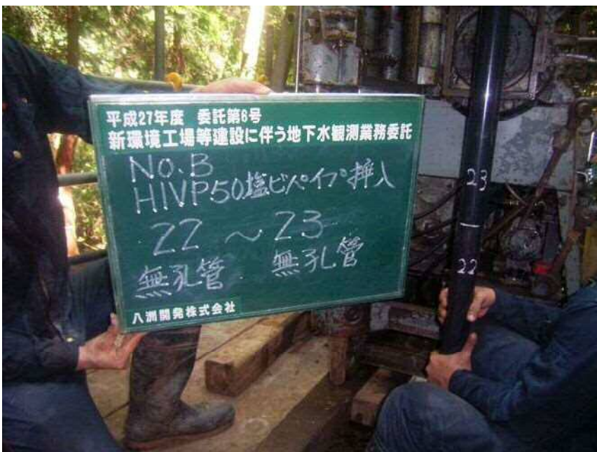
No. B HIVP φ 50塩ビパイプ挿入 (無孔管) (無孔管) 22 ~ 23
