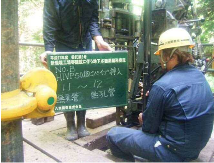
No. B HIVP φ 50塩ビパイプ挿入 (無孔管) (無孔管) 11 ~ 12
