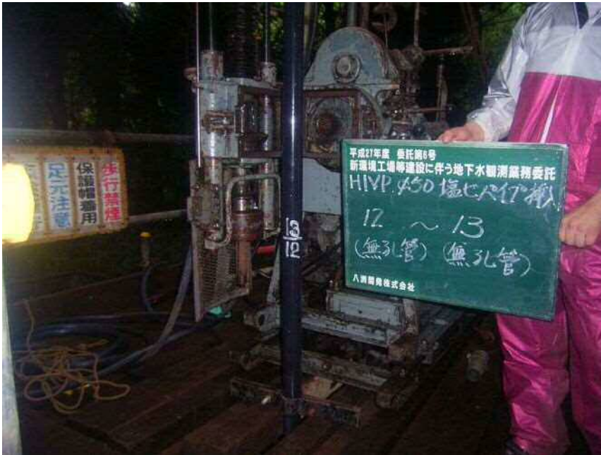
No. D HIVP φ 50塩ビパイプ挿入 (無孔管) (無孔管) 12 ~ 13
