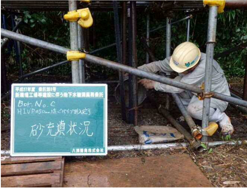
No. C 砂充填状況
