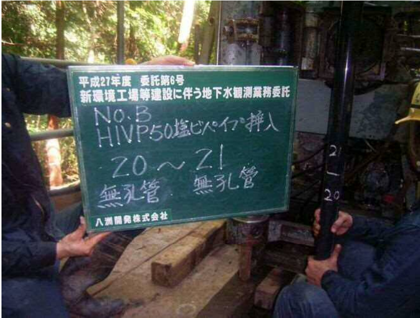
No. B HIVP φ 50塩ビパイプ挿入 (無孔管) (無孔管) 20 ~ 21
