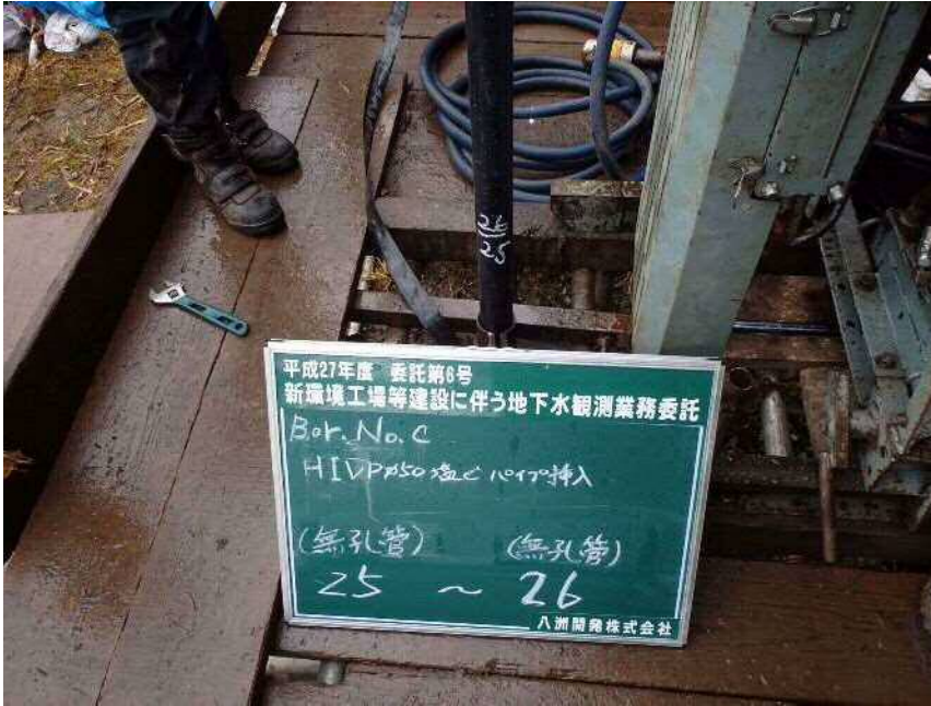
No. C HIVP φ 50塩ビパイプ挿入 (無孔管) (無孔管) 25 ~ 26
