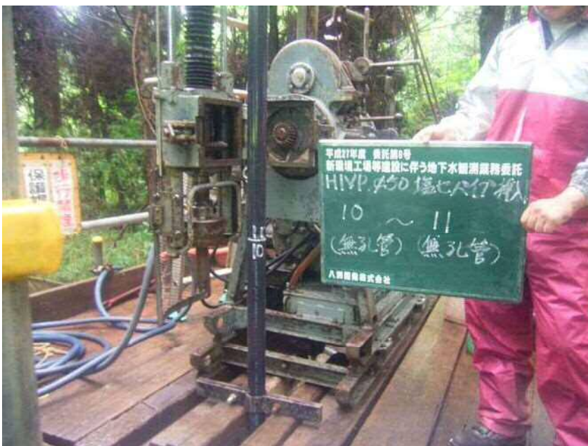
No. D HIVP φ 50塩ビパイプ挿入 (無孔管) (無孔管) 10 ~ 11
