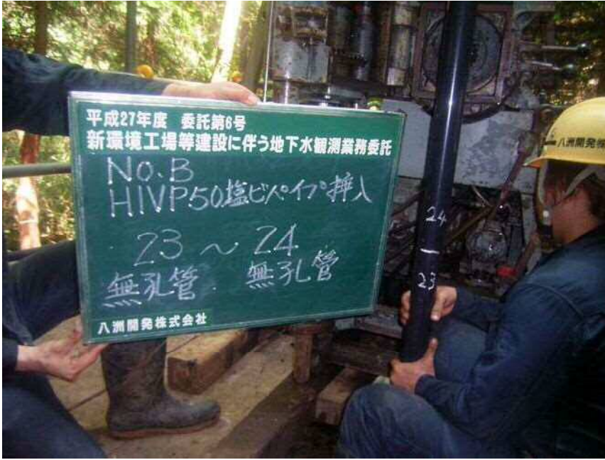
No. B HIVP φ 50塩ビパイプ挿入 (無孔管) (無孔管) 23 ~ 24
