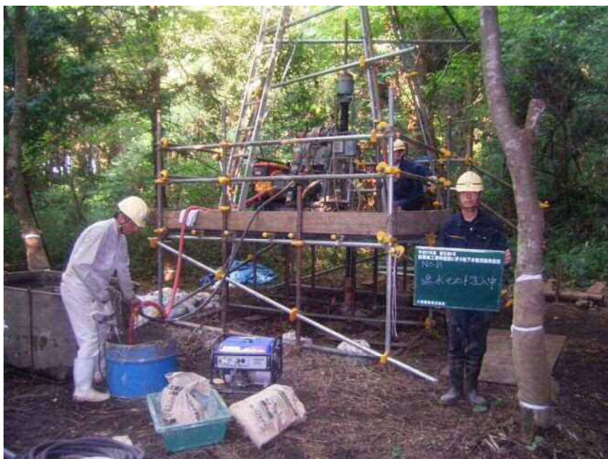
No. B 遮水セメント注入中
