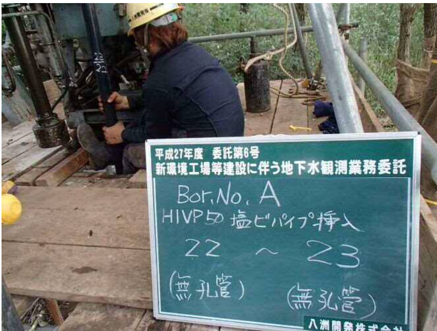
No. A HIVPφ50塩ビパイプ挿入 (無孔管) (無孔管) 22 ~ 23
