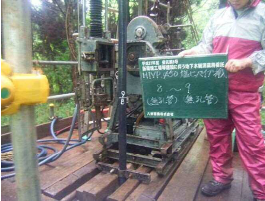
No. D HIVP φ 50塩ビパイプ挿入 (無孔管) (無孔管) 8 ~ 9
