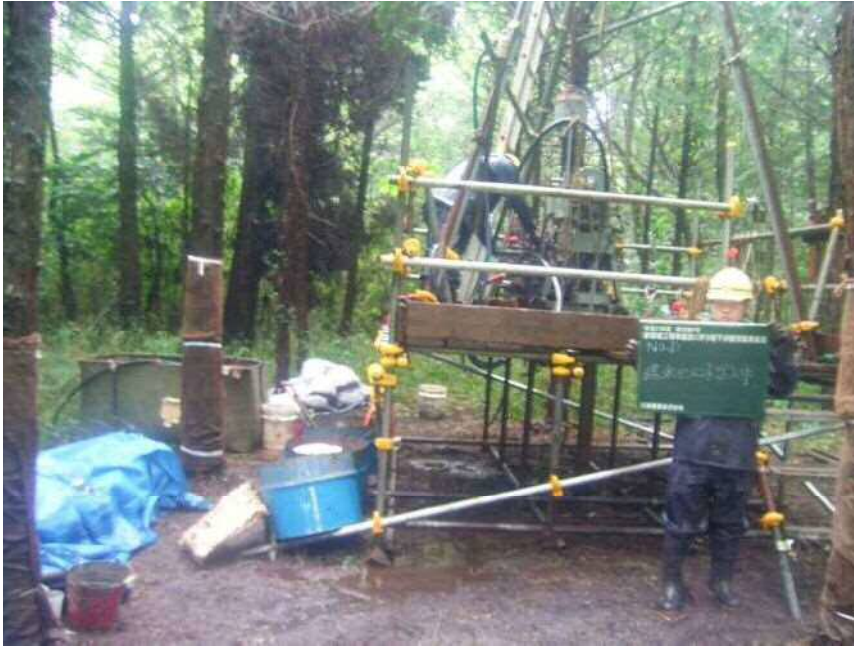
No. D 遮水セメント注入中
