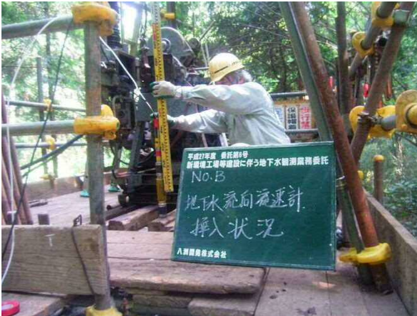
No. B 地下水流向流速計 挿入状況
