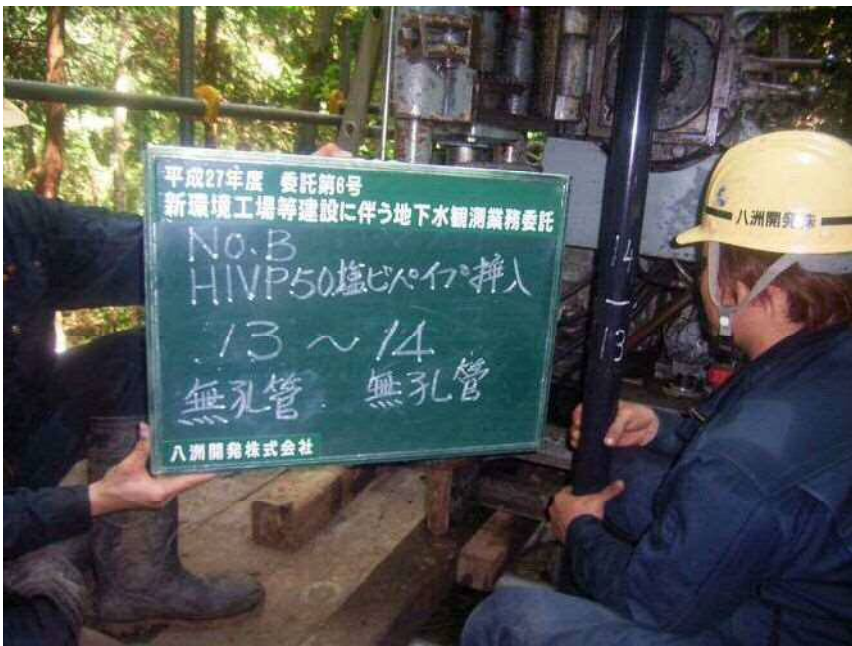
No. B HIVP φ 50塩ビパイプ挿入 (無孔管) (無孔管) 13 ~ 14
