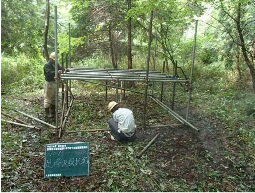
No. B 足場仮設状況
