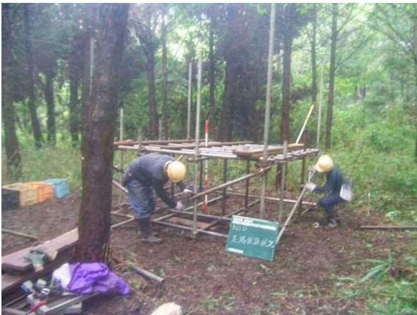
No. D 足場仮設状況
