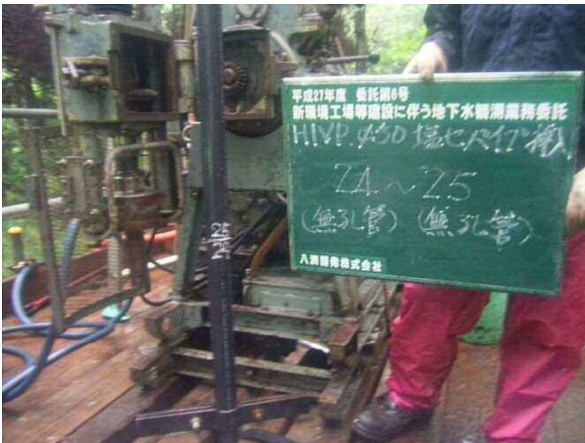
No. D HIVP φ 50塩ビパイプ挿入 (無孔管) (無孔管) 24 ~ 25
