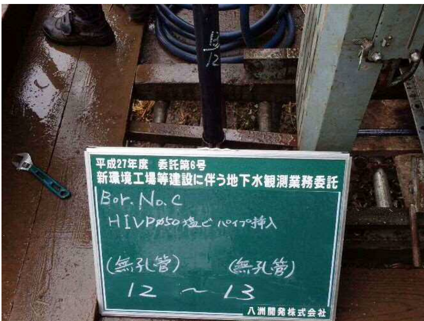
No. C HIVP φ 50塩ビパイプ挿入 (無孔管) (無孔管) 12 ~ 13
