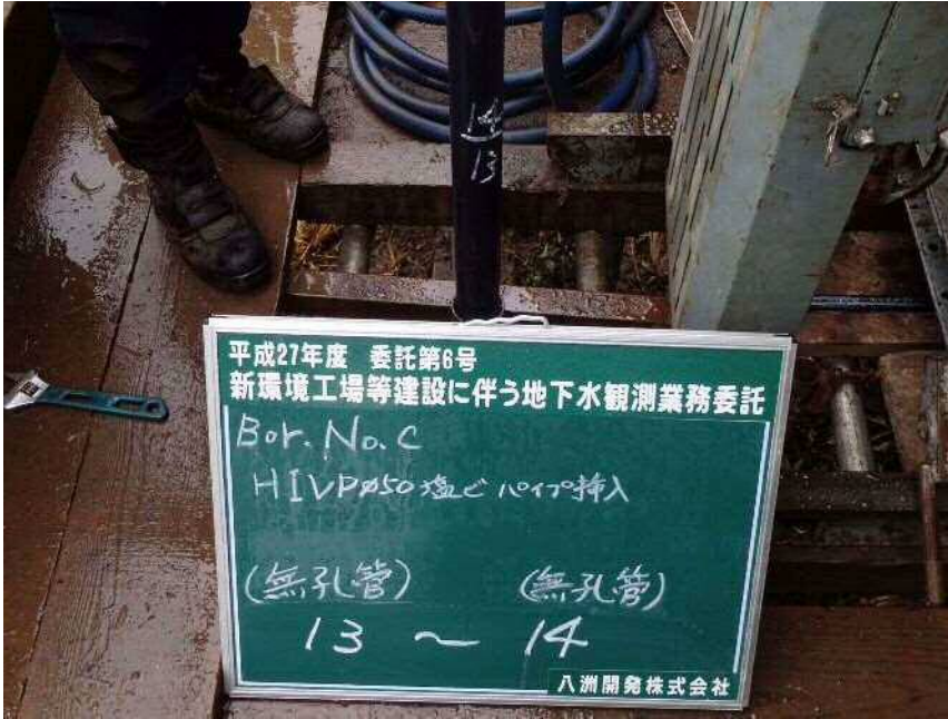
No. C HIVPφ50塩ビパイプ挿入 (無孔管) (無孔管) 13 ~ 14
