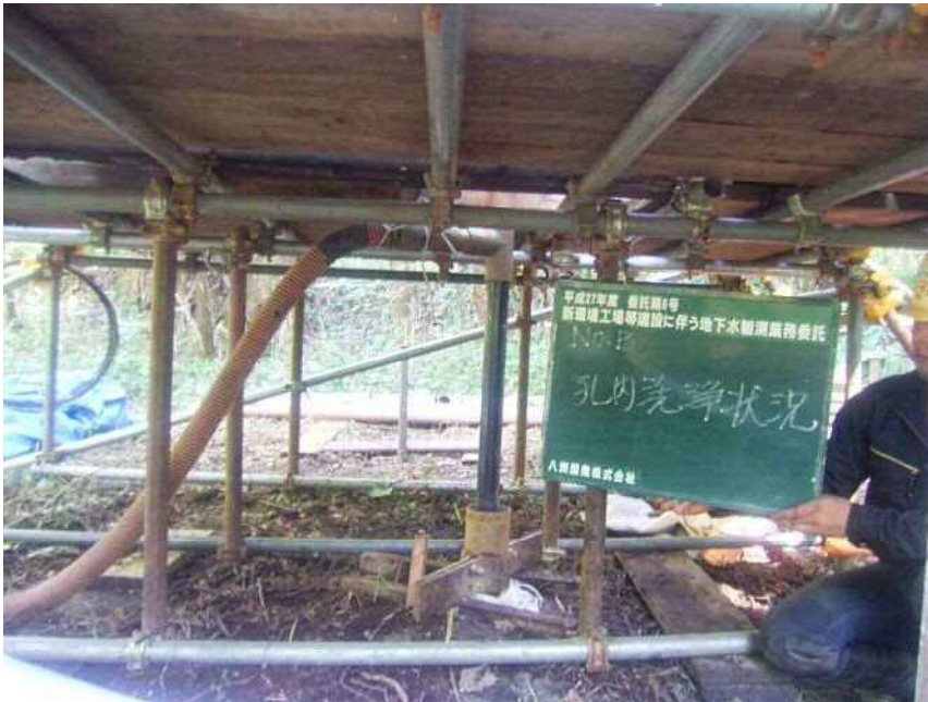
No. B 孔内洗浄状況
