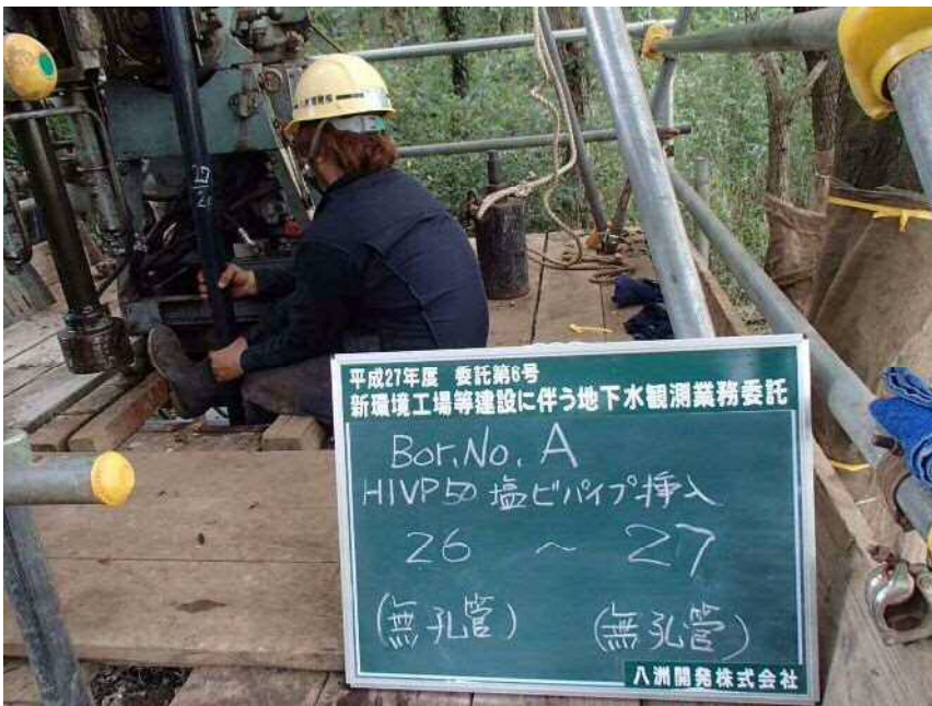
No. A HIVPφ50塩ビパイプ挿入 (無孔管) (無孔管) 26 ~ 27
