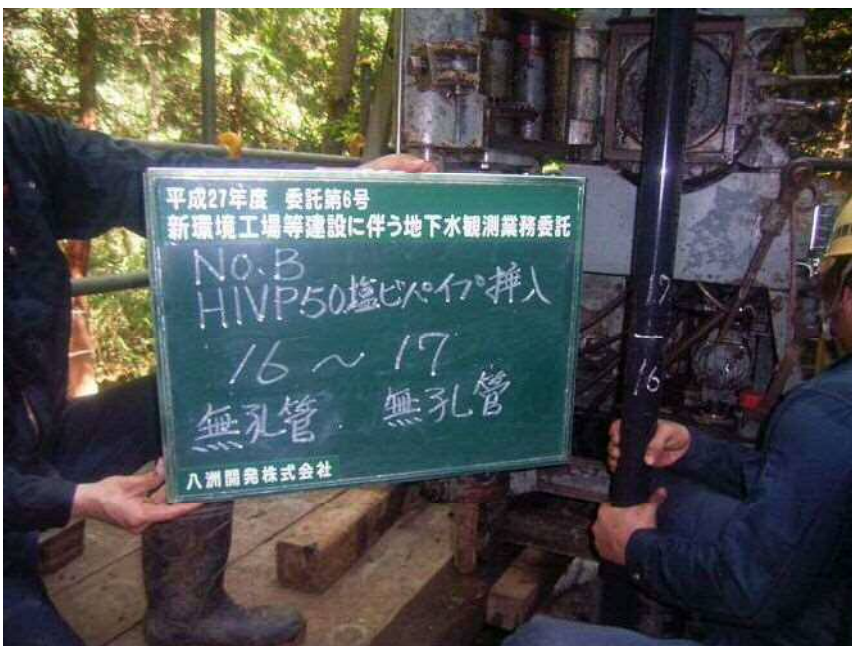
No. B HIVP φ 50塩ビパイプ挿入 (無孔管) (無孔管) 16 ~ 17
