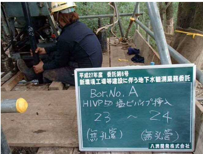
No. A HIVPφ50塩ビパイプ挿入 (無孔管) (無孔管) 23 ~ 24
