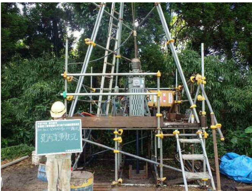
No. C 孔内洗浄状況
