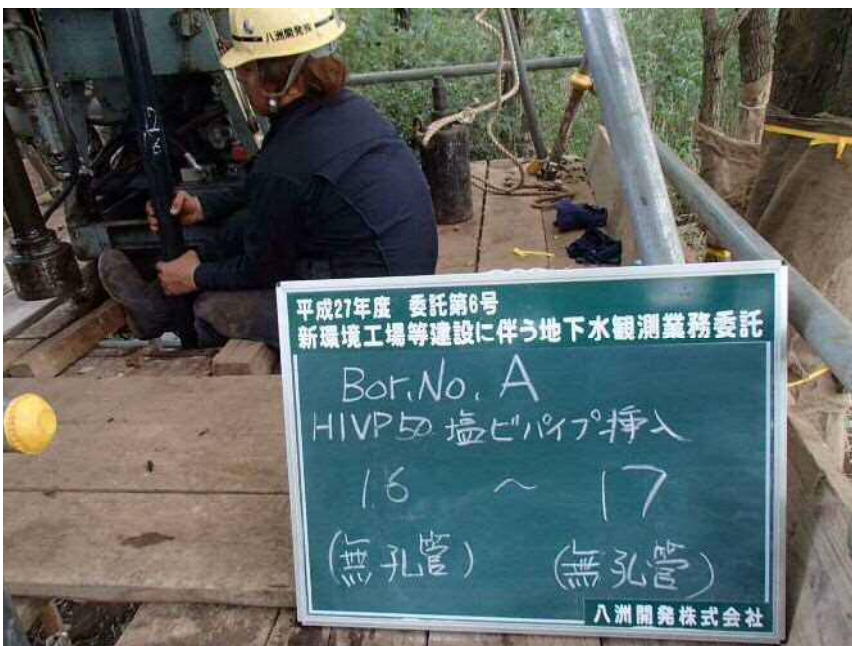
No. A HIVPφ50塩ビパイプ挿入 (無孔管) (無孔管) 16 ~ 17
