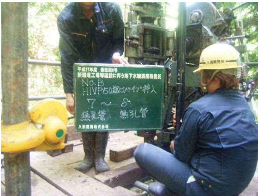
No. B HVPφ50塩ビパイプ挿入 (無孔管) (無孔管) 7 ~ 8
