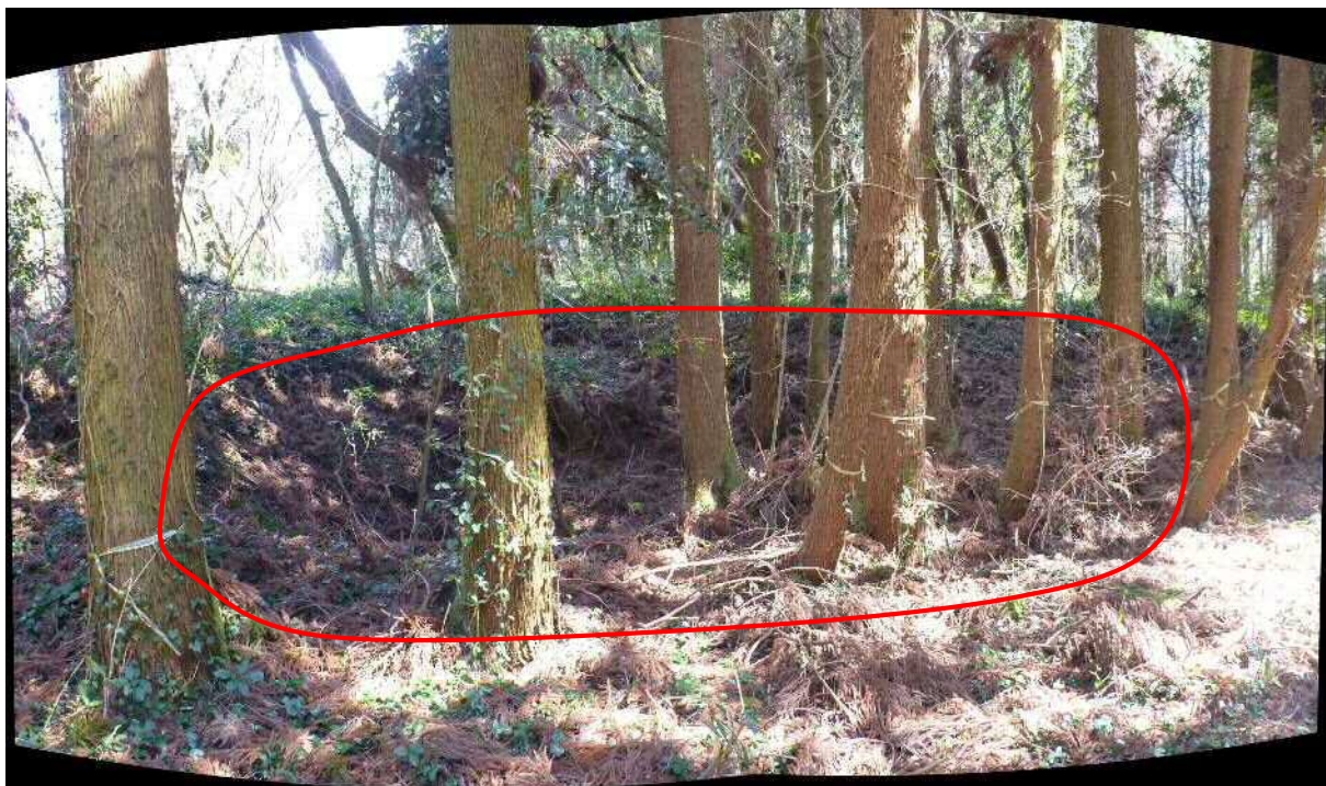
写真 5. 8. 2 ドリーネと思われる陥没地形①
