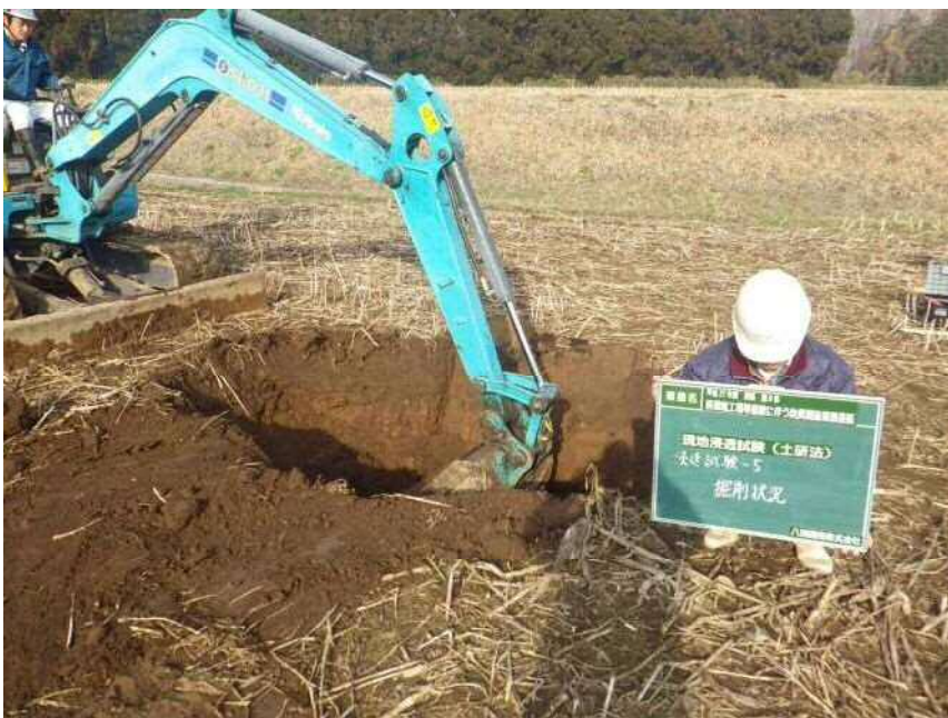
現地浸透試験(土研法)
