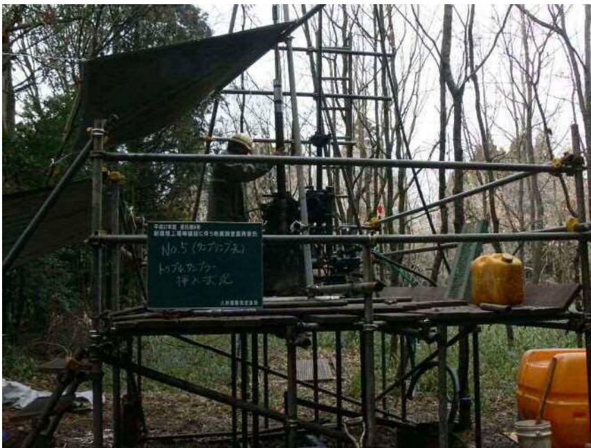
No. 5 (サンプリング孔) 挿入状況
