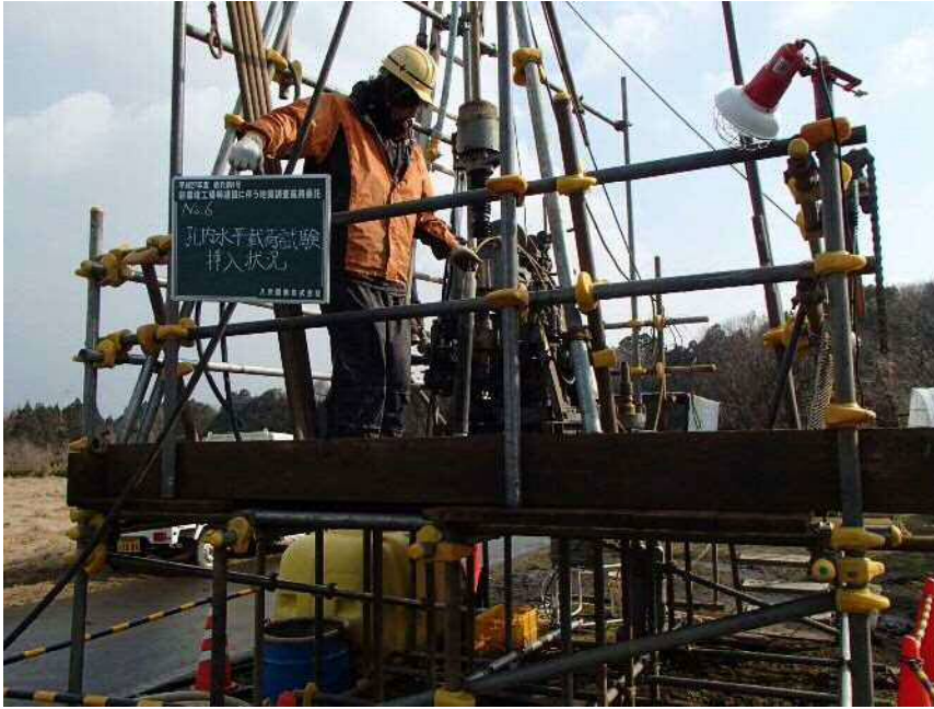
No. 6 孔内水平載荷試験 挿入状況
