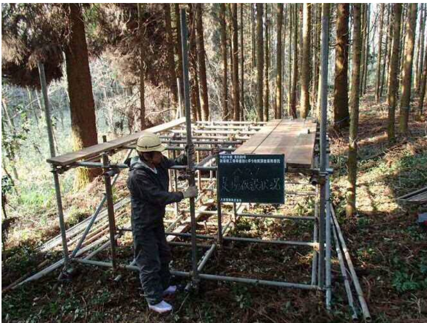
No. 9 足場仮設状況
