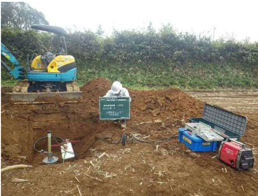
現地浸透試験(土研法)
