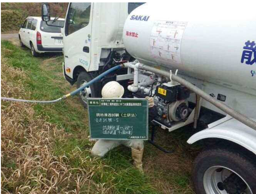
現地浸透試験(土研法)
