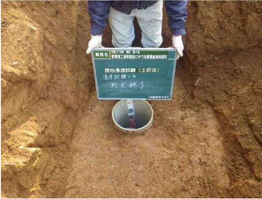
現地浸透試験(土研法)
