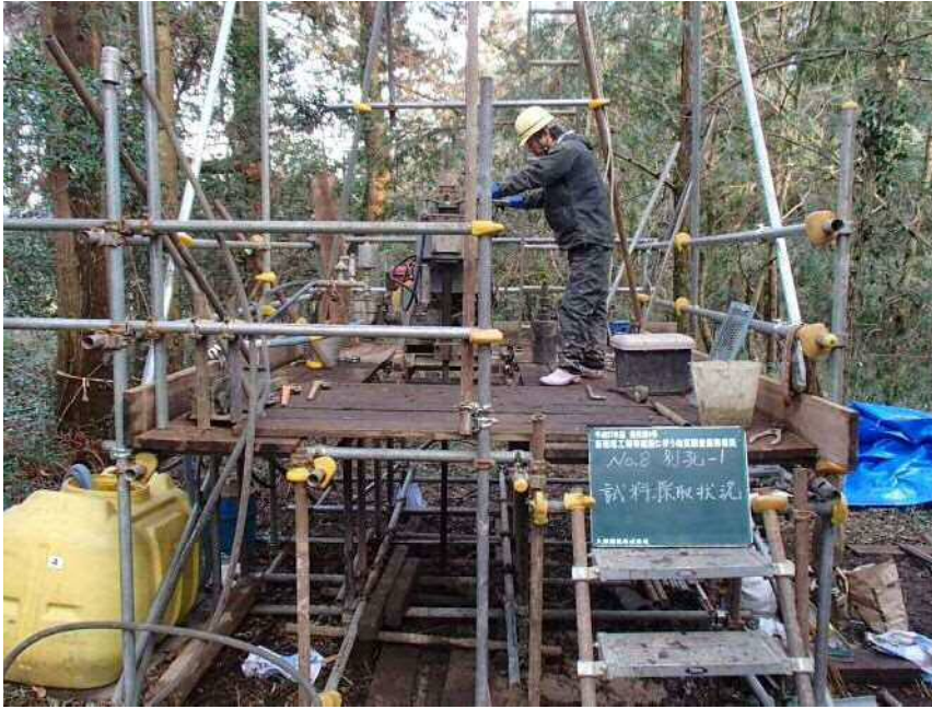
No. 8 別孔-1 試料採取状況
