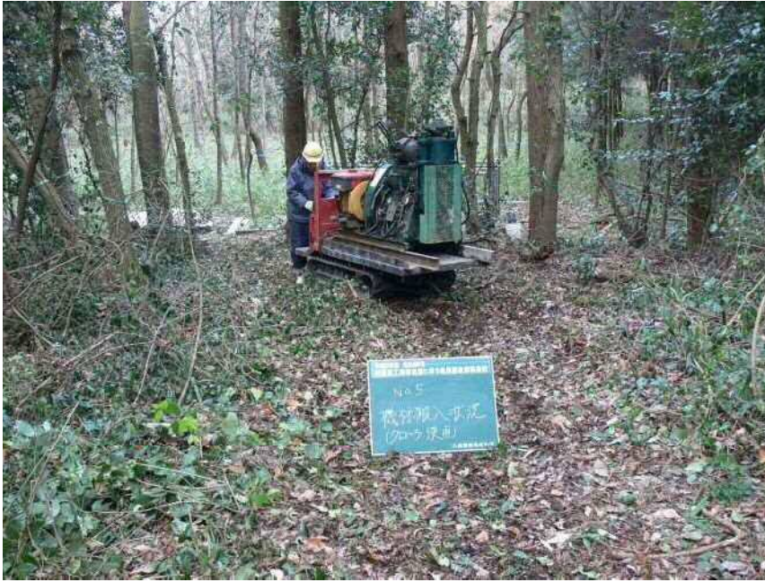
No. 5 機材搬入状況 (クローラ使用)
