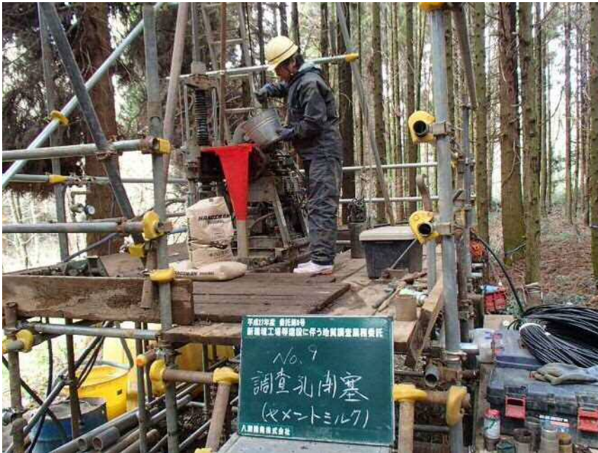
No. 9 調査孔閉塞(セメントミルク)
