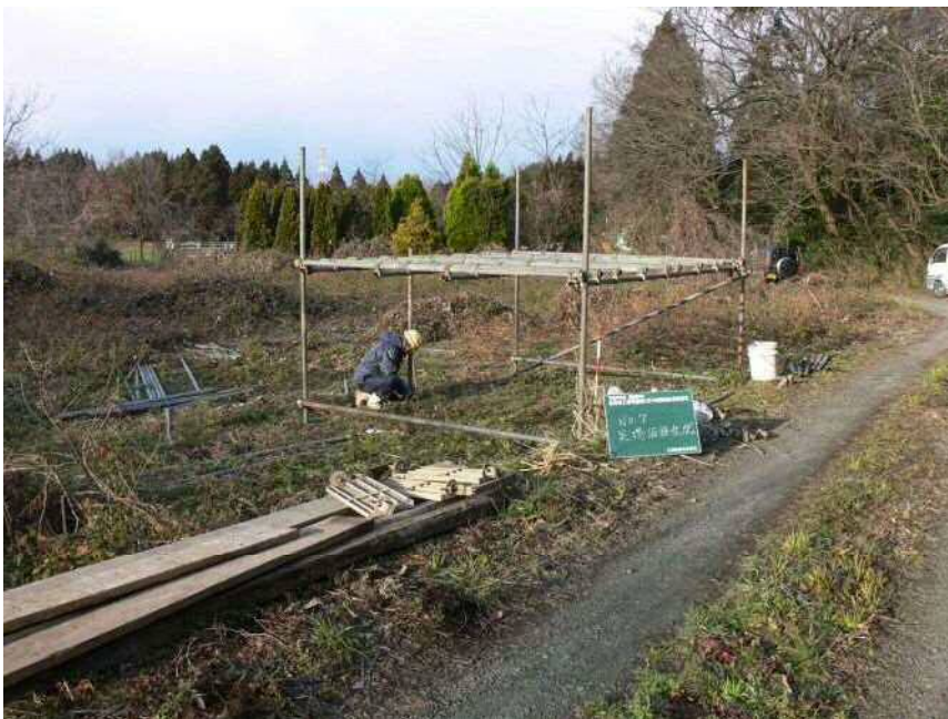
No. 7 足場仮設状況
