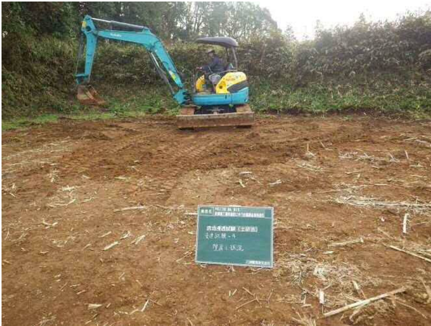
現地浸透試験(土研法)
