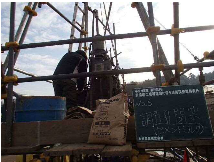
No. 6 調査孔閉塞(セメントミルク)
