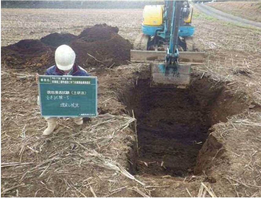
現地浸透試験(土研法)
