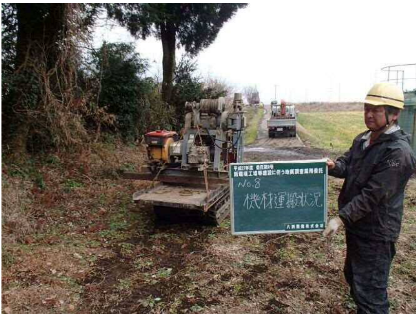
No. 8 機材運搬状況
