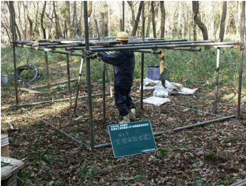
No. 5 足場仮設状況
