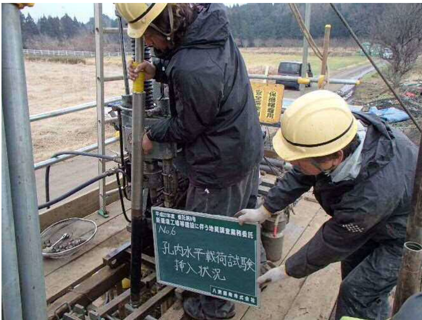
No. 6 孔内水平載荷試験 挿入状況
