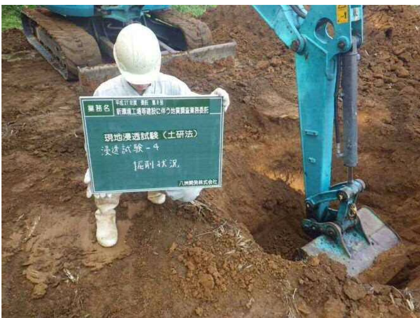
現地浸透試験(土研法)
