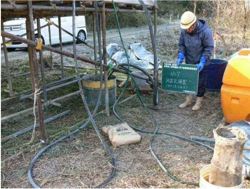
No. 7 調査孔閉塞(セメントミルク)
