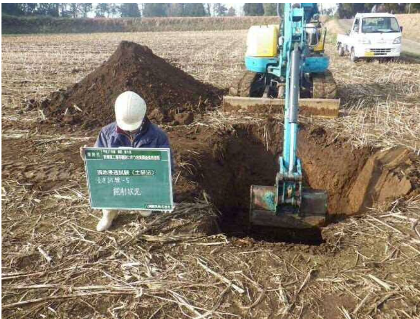
現地浸透試験(土研法)
