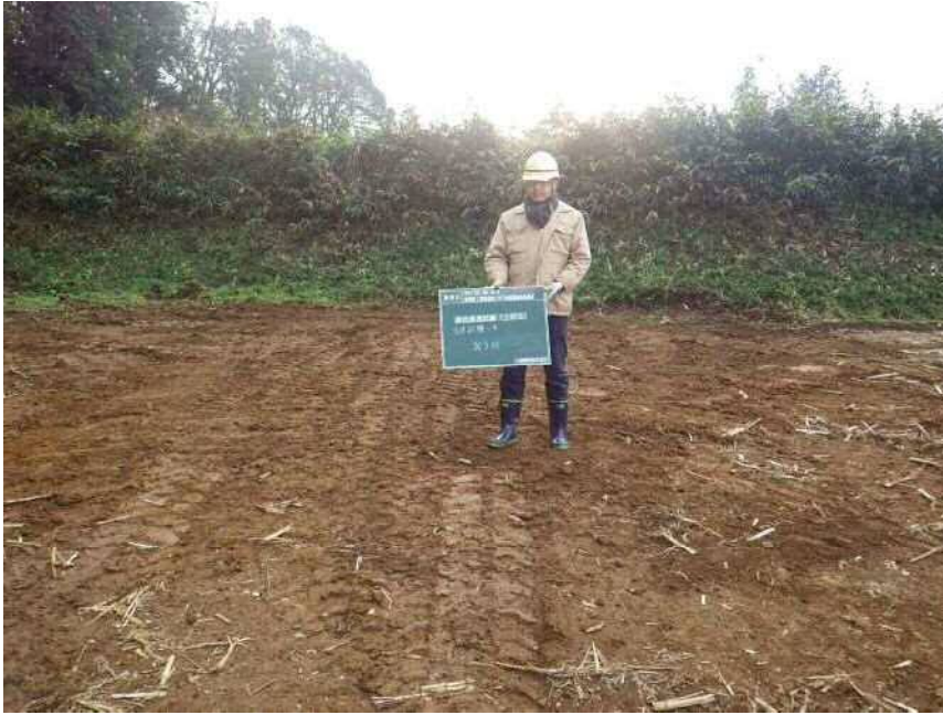
現地浸透試験(土研法)
