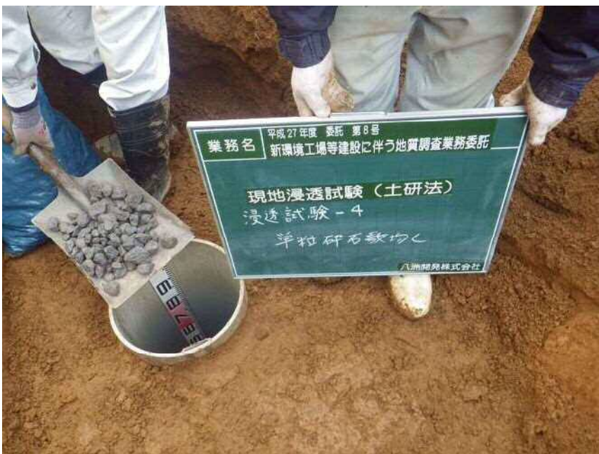
現地浸透試験(土研法)
