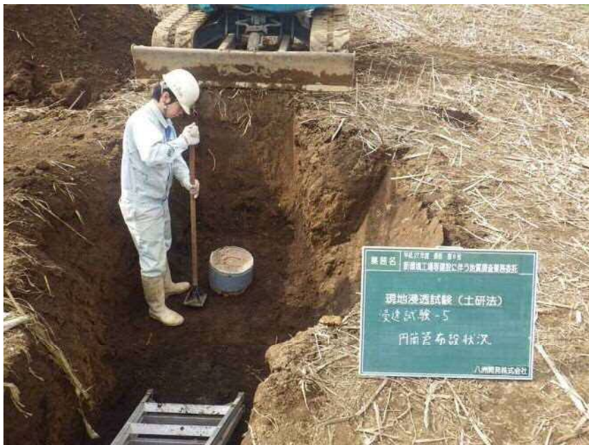
現地浸透試験(土研法)
