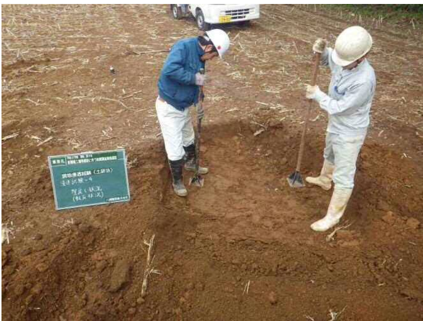
現地浸透試験(土研法)
