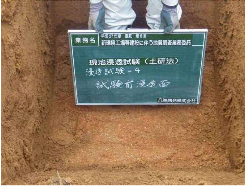
現地浸透試験(土研法)
