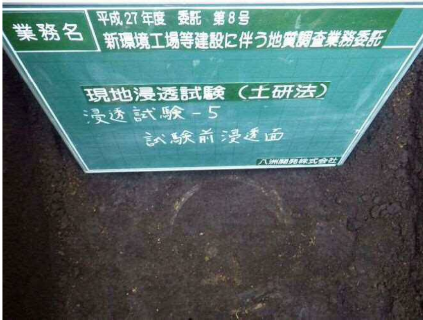
現地浸透試験(土研法)
