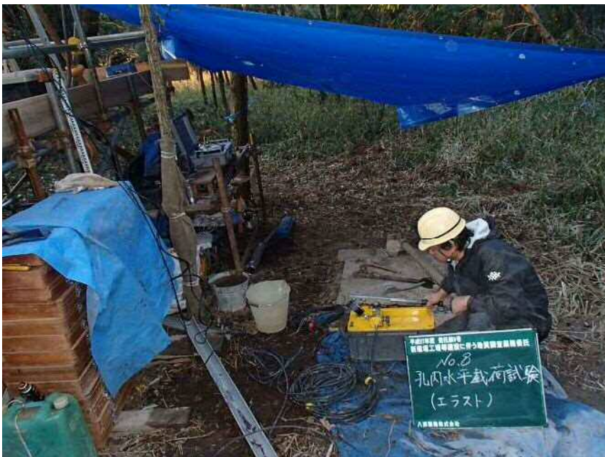
No. 8 孔内水平載荷試験 (エラストメーター)
