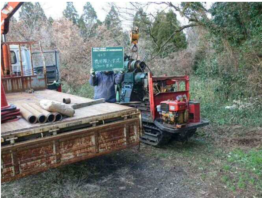
No. 5 機材搬入状況 (クローラ使用)
