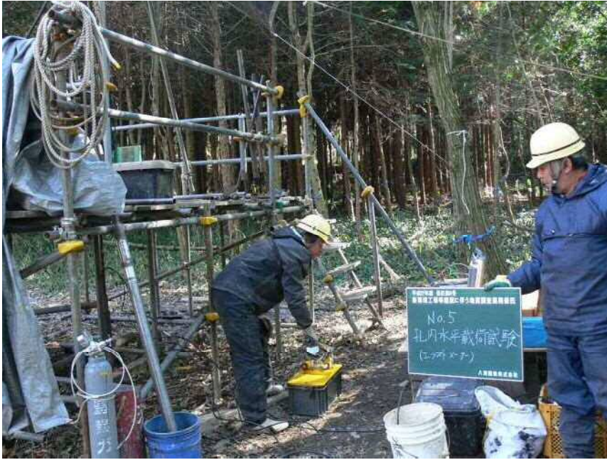
No. 5 孔内水平載荷試験 (エラストメーター)
