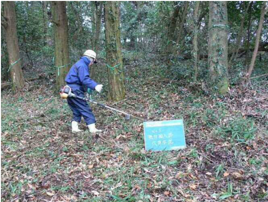
No. 5 伐採状況
