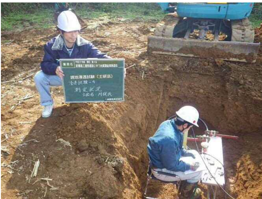
現地浸透試験(土研法)
