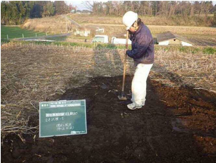
現地浸透試験(土研法)
