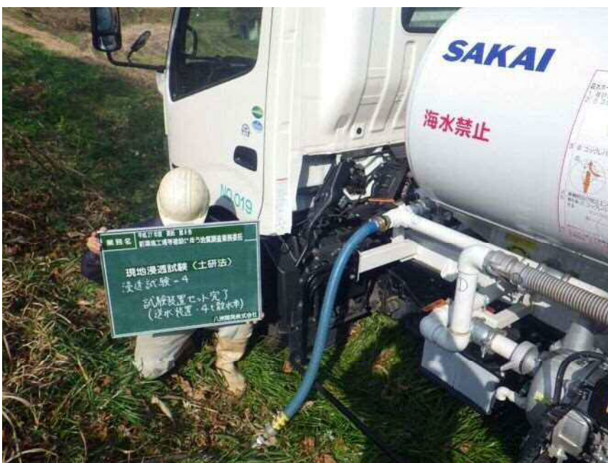
現地浸透試験(土研法)
