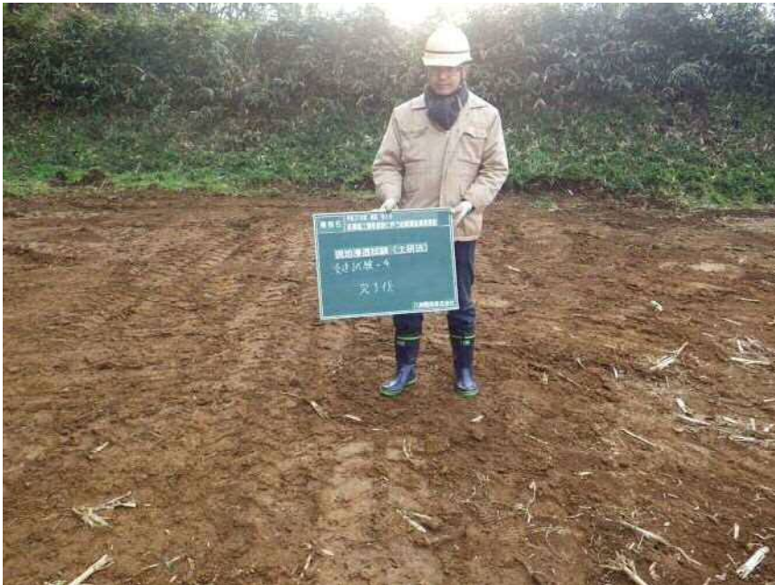
現地浸透試験(土研法)
