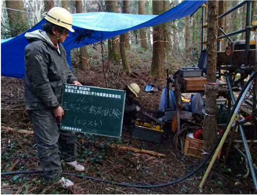
No. 9 孔内水平載荷試験 (エラストメーター)
