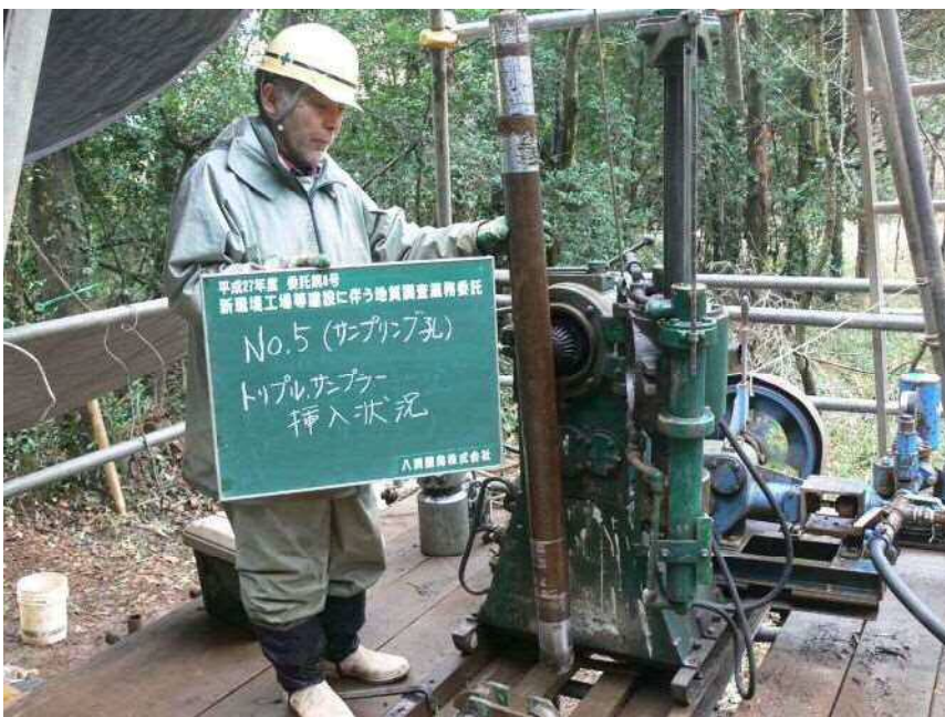
No. 5 (サンプリング孔) 挿入状況
