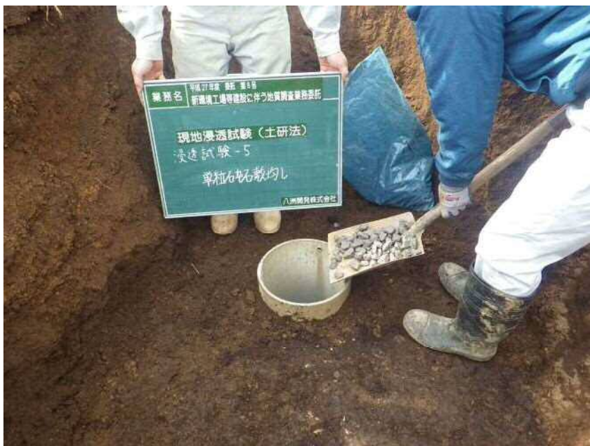
現地浸透試験(土研法)
