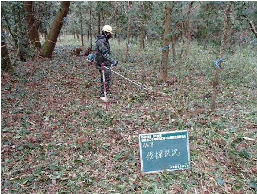
No. 8 伐採状況
