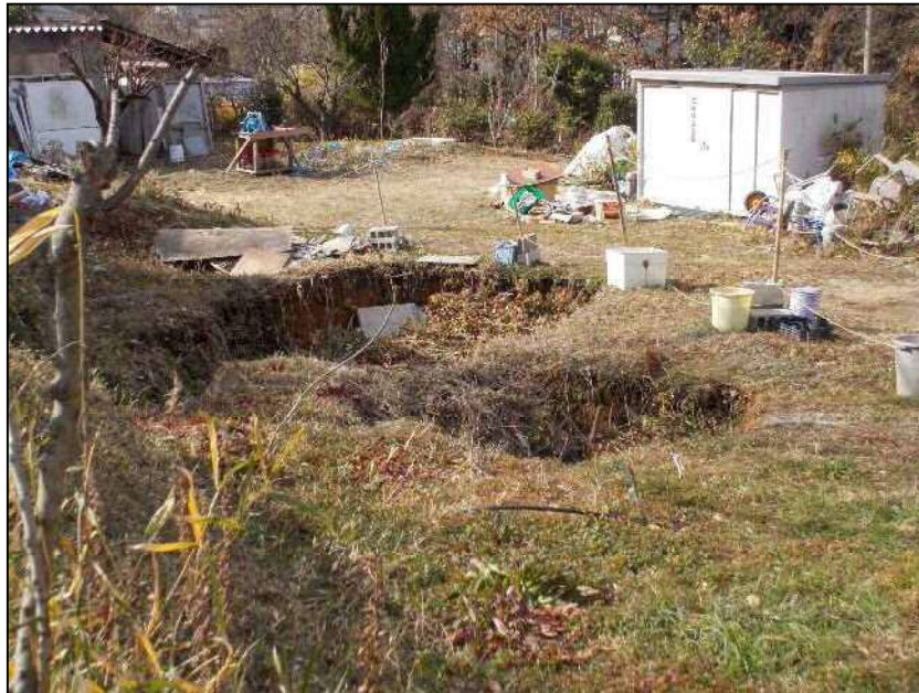
写真 5.1 地表の陥没状況
