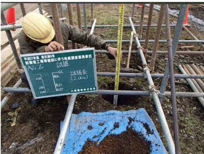
No. 6 試掘 試掘長 GL=2.00m
