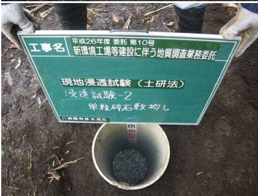
現場浸透試験(土研法)2 単粒碎石敷き均し
