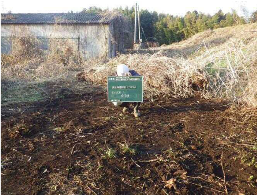
現場浸透試験(土研法)1 完了後
