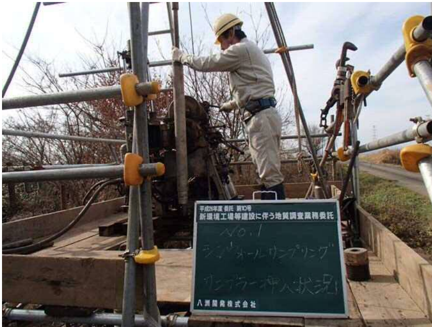
No1 シンウォールサンプリング サンプラー挿入状況
