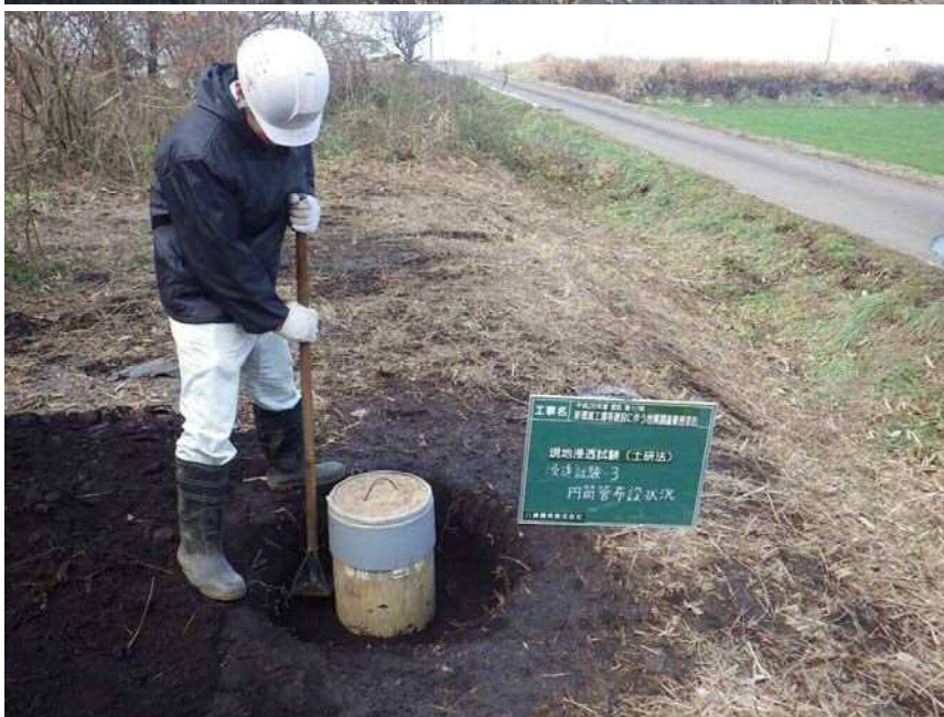
現場浸透試験(土研法)3
