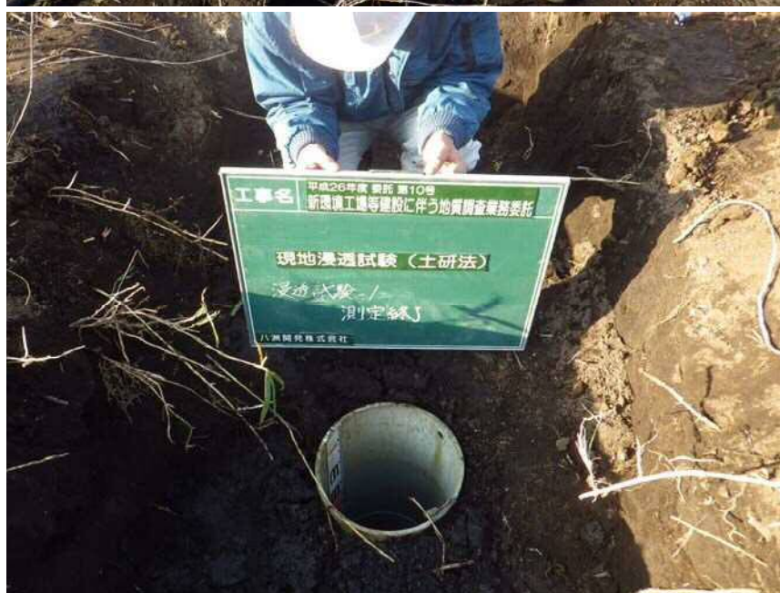
現場浸透試験(土研法) 1
