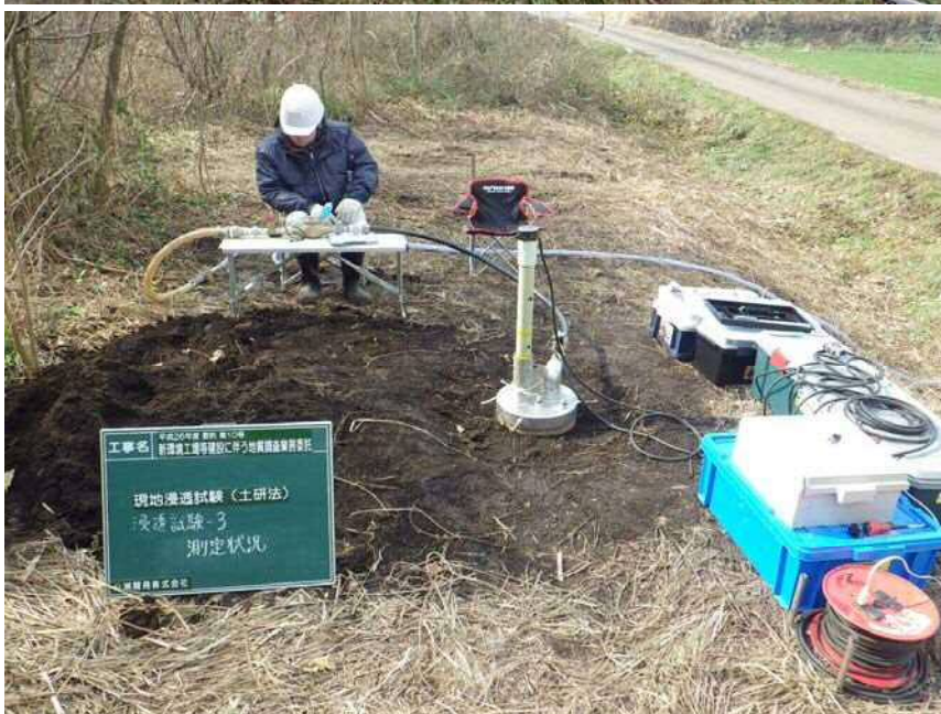
現場浸透試験(土研法)3 測定状況
