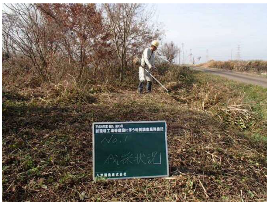
No1 伐採状況
