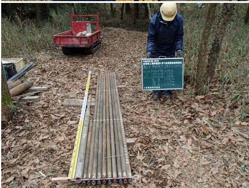
No4 ロッド検尺 全長=29.80m 残尺= 2.80m 深度=27.00m
