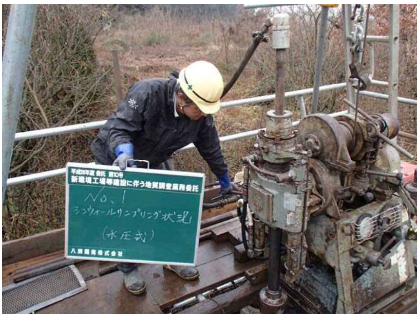
No1 シンウォールサンプリング状況 水圧式
