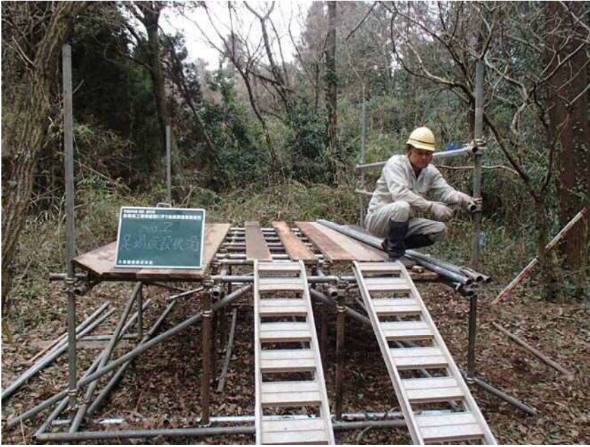
No2 足場仮設状況
