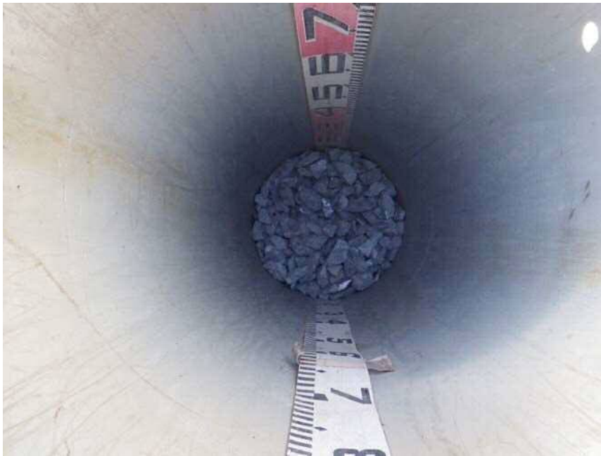
現場浸透試験(土研法)1 単粒碎石敷き均し
