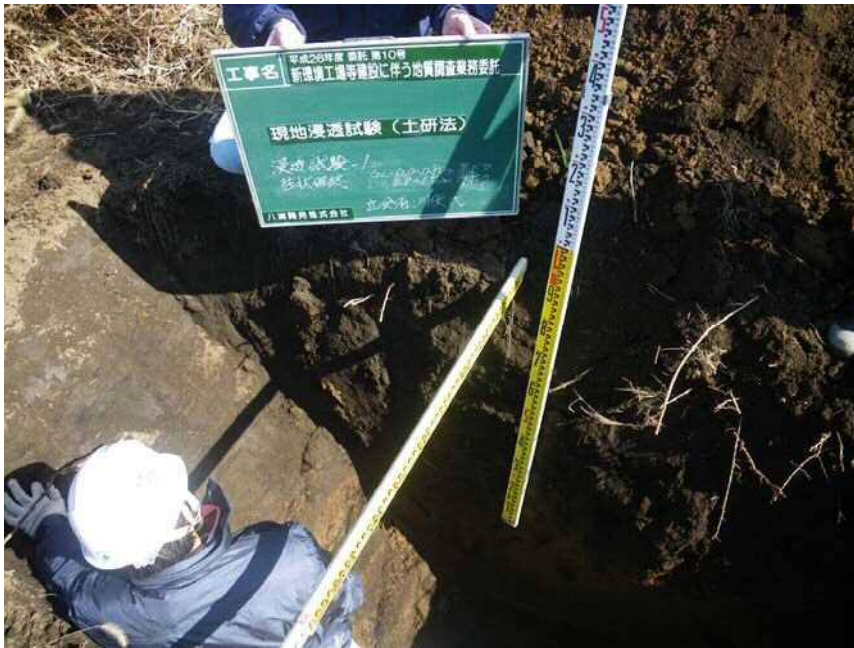
現場浸透試験(土研法)1
