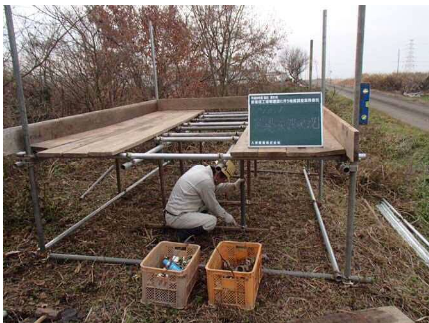
No1 足場仮設状況
