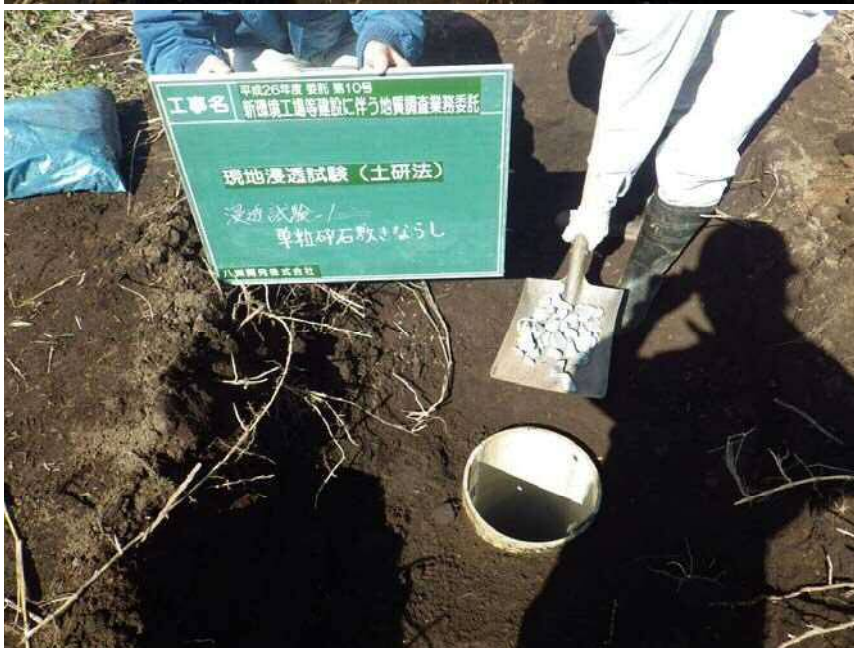
現場浸透試験(土研法)1
