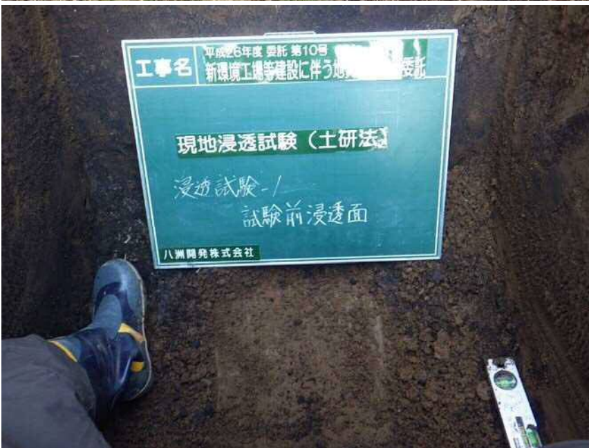
現場浸透試験(土研法)1 試験前浸透面
