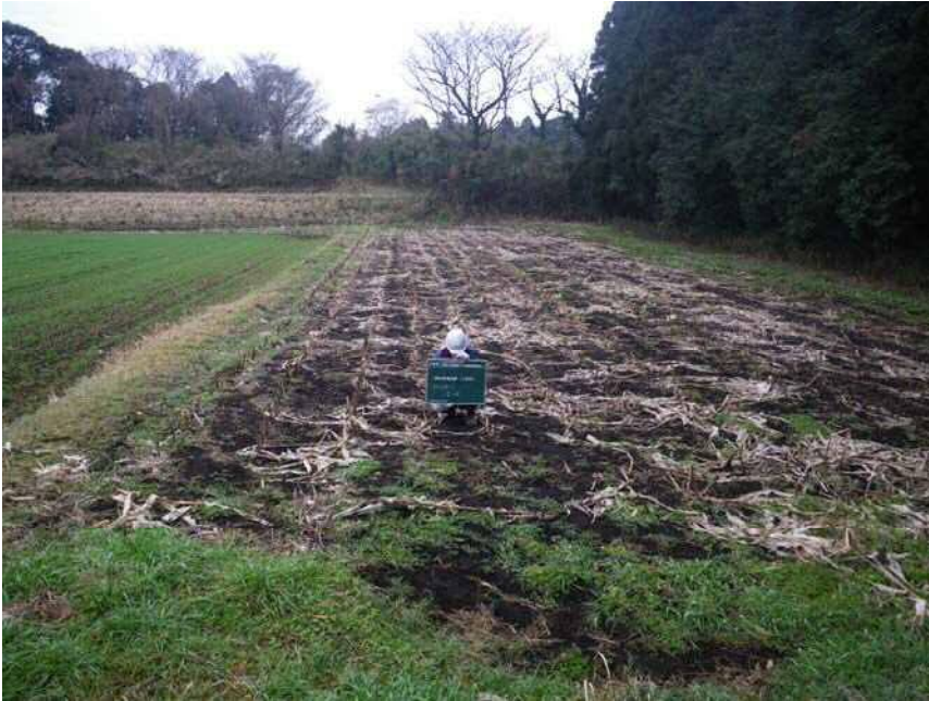
現場浸透試験(土研法)2 着工前
