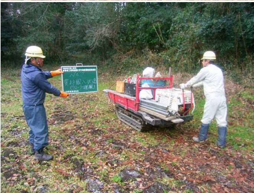
No4 資材搬入状況 クローラ運搬
