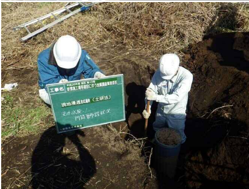
現場浸透試験(土研法)1
