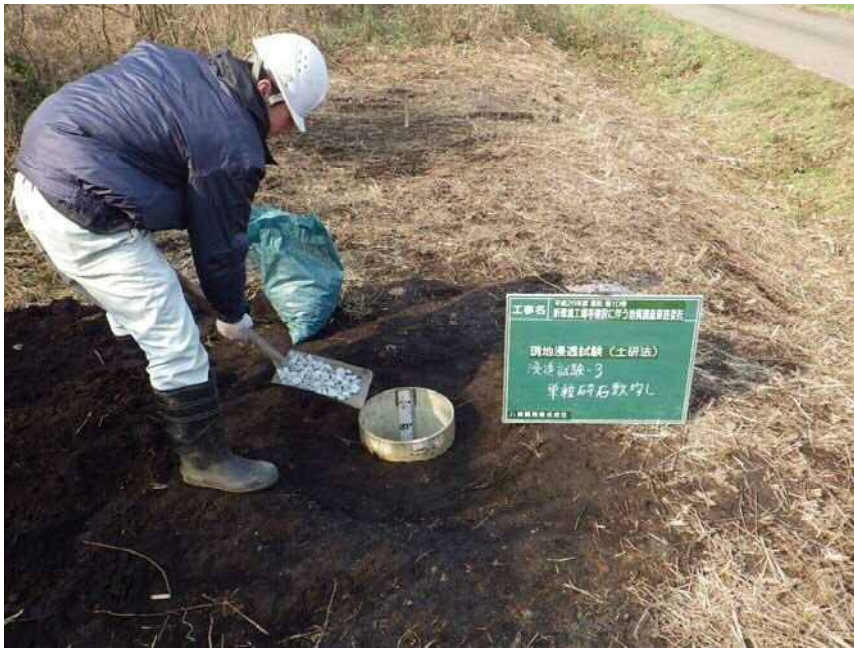
現場浸透試験(土研法)3 単粒碎石敷き均し
