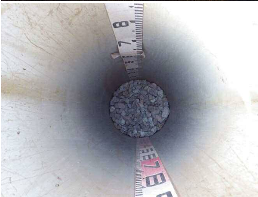
現場浸透試験(土研法)3 単粒碎石敷き均し
