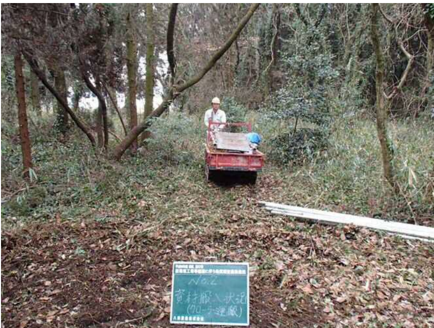
No2 資材搬入状況 クローラ運搬
