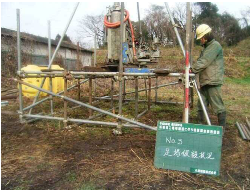
No3 足場仮設状況
