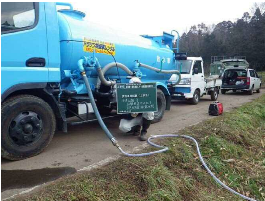
現場浸透試験(土研法)3 試験装置セット完了 送水装置、4 t 散水車
