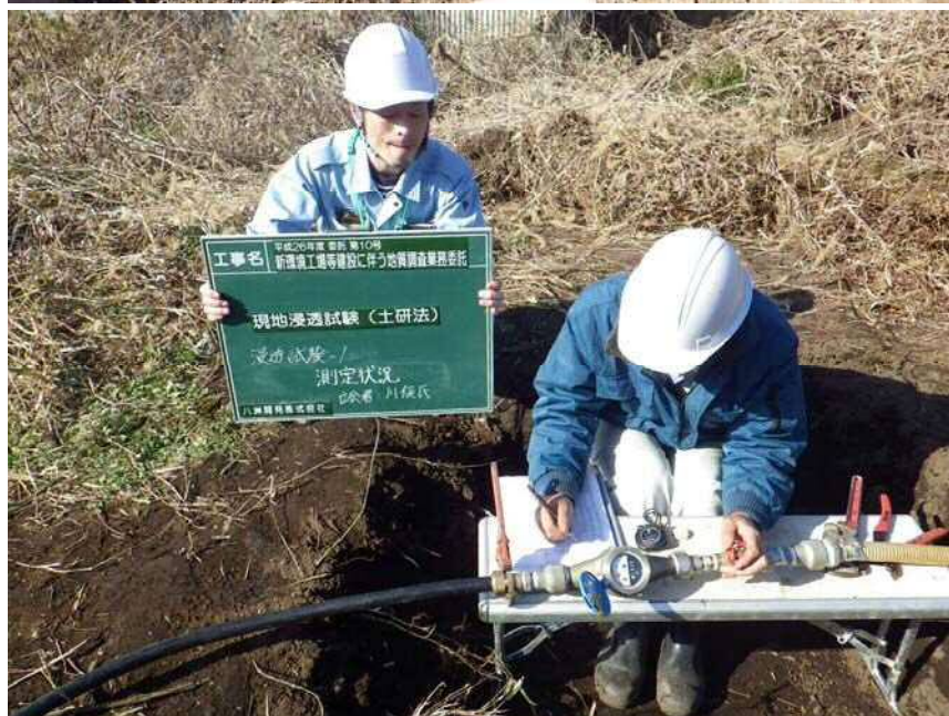
現場浸透試験(土研法) 1
