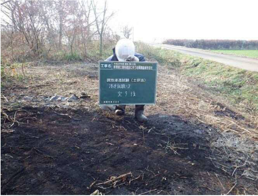
現場浸透試験(土研法)3 完了後
