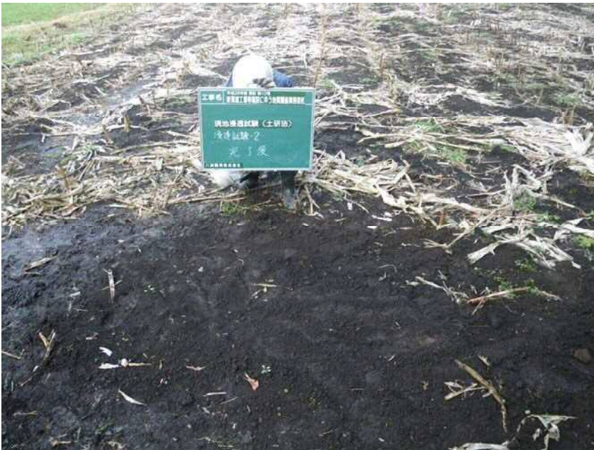
現場浸透試験(土研法)2 完了後
