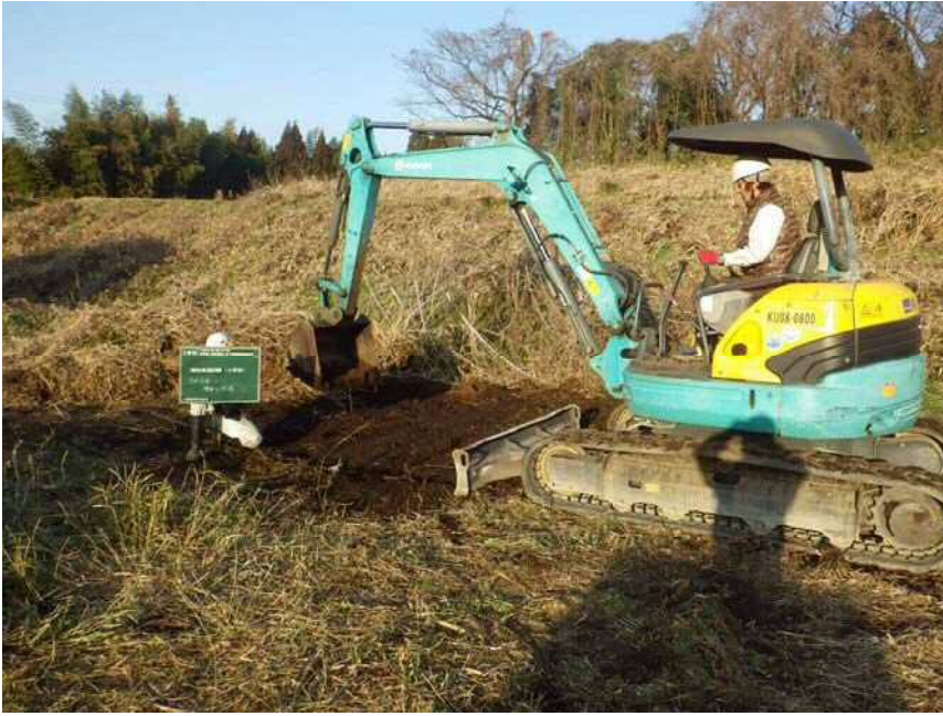
現場浸透試験(土研法)1 埋戻し状況
