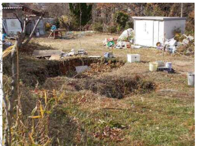
写真 5.6.1 地表の陥没状況
