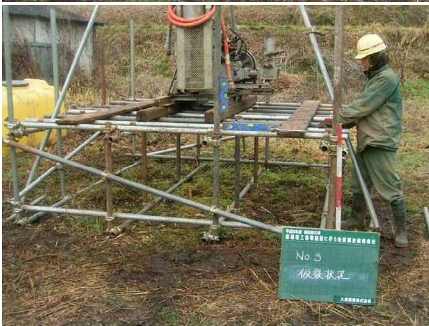
No3 仮設状況
