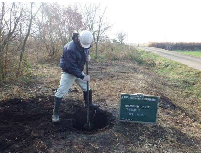
現場浸透試験(土研法)3 埋戻し状況
