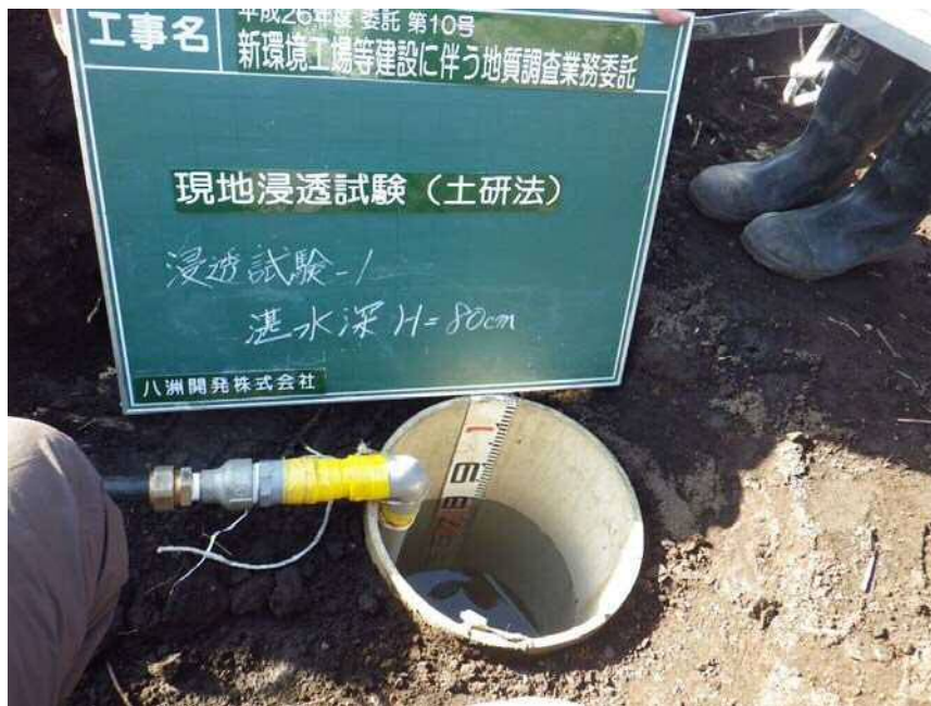
現場浸透試験(土研法) 1
