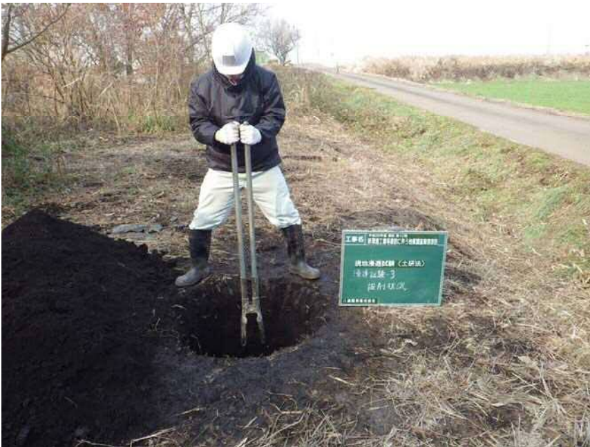
現場浸透試験(土研法)3 掘削状況
