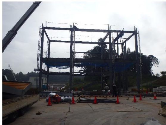
見学者EV棟工事
