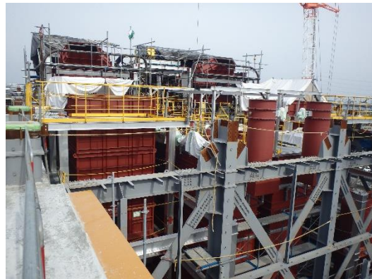
排ガス処理機械据付工事
