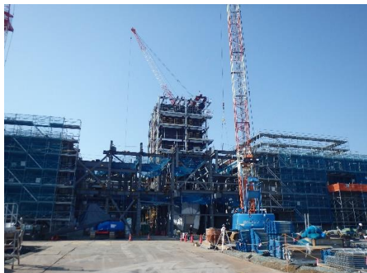
工場棟の鉄骨工事を行っています。
