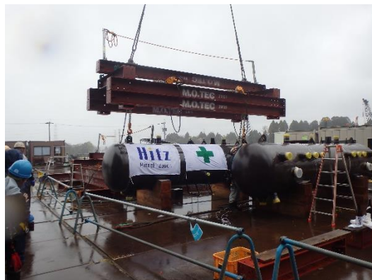
ボイラドラムの取り込みを行っています。
