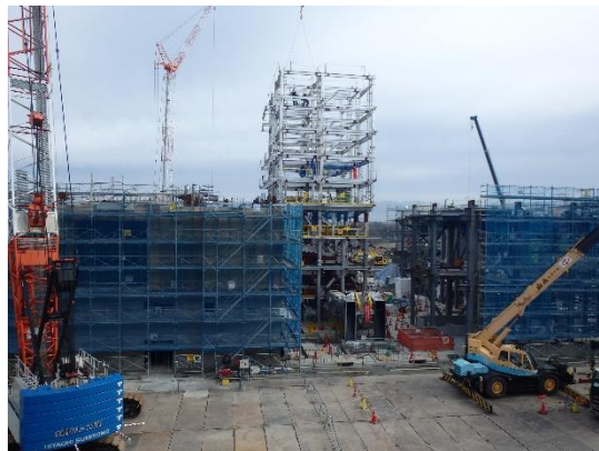
ボイラ鉄骨の建方を行っています。
