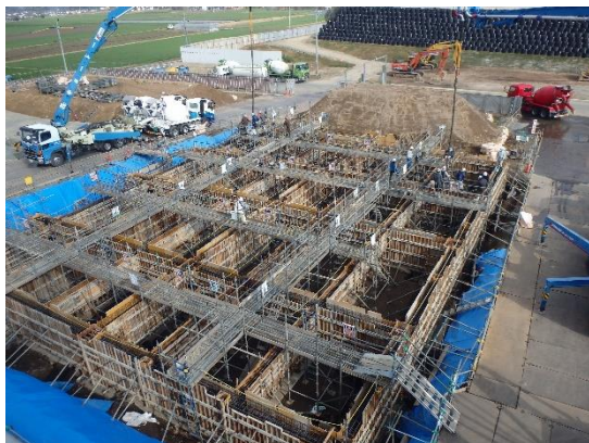
管理棟の基礎の型枠工事を行っています。
