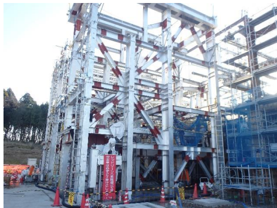
プラント工事
