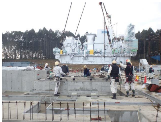
プラント工事
