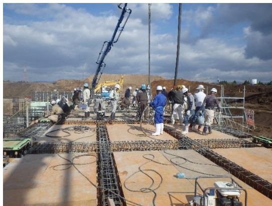
コンクリート打設工事
