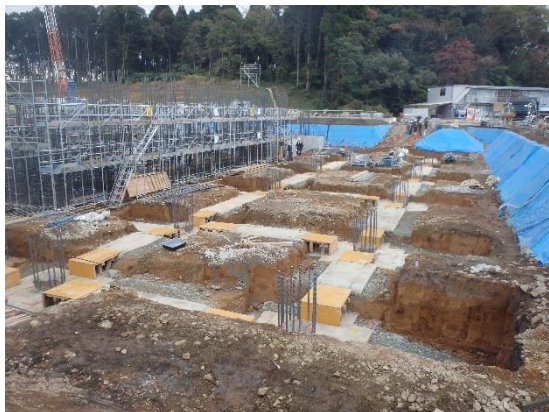
配筋・型枠工事
