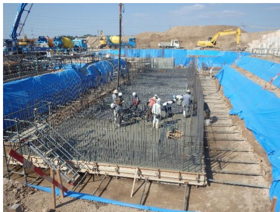
コンクリート打設工事
