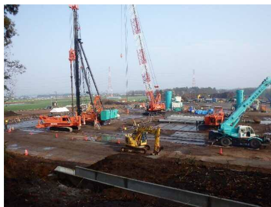
杭の打設作業を行っています。
